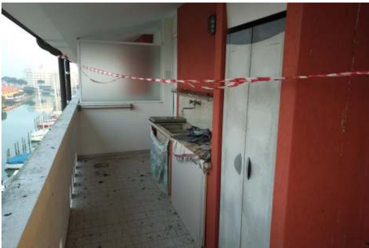
Foto n. 17 – Terrazzo rivolto a nord.
