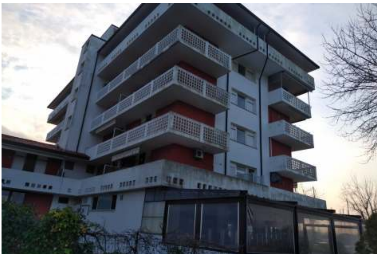
Foto n. 4 – Condominio (lato Nord).
