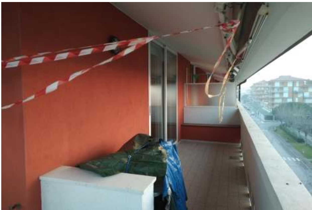
Foto n. 19 – Terrazzo: porzione rivolta ad ovest.
