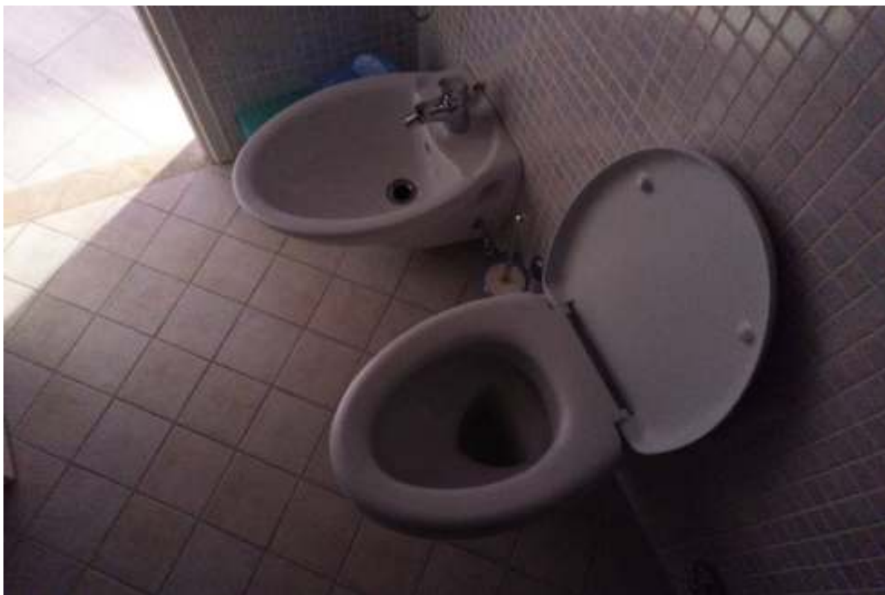
Foto n. 14 – Bagno. In dettaglio i sanitari.
