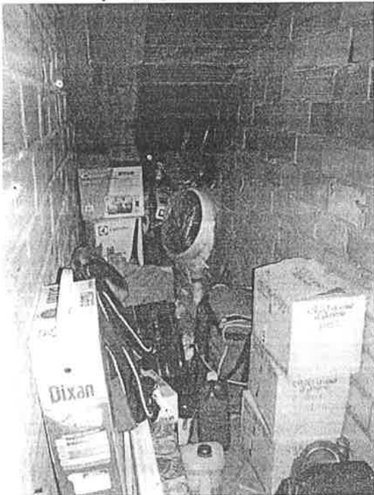
Particolare locale sottotetto
