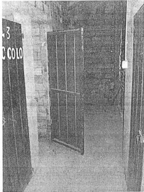
Ingresso locale sottotetto
