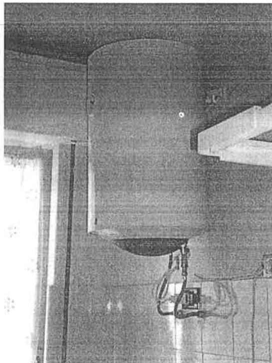
Boiler elettrico
