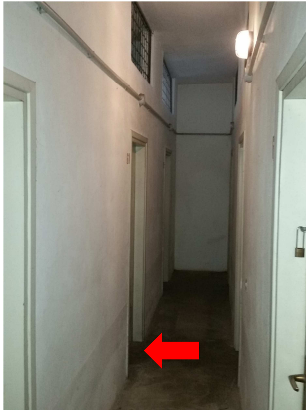
Corridoio che conduce alla cantina oggetto della presente procedura
