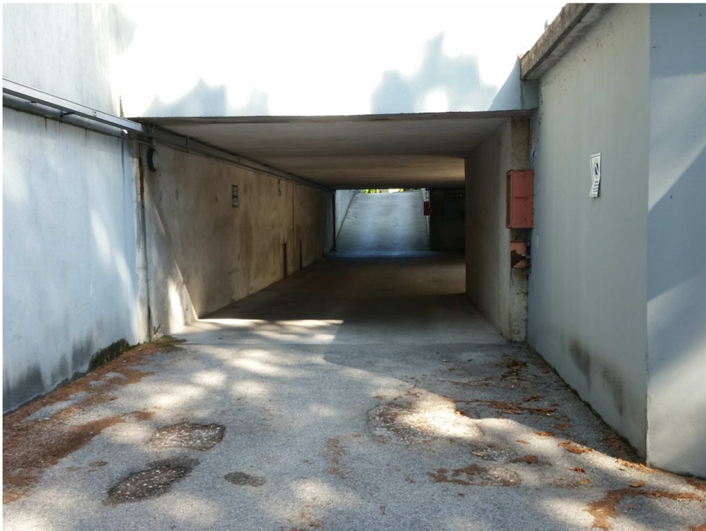
Corsello di manovra con nel fondo la rampa di accesso allo stesso
