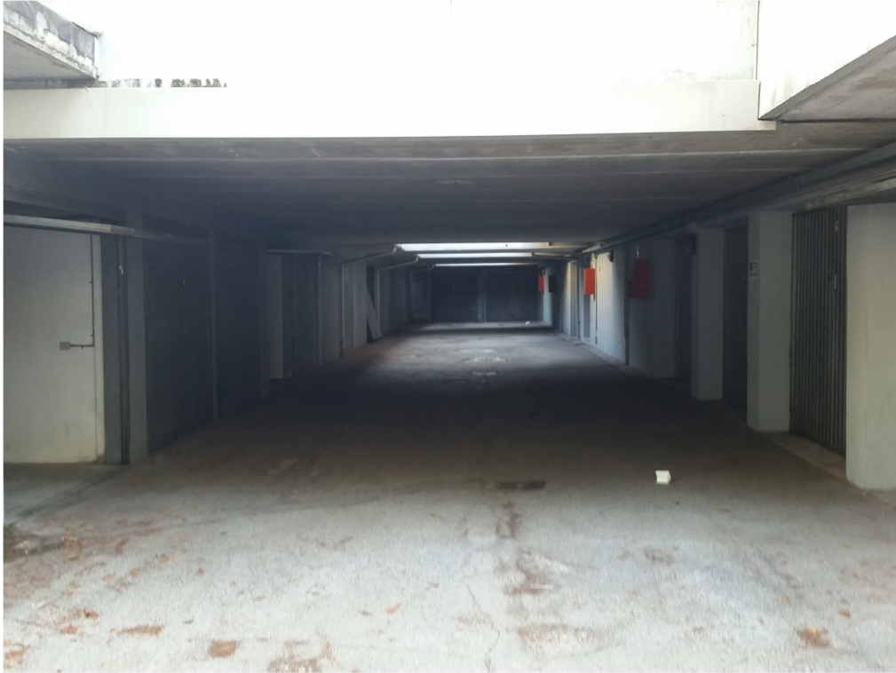
Corsello di manovra che conduce al garage
