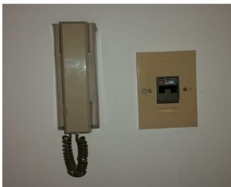
Locale nr.1 – Viste ingresso - particolare
