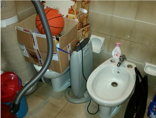
Locale nr.5 – viste interne del bagno
