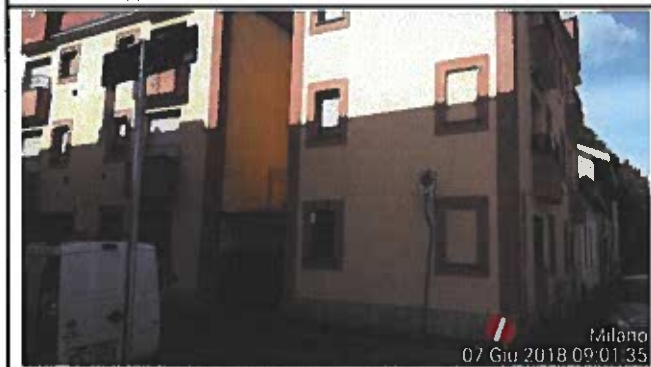
Appartamento in via Fracastoro, 25 Milano - cancello ingresso
