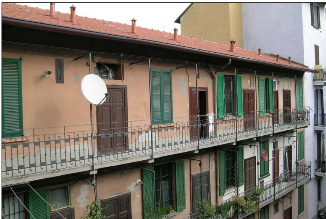
Foto 1 - vista dell'edificio, piani primo e secondo
