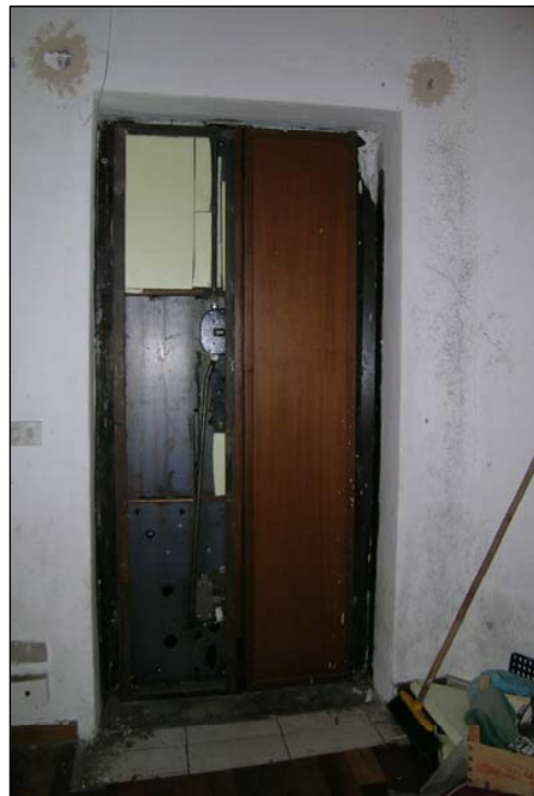
Foto 15 - portoncino di ingresso
