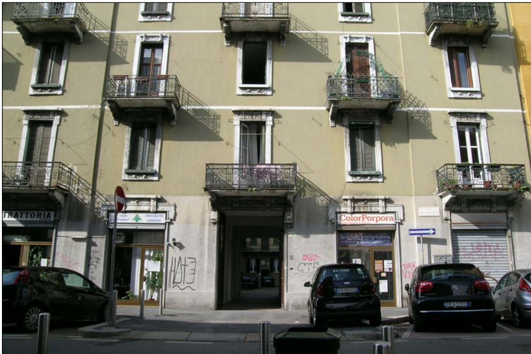
Foto 6 - accesso edificio su Via Accademia
