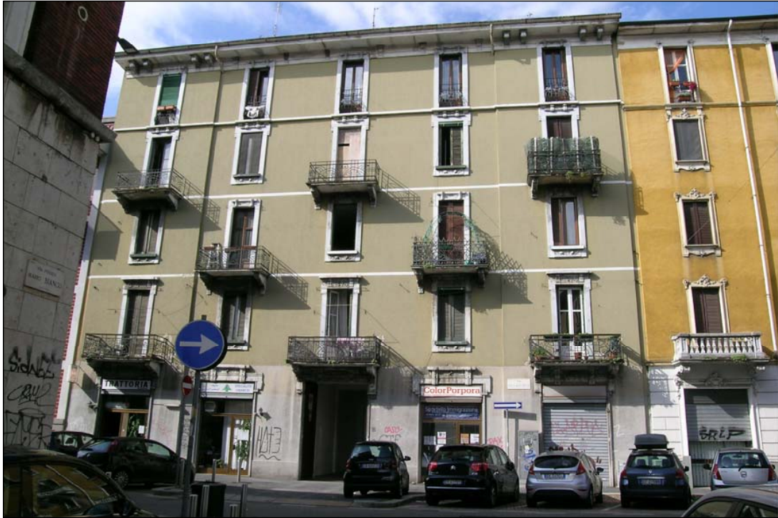
Foto 5 - facciata edificio su Via Accademia
