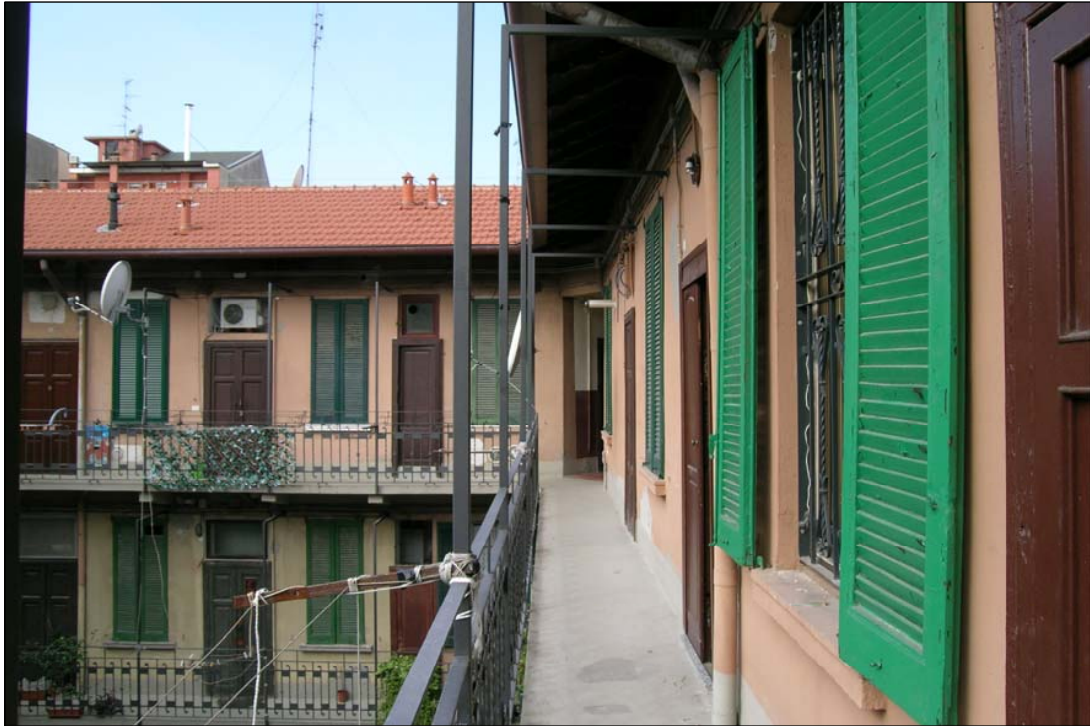
Foto 3 - vista del ballatoio verso ovest
