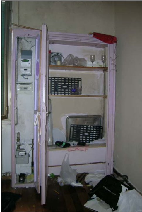
Foto 12 - Tamponamento porta con tubazioni gas
