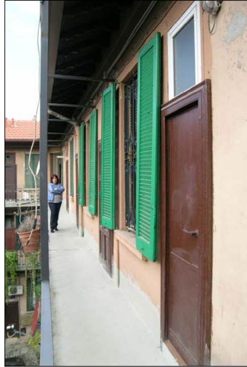
Foto 8 - Ballatoio di accesso all'appartamento
