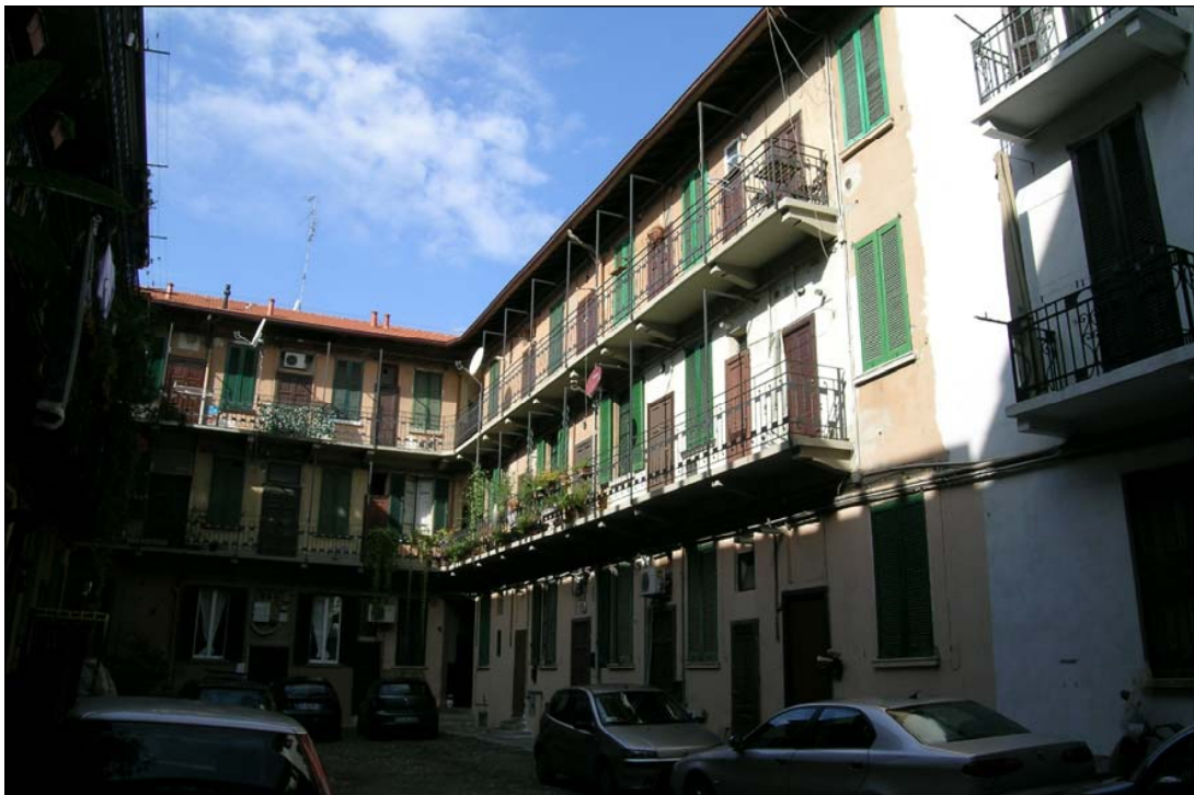
Foto 4 - vista ovest della corte
