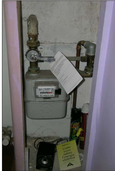
Foto 13 - contatore gas
