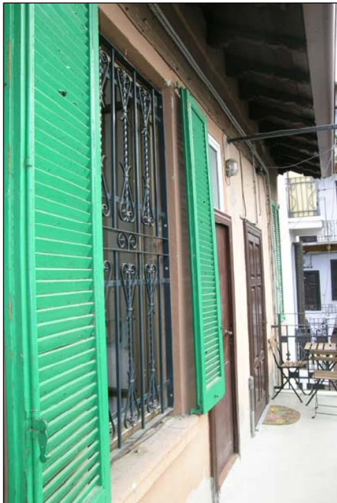
Foto 9 - controcampo ballatoio di accesso
