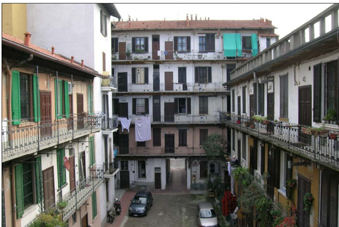
Foto 2 - vista est della corte
