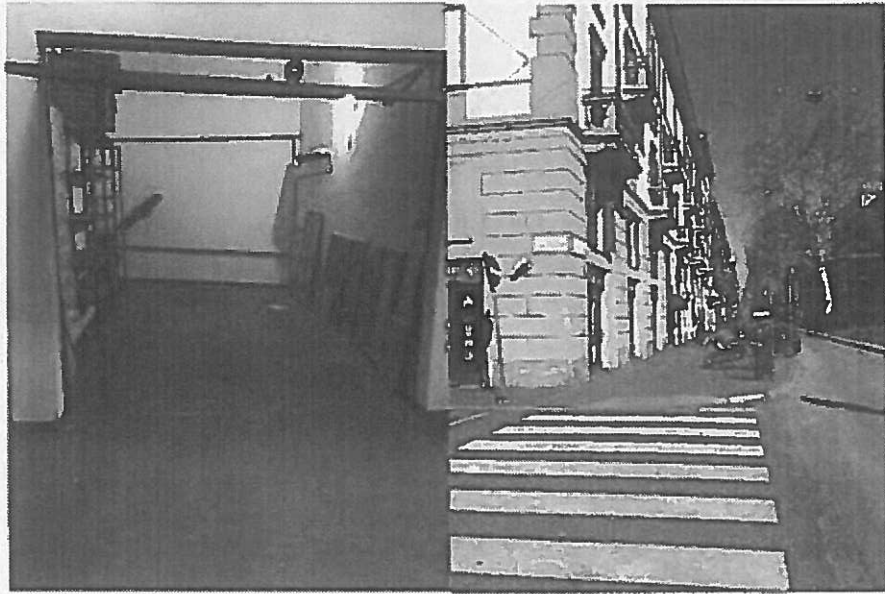
Garage e accesso
