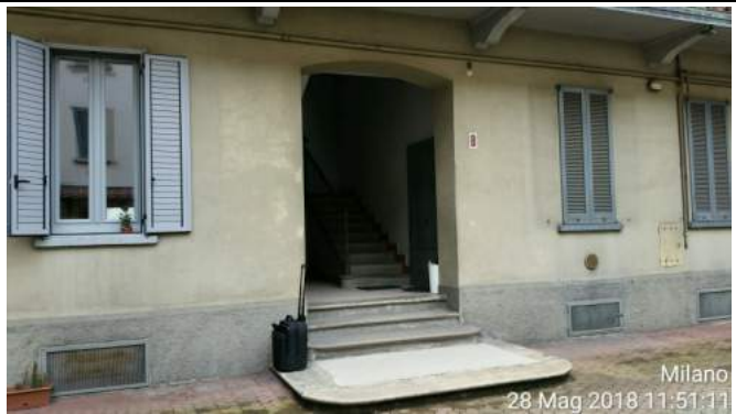
Milano 28 Mag 2018 11:51:11 Appartamento in via A. Mambretti 29 scala B Milano - accesso al corpo di scala B
