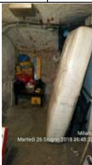
Appartamento in via A. Mambretti 29 scala B Milano - cantina pertinenziale
