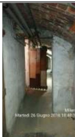
Appartamento in via A. Mambretti 29 scala B Milano - piano cantinato
