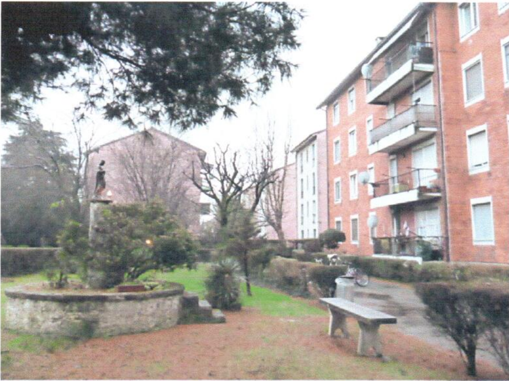
FOTO 1 e 2 – L'edificio, fronte e retro sul giardino condomiiale) di Via Carlo Lorenzini n° 20 in Bollate
