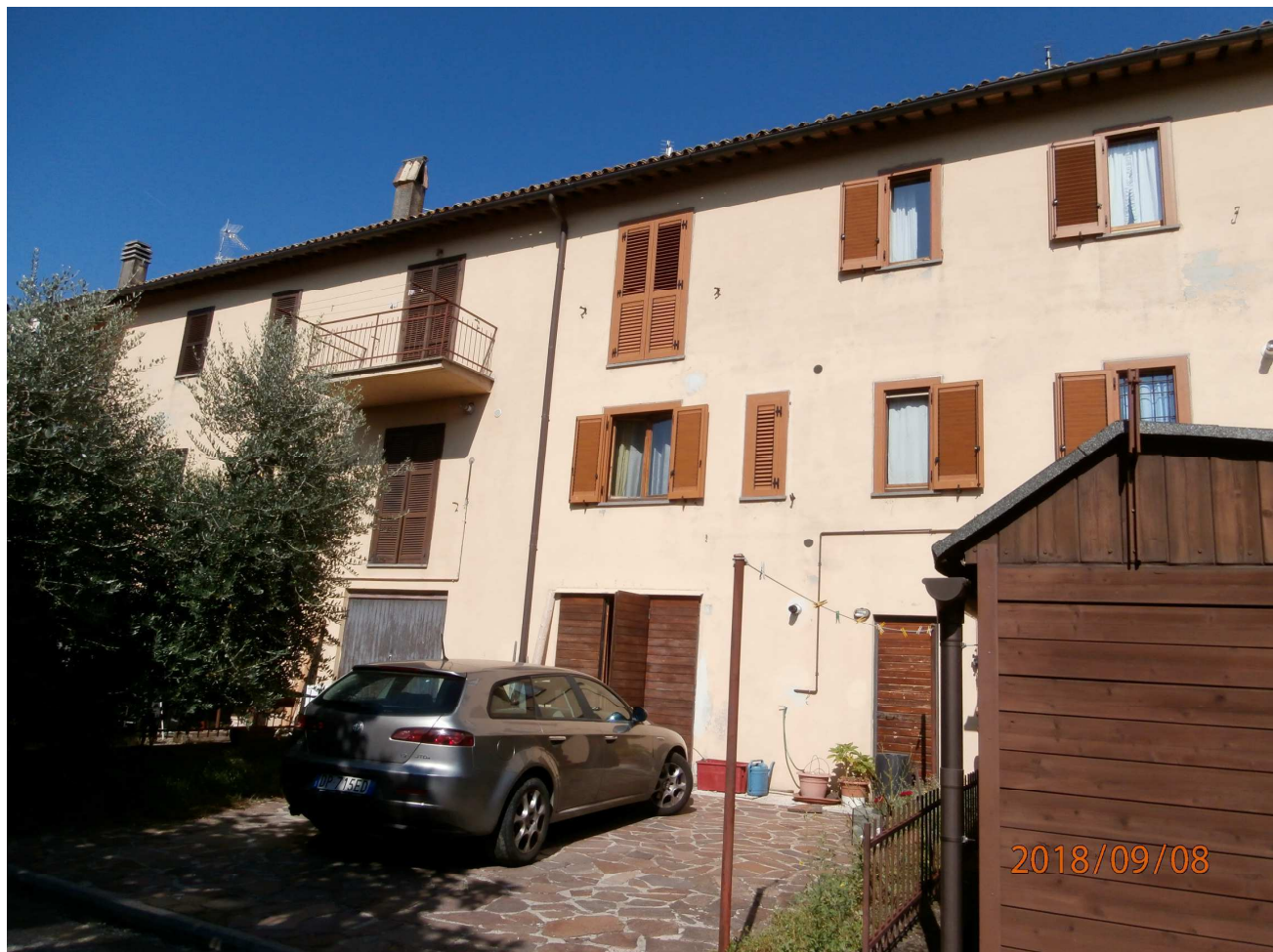
Foto n. 7. – Vista della facciata posteriore del villino con evidenza del cortile pavimentato di pertinenza della porzione staggita utilizzabile come parcheggio auto.
