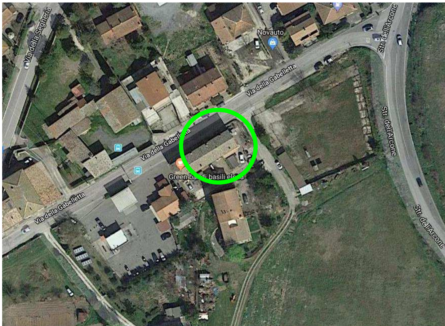
Foto n. 3. – Vista aerea con identificazione dell'ubicazione del fabbricato del quale fa parte l'immobile oggetto dell'esproprio, contrassegnato dal cerchio in verde. Si evidenzia come la costruzione oggetto della Procedura Esecutiva sia posizionata in zona marginale rispetto al centro storico di Orvieto, sebbene assai vicina ad esso.
