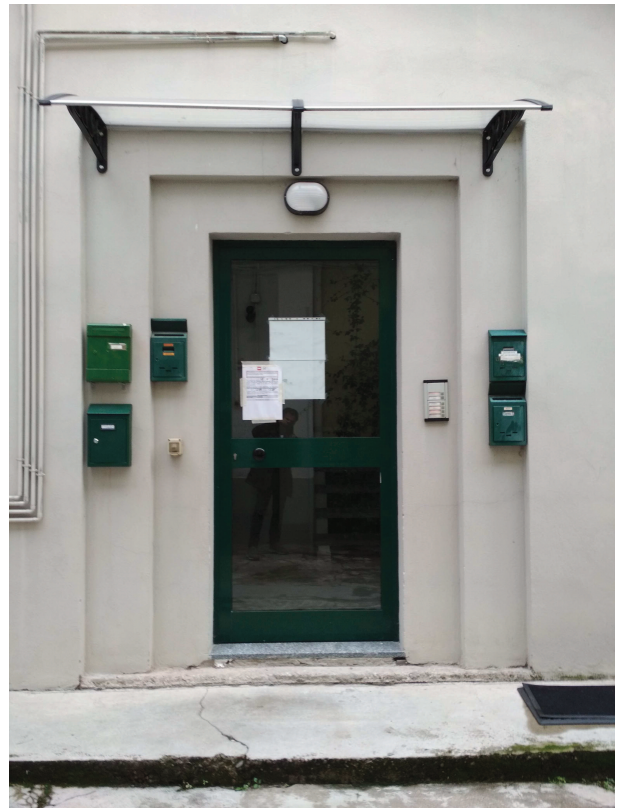
Foto n. 5 – Ingresso al fabbricato
