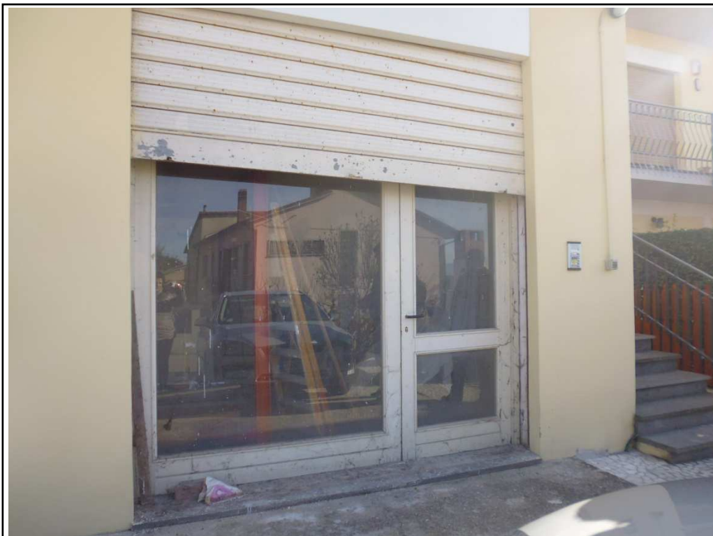
Foto n. 2 – Accesso alla unità immobiliare (lungo Via Kennedy)
