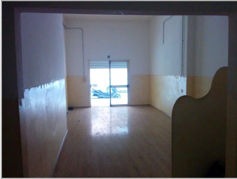
Foto n. 3 – Locale di ingresso della unità immobiliare
