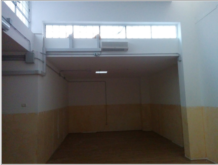
Foto n. 5 – Locale principale della unità immobiliare
