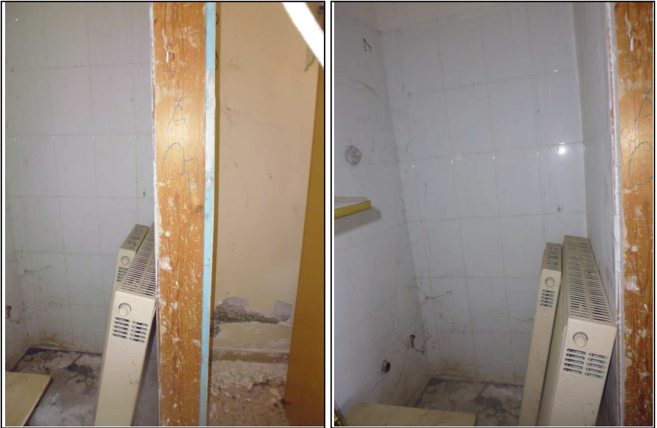
Foto n. 7/8 – Locale ad uso igienico della unità immobiliare
