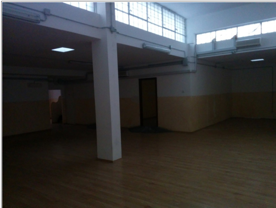
Foto n. 6 – Locale principale della unità immobiliare
