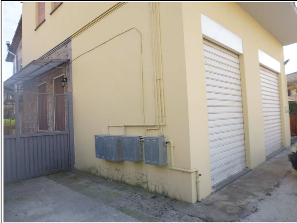
Foto n. 1 – Accesso alla unità immobiliare (lungo Via Kennedy)
