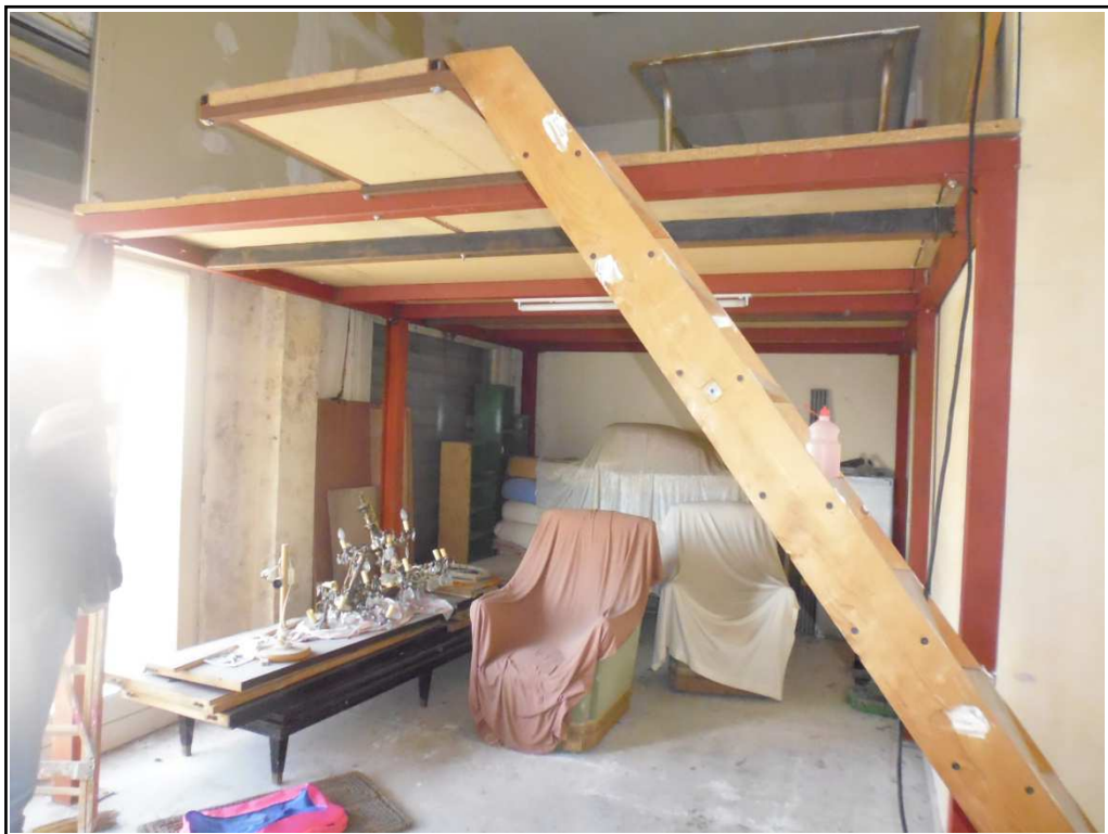
Foto n. 4 – Locale principale unità immobiliare, con presenza di soppalco
