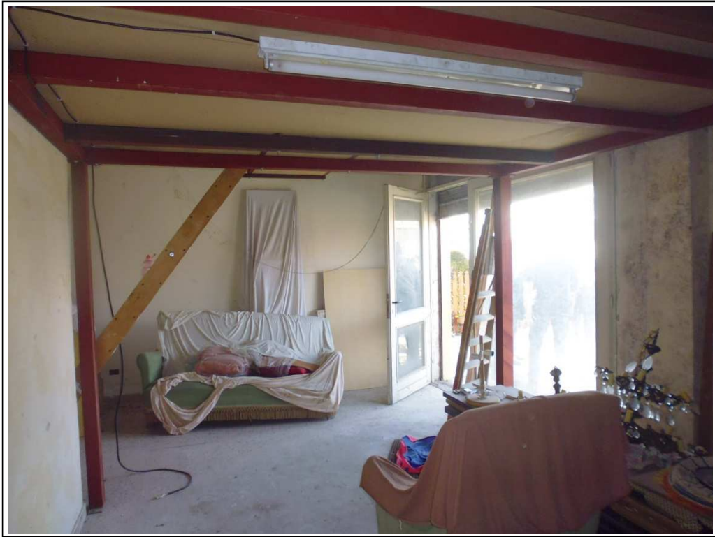
Foto n. 5 – Locale principale unità immobiliare, con presenza di soppalco
