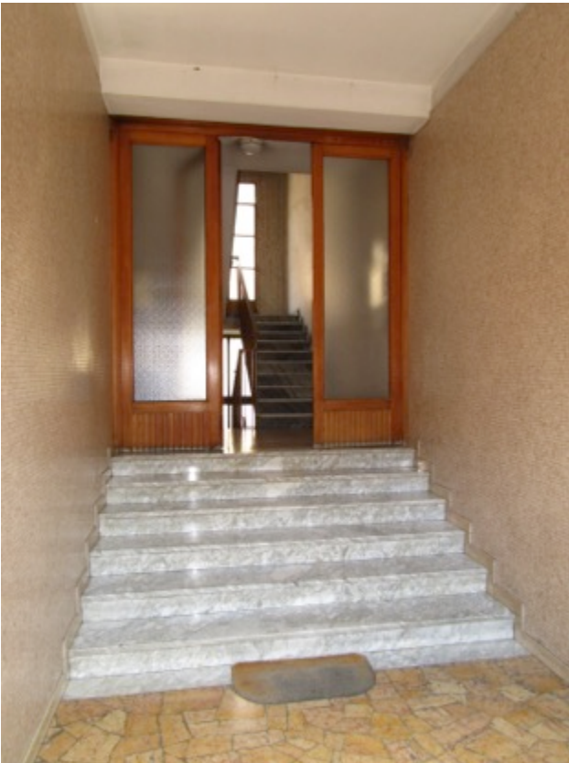
9. Androne del fabbricato.
