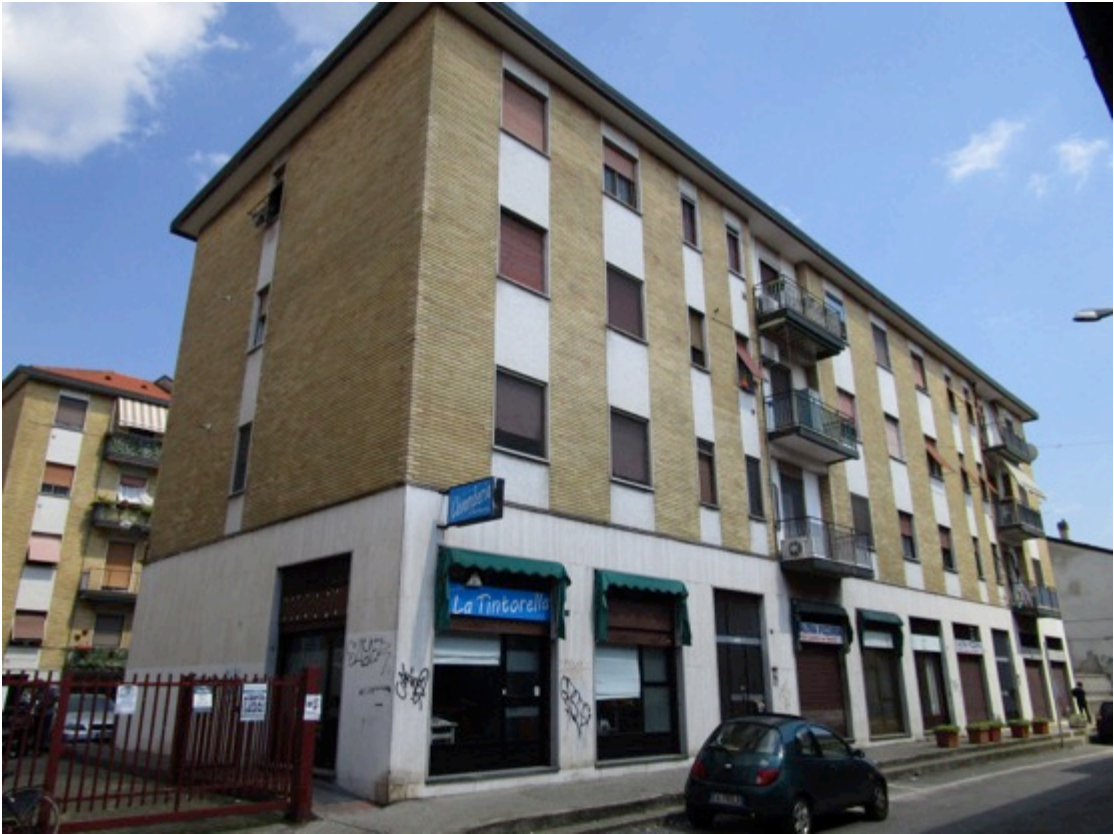
1. Fabbricato fronte strada di Via Monzese 46, vista da nord-ovest.
