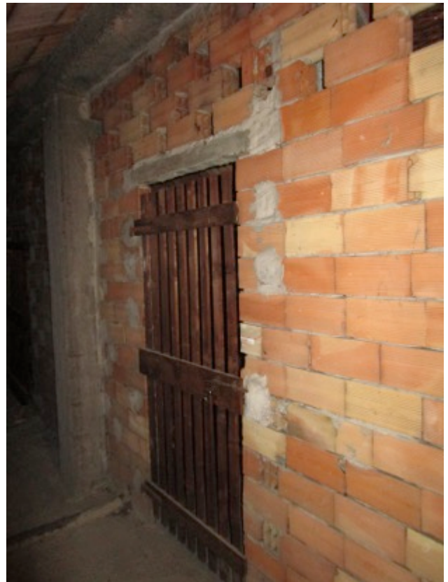
28. Porta di accesso al solaio.
