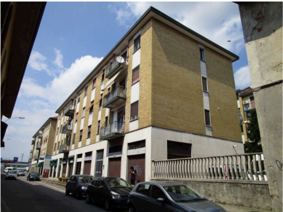
2. Fabbricato fronte strada di Via Monzese 46, vista da sud-ovest.
