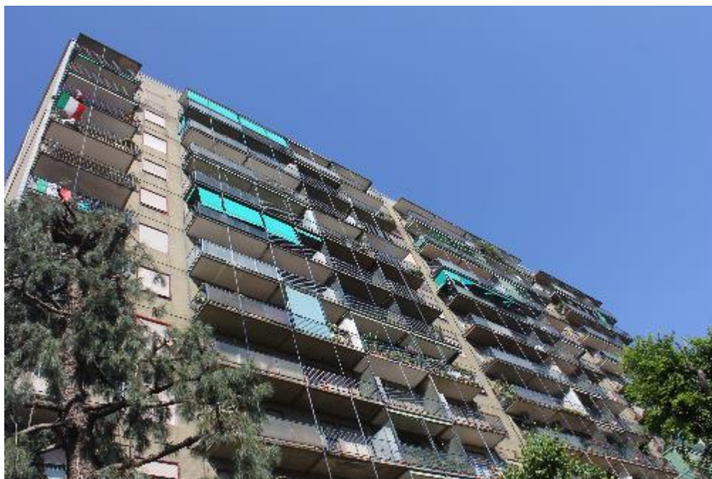
FOTO 1: CORSICO (MI), VIA COPERNICO 1, vista fabbricato dal cortile condominiale
