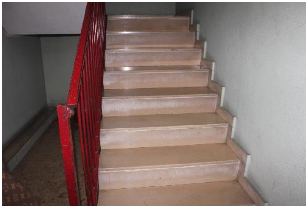
FOTO 4: CORSICO (MI), VIA COPERNICO 1, scala condominiale
