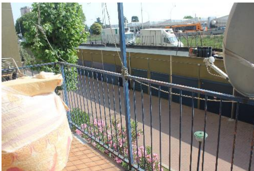
FOTO 8: CORSICO (MI), VIA COPERNICO 1, balcone con accesso dalla cucina
