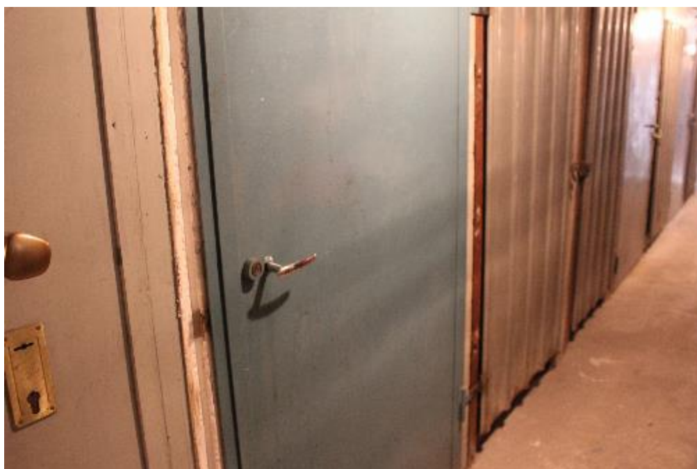
FOTO 16: CORSICO (MI), VIA COPERNICO 1, accesso cantina non visionata
