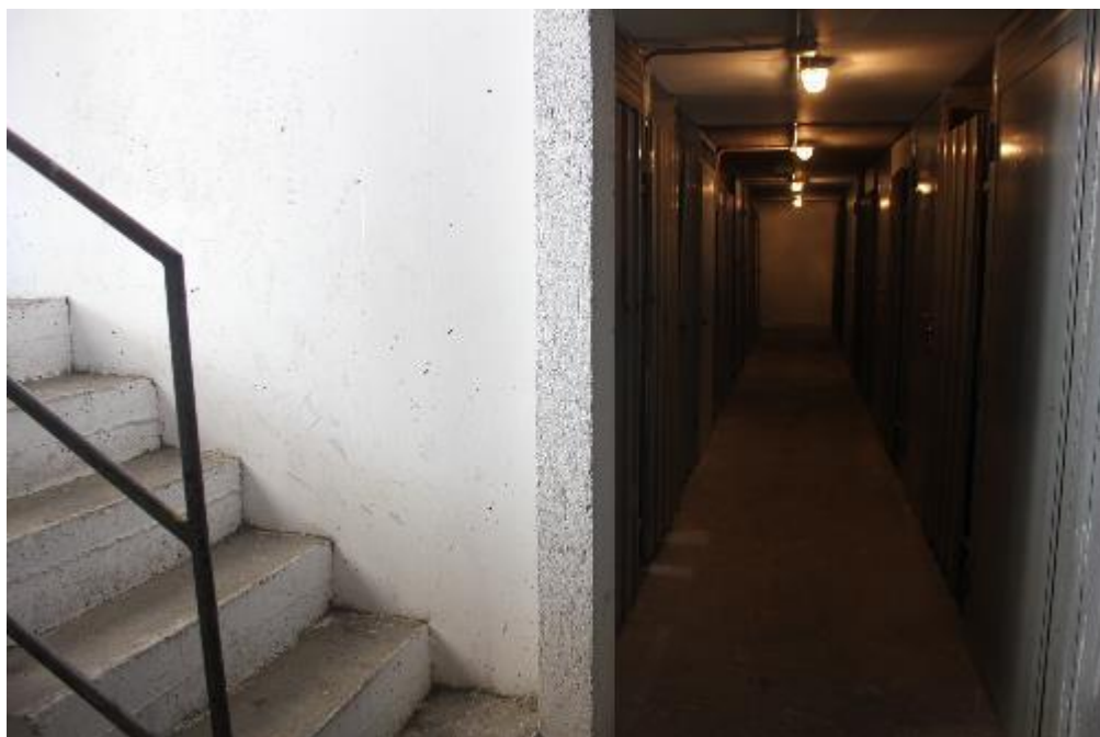
FOTO 15: CORSICO (MI), VIA COPERNICO 1, piano cantinato
