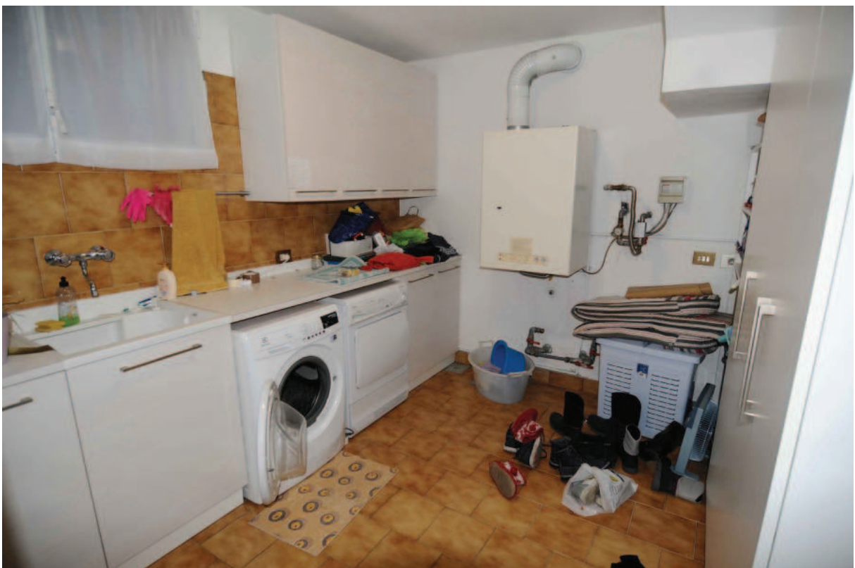
Foto 10 – La lavanderia al piano seminterrato.
