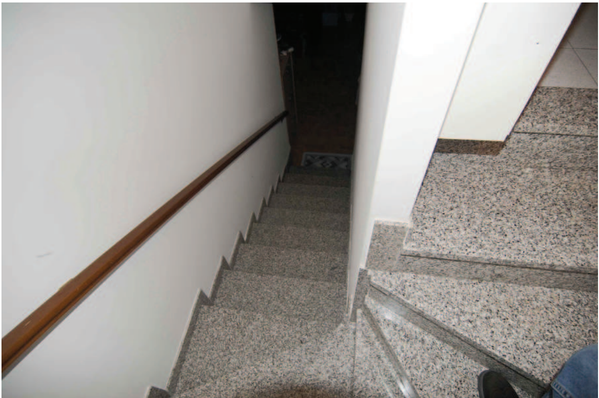
Foto 8 – Vista del vano scala.
