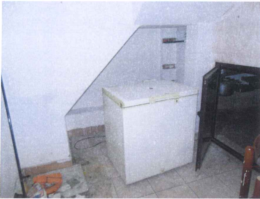
Servizio igienico abusivo
