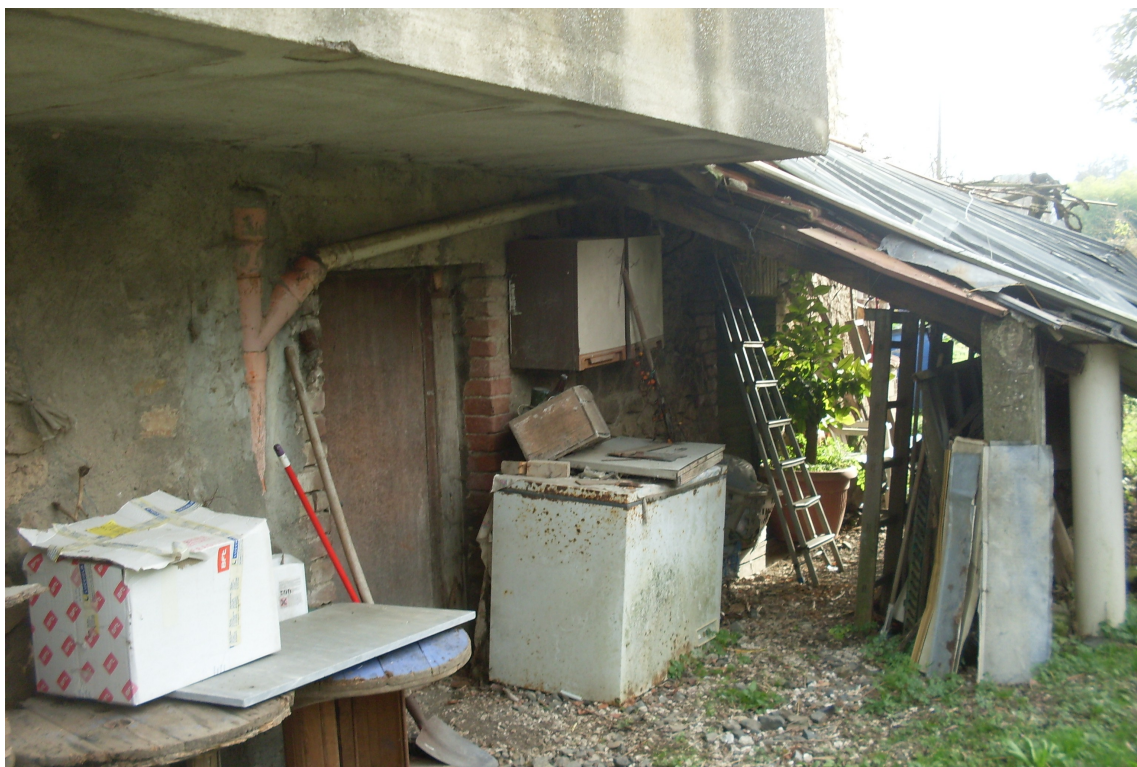
-Veduta esterna ingresso locale cantina-
