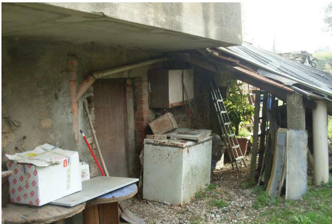
-Veduta esterna ingresso locale cantina-
