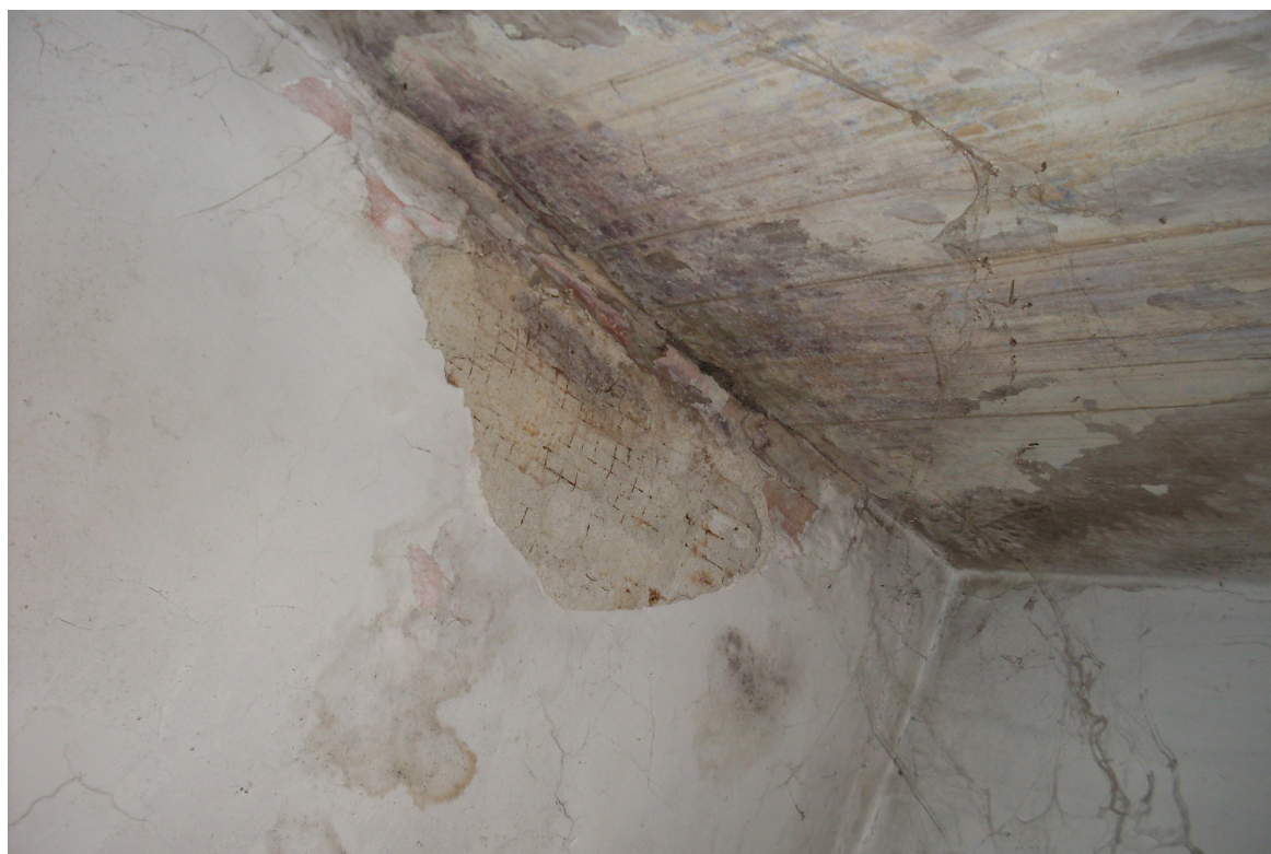
-Veduta interna locale camera –
