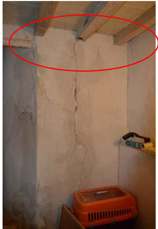
Foto n. 13, 14 – Lesioni su apertura di comunicazione tra le due unità strutturali al piano terra lungo la parete interessata dal cedimento fondale (31 gennaio 2019)
