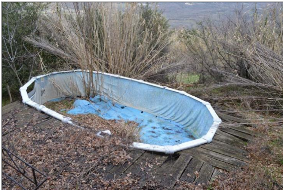
Foto n. 13 – Piscina esterna prefabbricata
