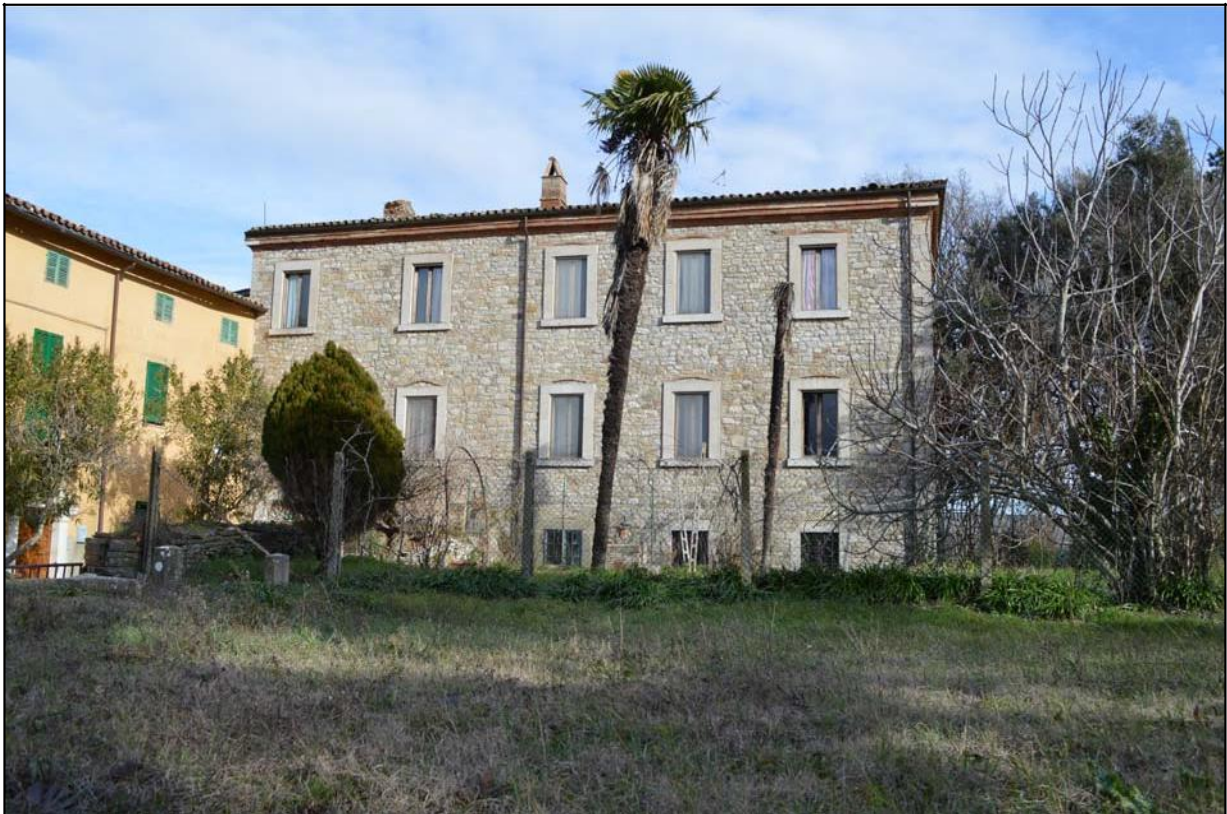
Foto n. 1 – Prospetto principale del fabbricato (lato Ovest)
