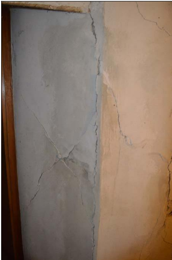
Foto n. 13, 14 – Lesioni su apertura di comunicazione tra le due unità strutturali al piano terra lungo la parete interessata dal cedimento fondale (31 gennaio 2019)
