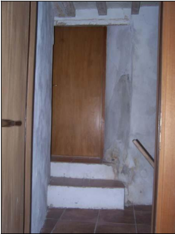
Foto n. 11, 12 – Lesioni su apertura di comunicazione tra le due unità strutturali al piano terra lungo la parete interessata dal cedimento fondale (febbraio/marzo 2015)
