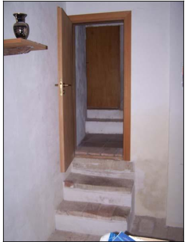
Foto n. 11, 12 – Lesioni su apertura di comunicazione tra le due unità strutturali al piano terra lungo la parete interessata dal cedimento fondale (febbraio/marzo 2015)
