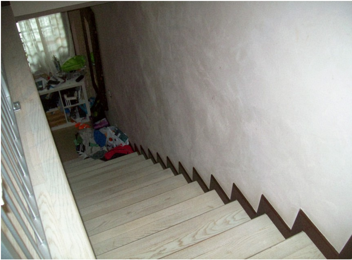
Foto 7: Scala interna zona abitabile
