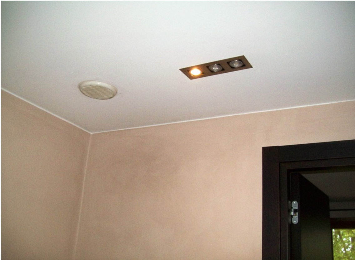
Foto 9: Disimpegno piano primo
