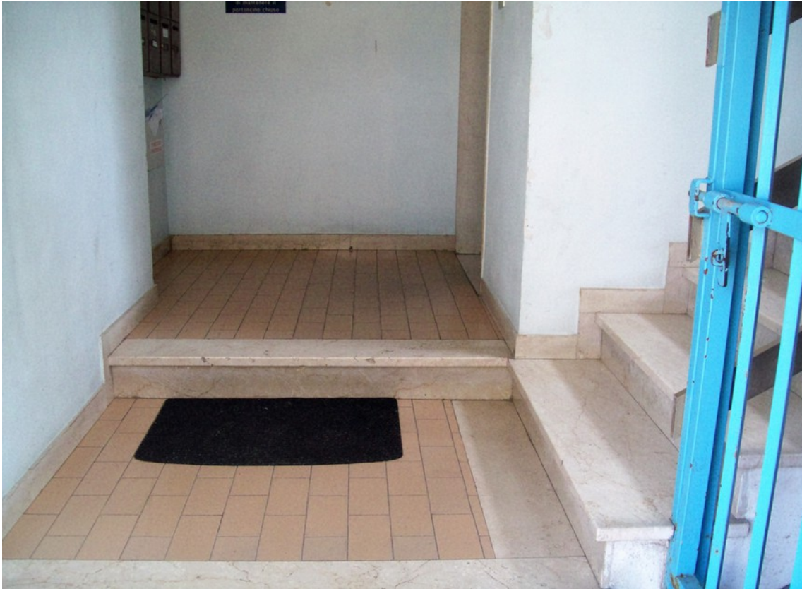
Foto 5: Vano scale condominio
