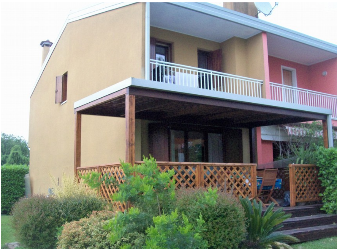
Foto 2: Fabbricato visto da Sud-Ovest
