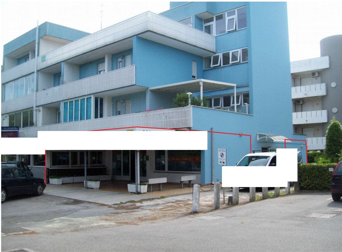
Foto 1: Vista fabbricato da Nord-Est
