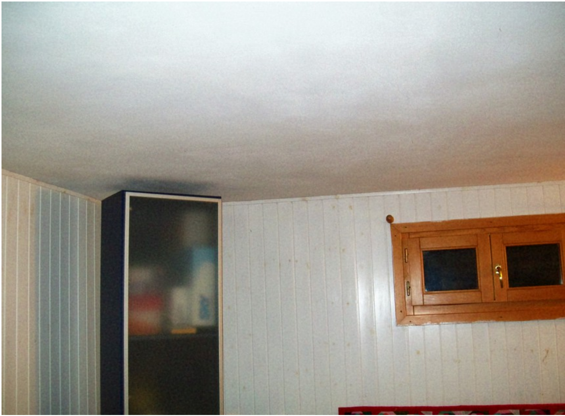
Foto 13: Ripostiglio al piano seminterrato
