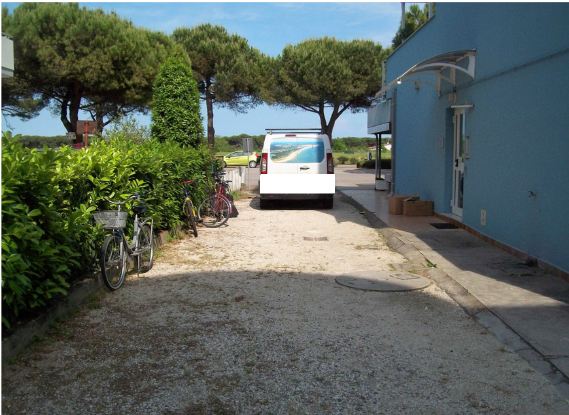
Foto 4: Vista parete Nord
