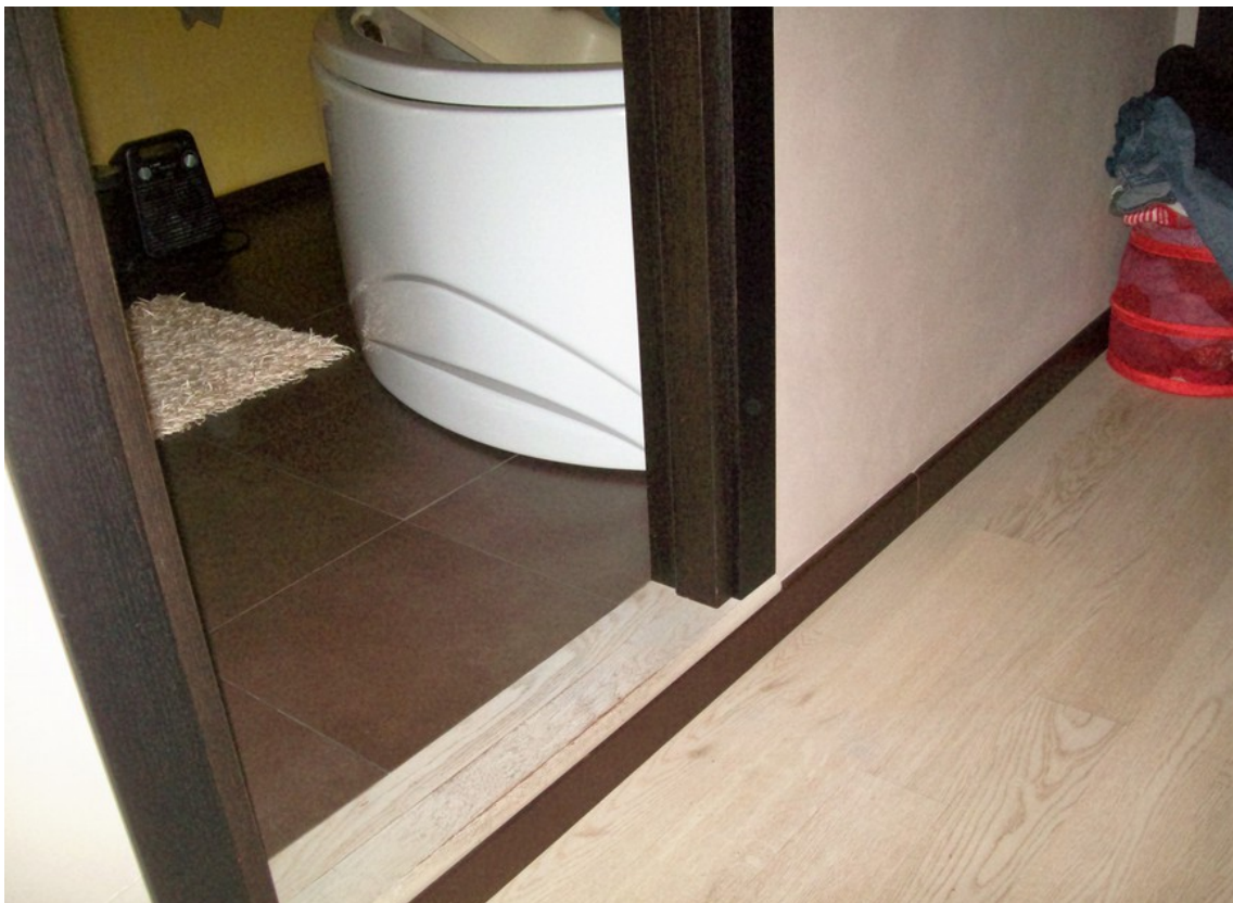
Foto 10: Pavimentazione disimpegno e bagno primo piano
