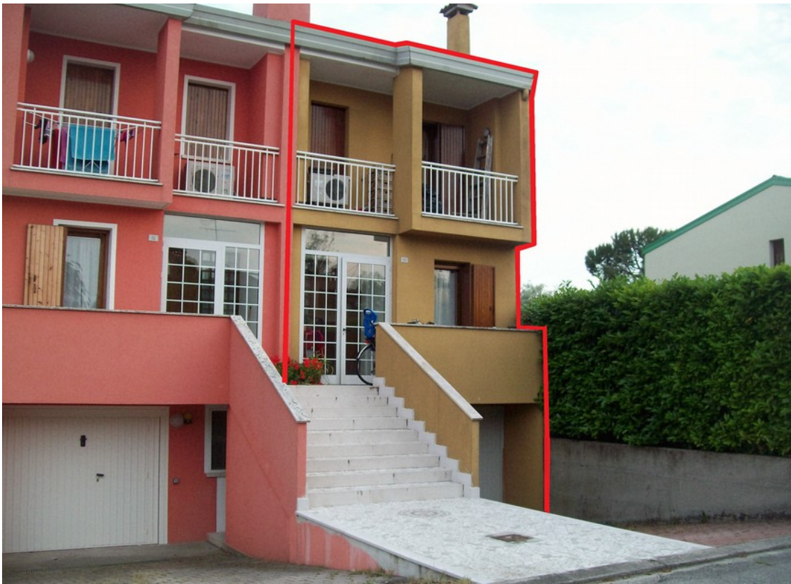
Foto 1: Vista fabbricato da Nord-Est
