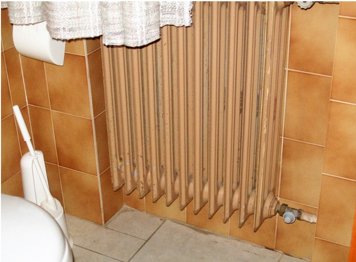
Foto 14: Parete Ovest Wc
