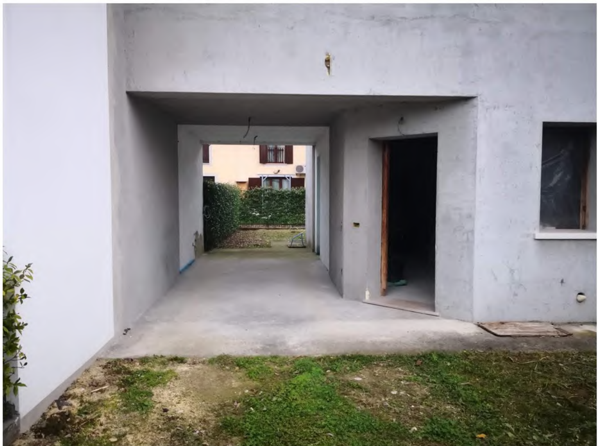
2.6 - particolare ingresso - cucina
