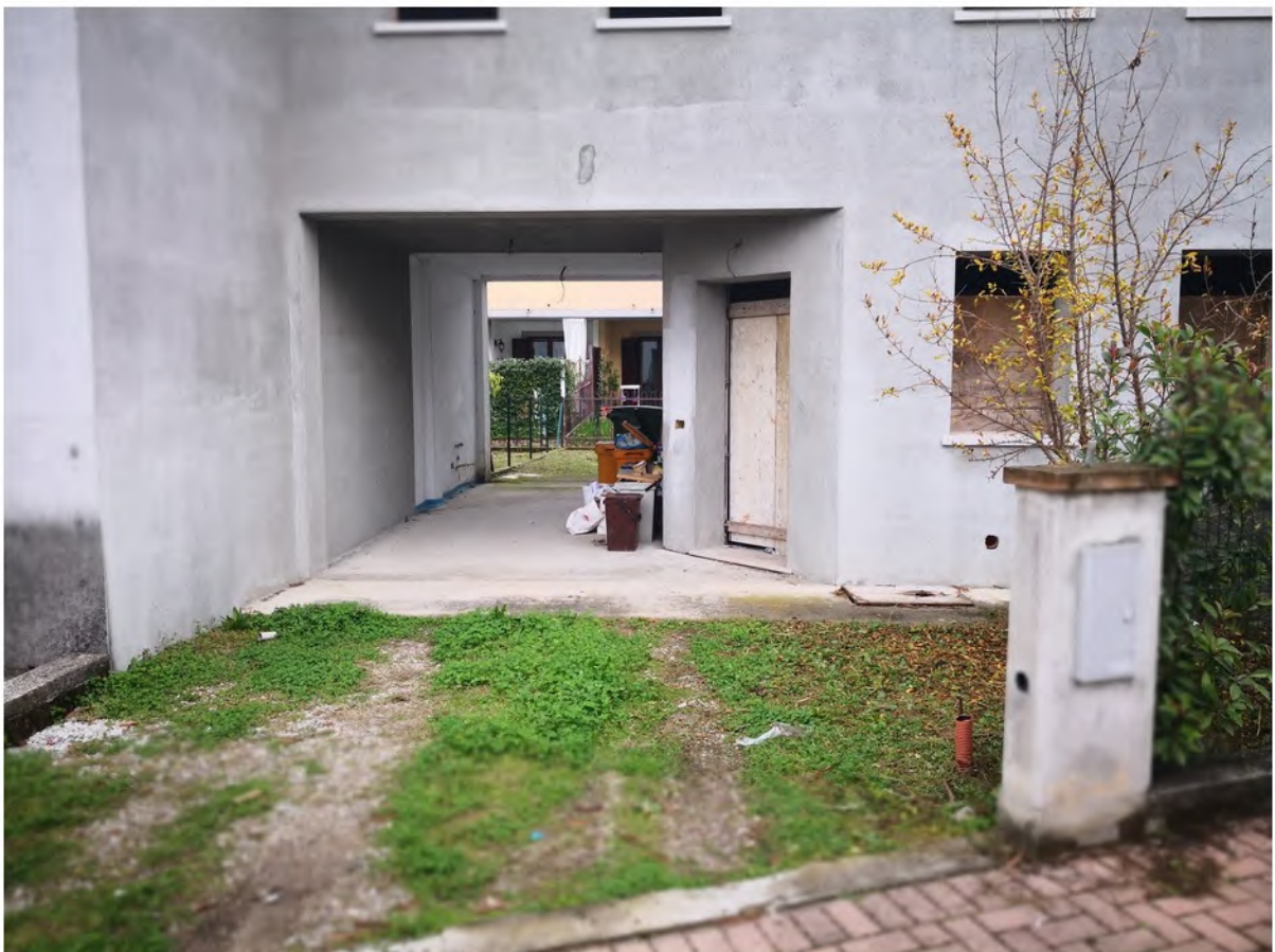
1.2 - particolare ingresso esterno
