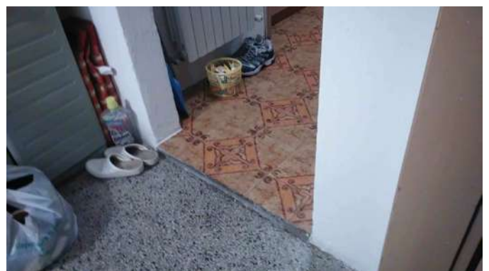
Particolare pavimentazione p. 1
