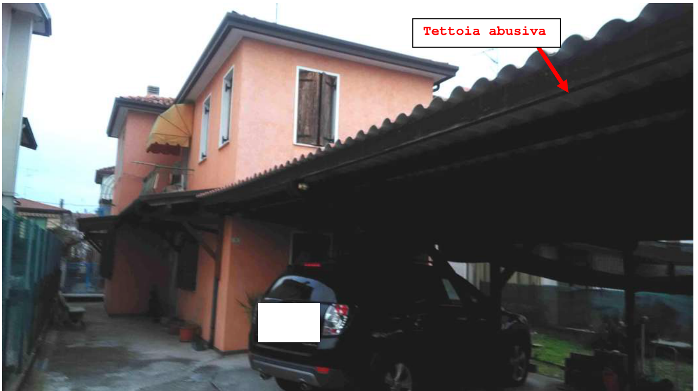
Veduta da area esterna pertinenziale - NCEU fg 38 part 263
