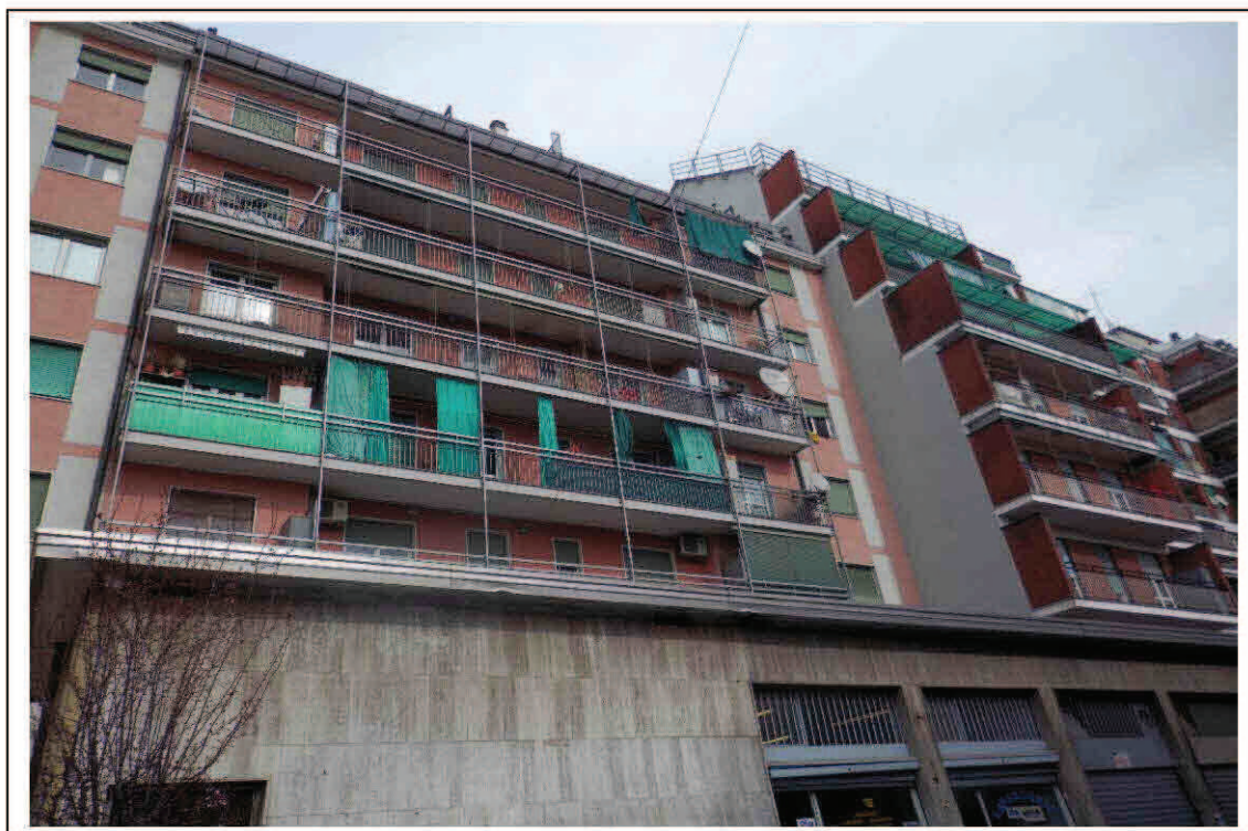
Fotografia n°2 – Vista della facciata fronte strada del fabbricato.
