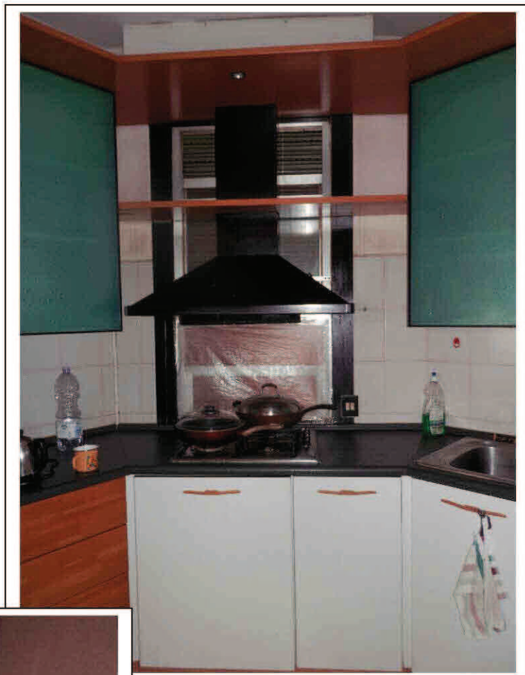
Fotografia n°11 – Vista della cucina (si osserva il serramento da sostituire e della cappa che ne ostacola l'apertura).
