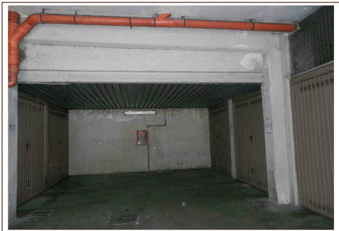
Fotografia n°2 – Vista del corsello interno di manovra ai boxes.
