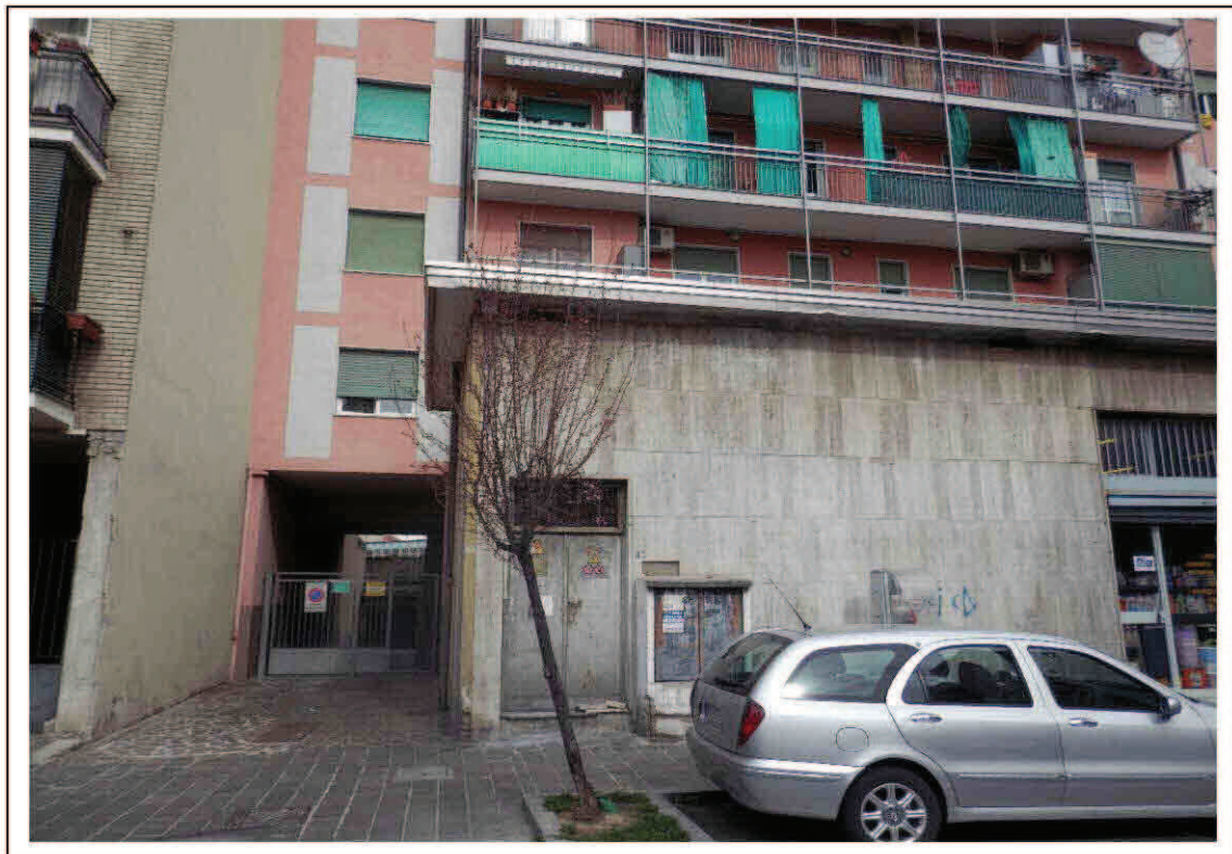
Fotografia n°1 – Vista della facciata fronte strada del fabbricato e dell'androne di accesso allo stabile.
