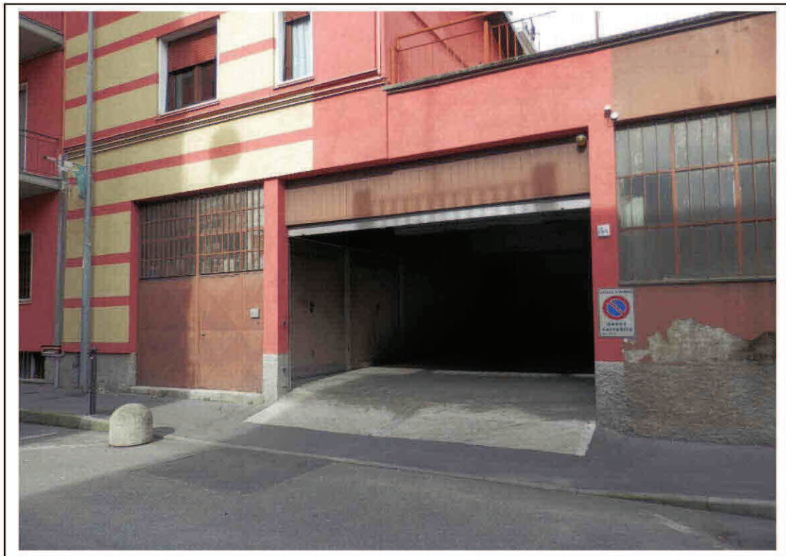
Fotografia n°1 – Vista della facciata del fabbricato e dell'accesso ai boxes auto.
