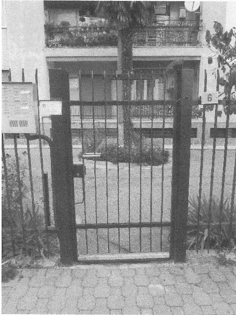
Ingresso fronte strada
