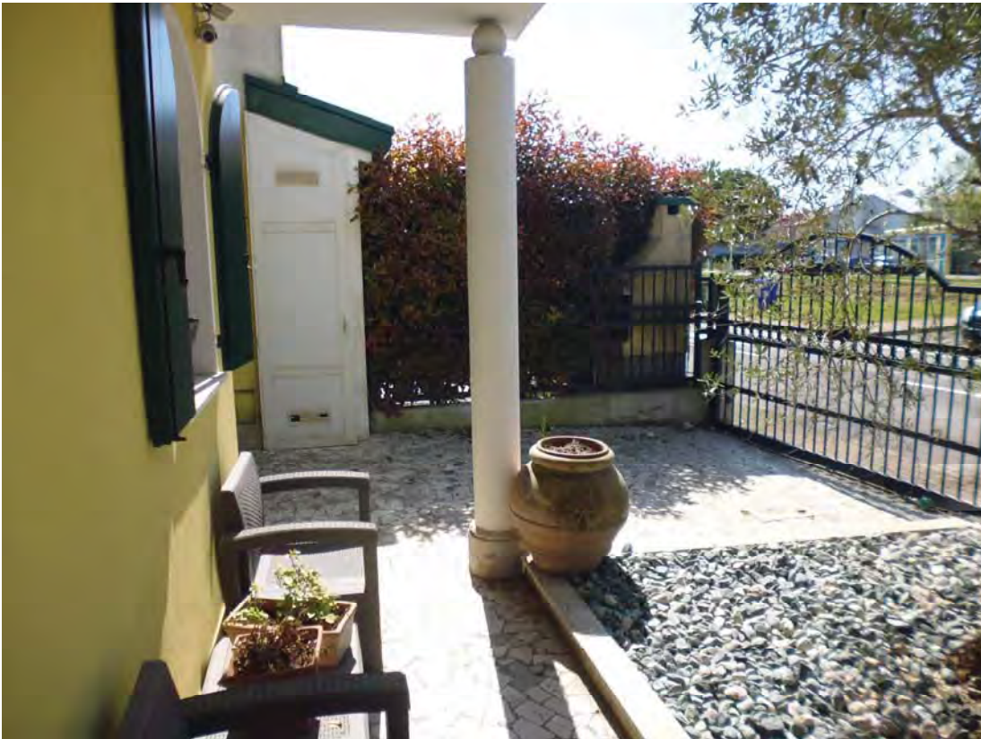
Vista lato nord ovest e vano caldaia
