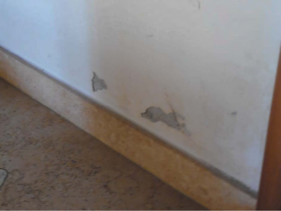
Particolare scrostatura su pianerottolo
