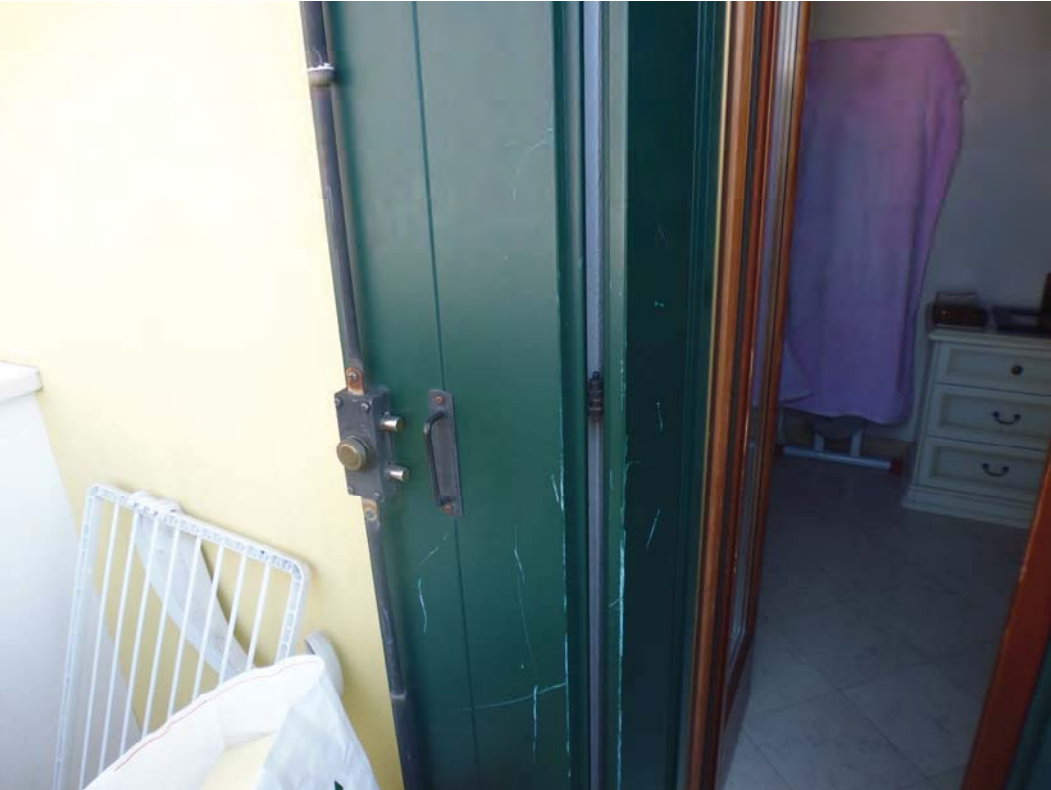
Particolare serramento esterno in compensato marino laccato
