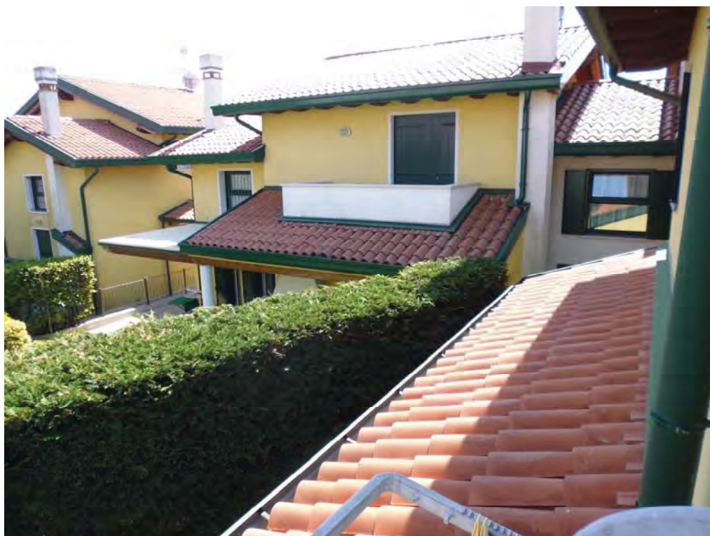
Particolare manto di copertura e grondaie in lamiera preverniciata
