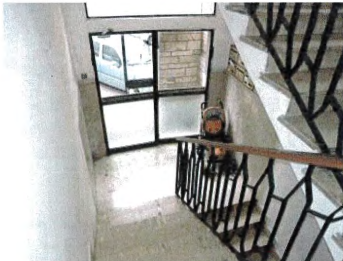
Vano scale condominiale
