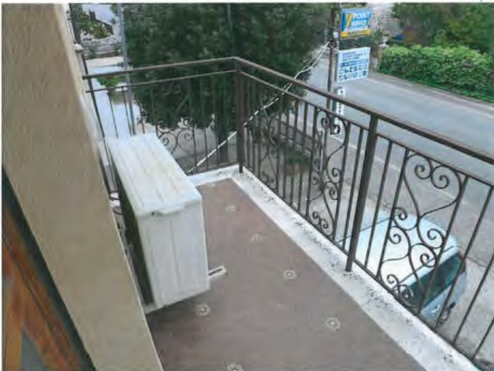
Foto n.17 - Esterno sub.3 p.lla 440, sub.8 p.lla 321, sub.7 p.lla 375, balcone 2.
