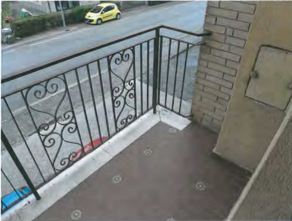
Foto n.17 - Esterno sub.3 p.lla 440, sub.8 p.lla 321, sub.7 p.lla 375, balcone 1.
