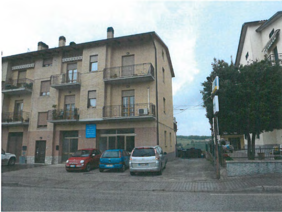
Foto n.1 - Prospetto principale e area esclusiva p.lla 1328
