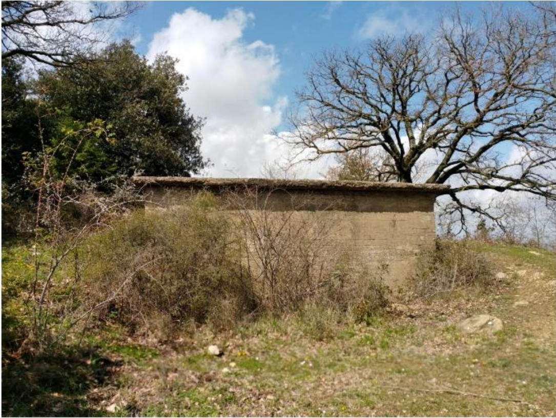
Cisterna di accumulo e distribuzione idrica Foto 1
