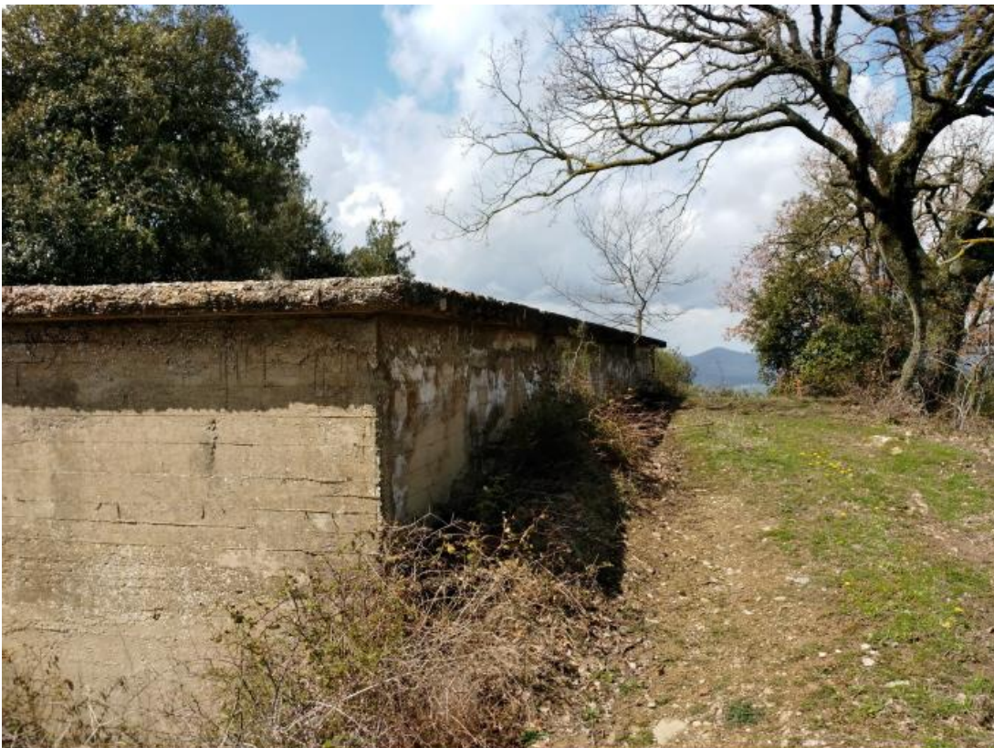
Cisterna di accumulo e distribuzione idrica Foto 2
