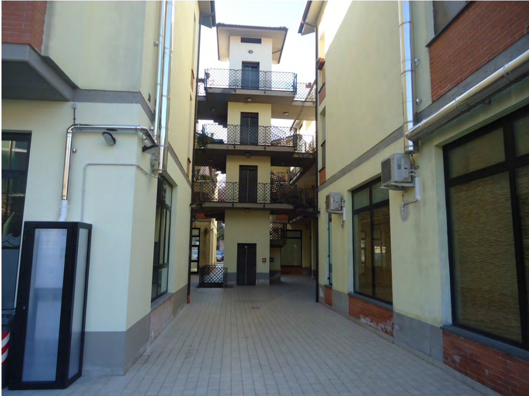
FOTO VANO SCALA/ASCENSORE (foto n.5)
