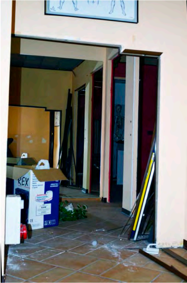
FOTO Corpo A : INTERNO (foto n.9)
