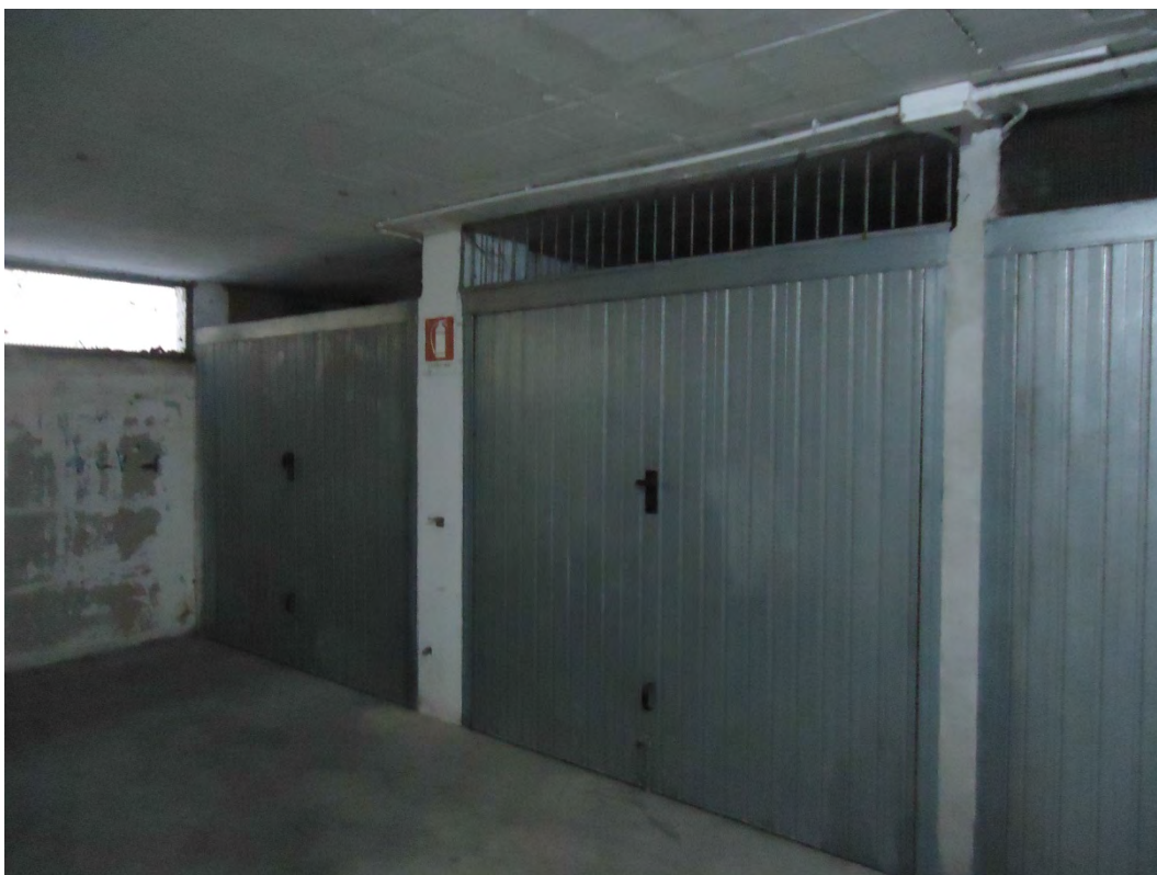
FOTO Corpi B e C: ESTERNO (foto n.13)
