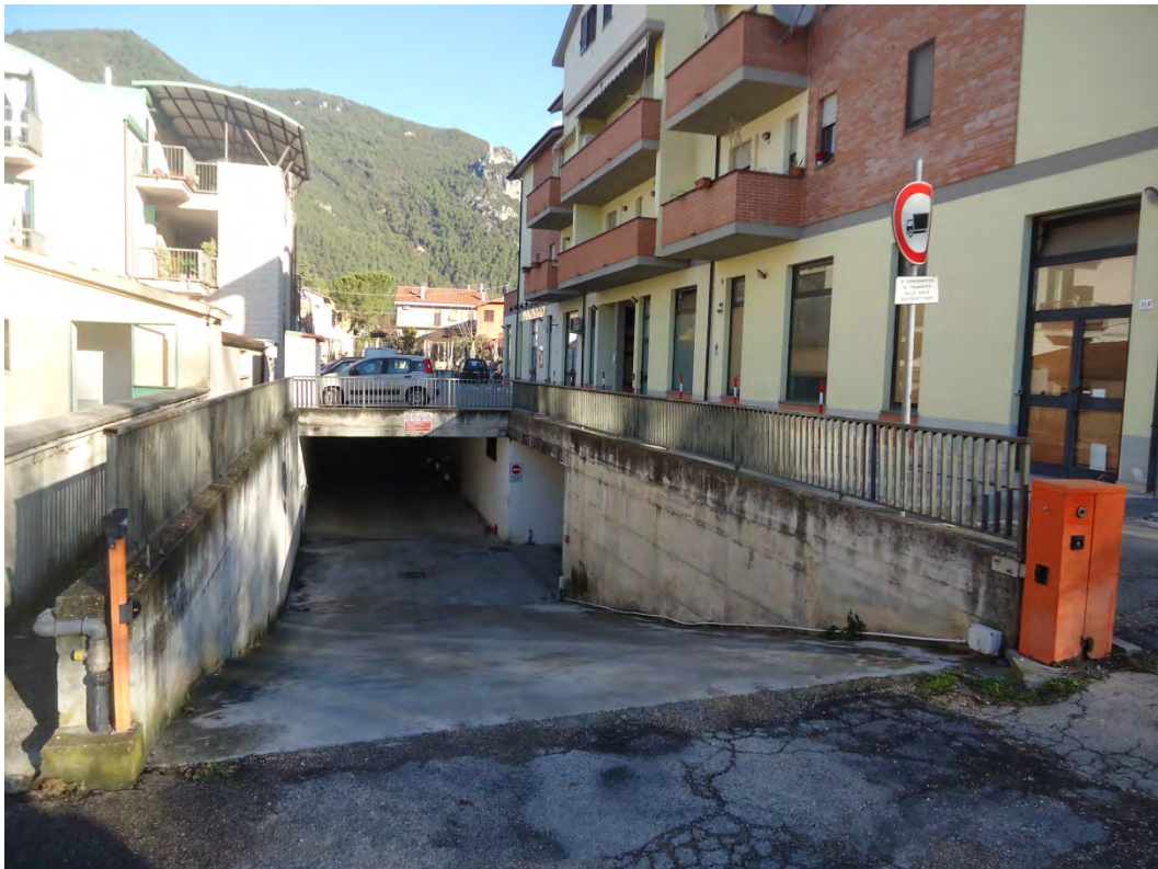
FOTO RAMPA GARAGES (foto n.6)
