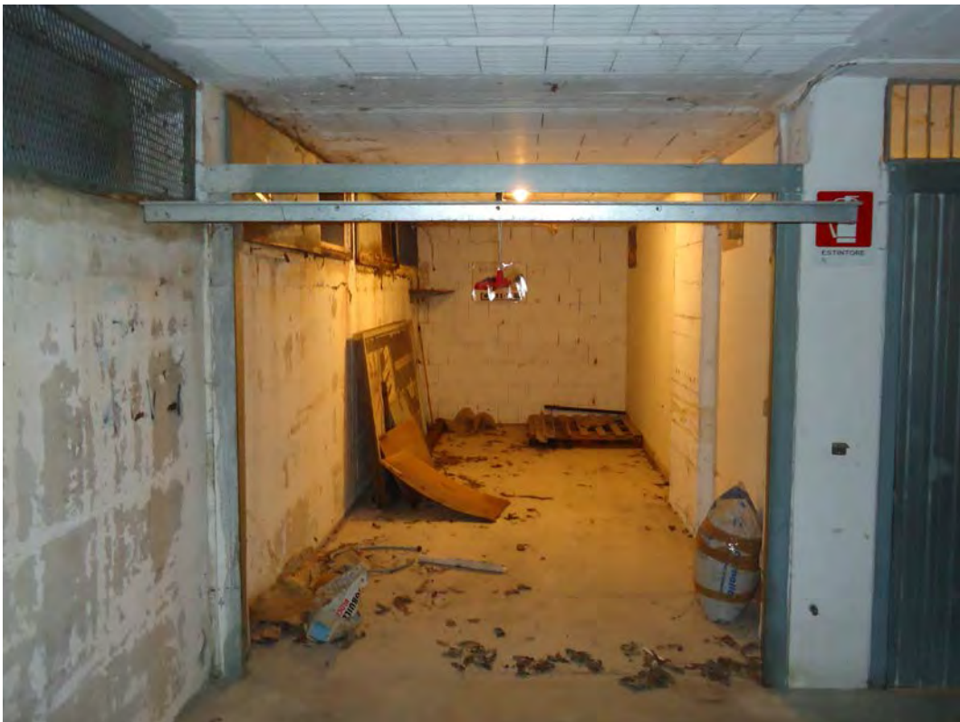
FOTO Corpo C (foto n.18)
