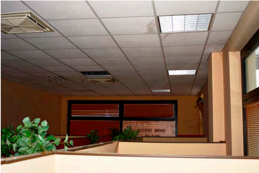
FOTO Corpo A : INTERNO (foto n.11)
