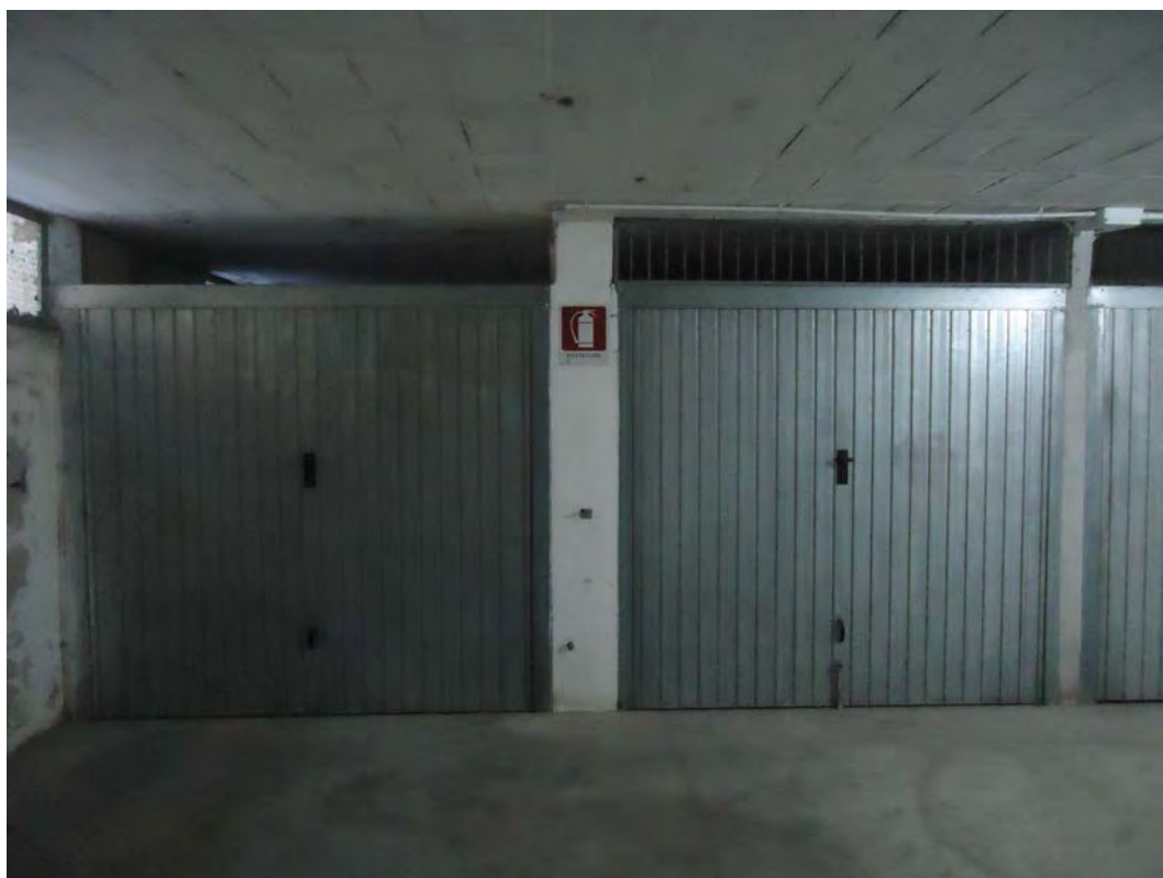
FOTO Corpi B e C: ESTERNO (foto n.14)
