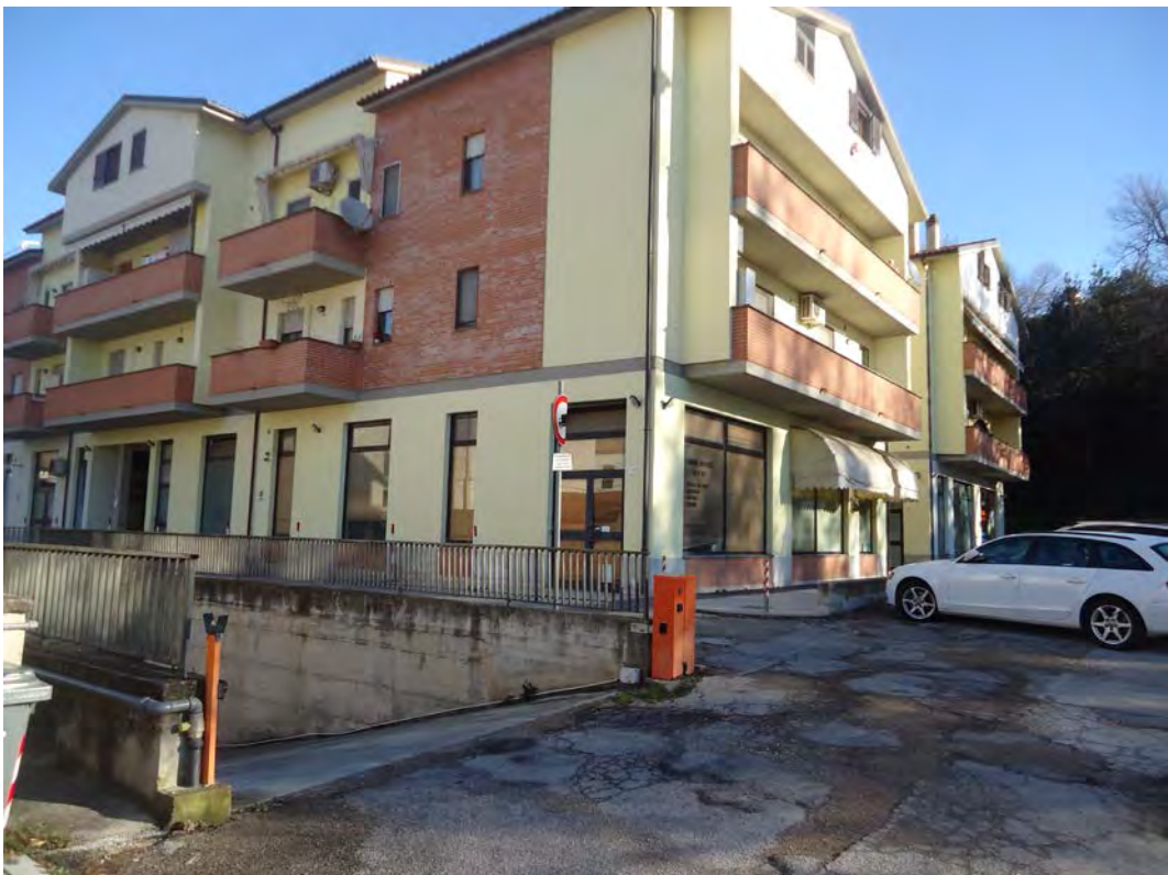
FOTO ESTERNO (foto n.2)
