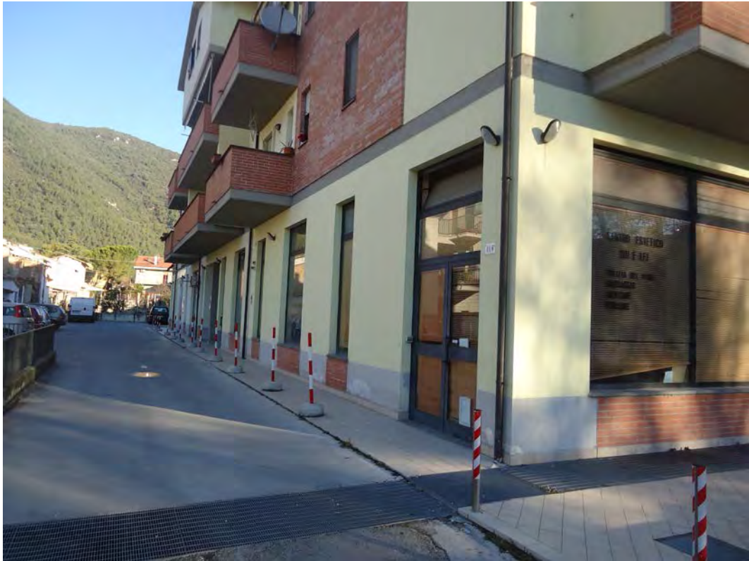
FOTO ESTERNO (foto n.3)
