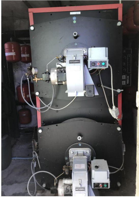
Generatore alimentato a gasolio
