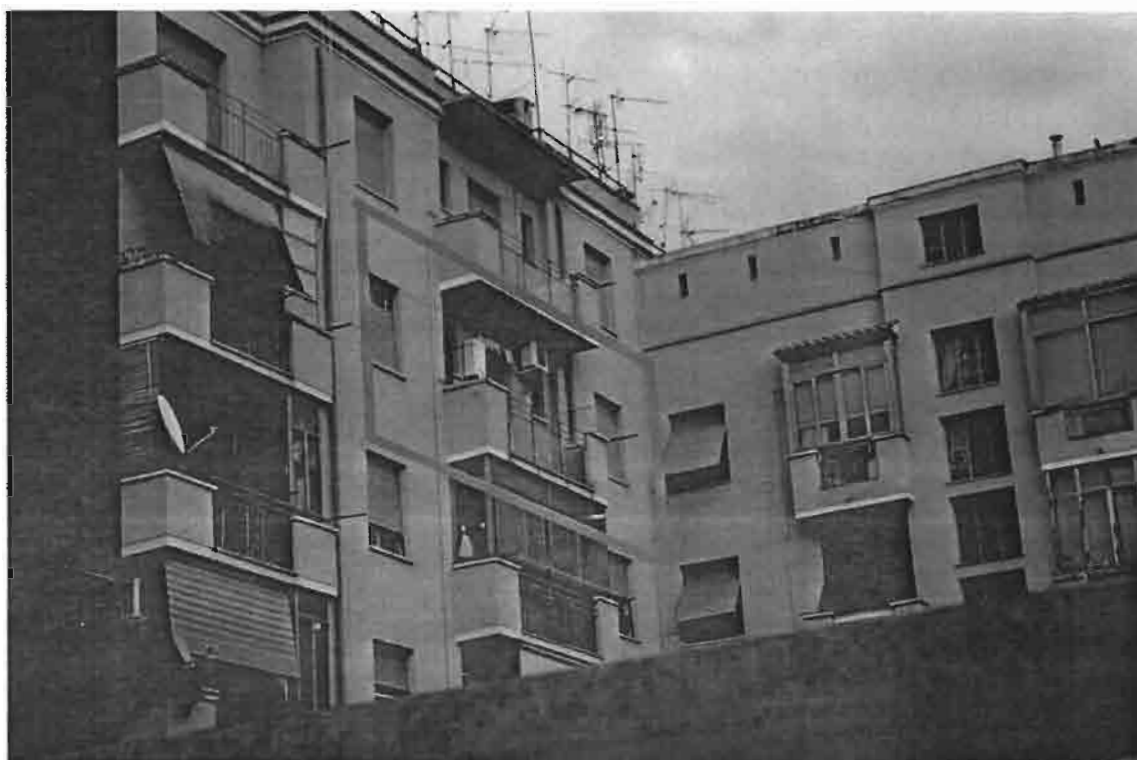
04-Localizzazione dell'unità da una vista sud dell'edificio
