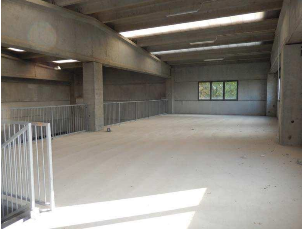
FOTO 18: Interno dell'unità pignorata – Scorcio dell'area soppalcata dalla zona d'arrivo della scala interna.
