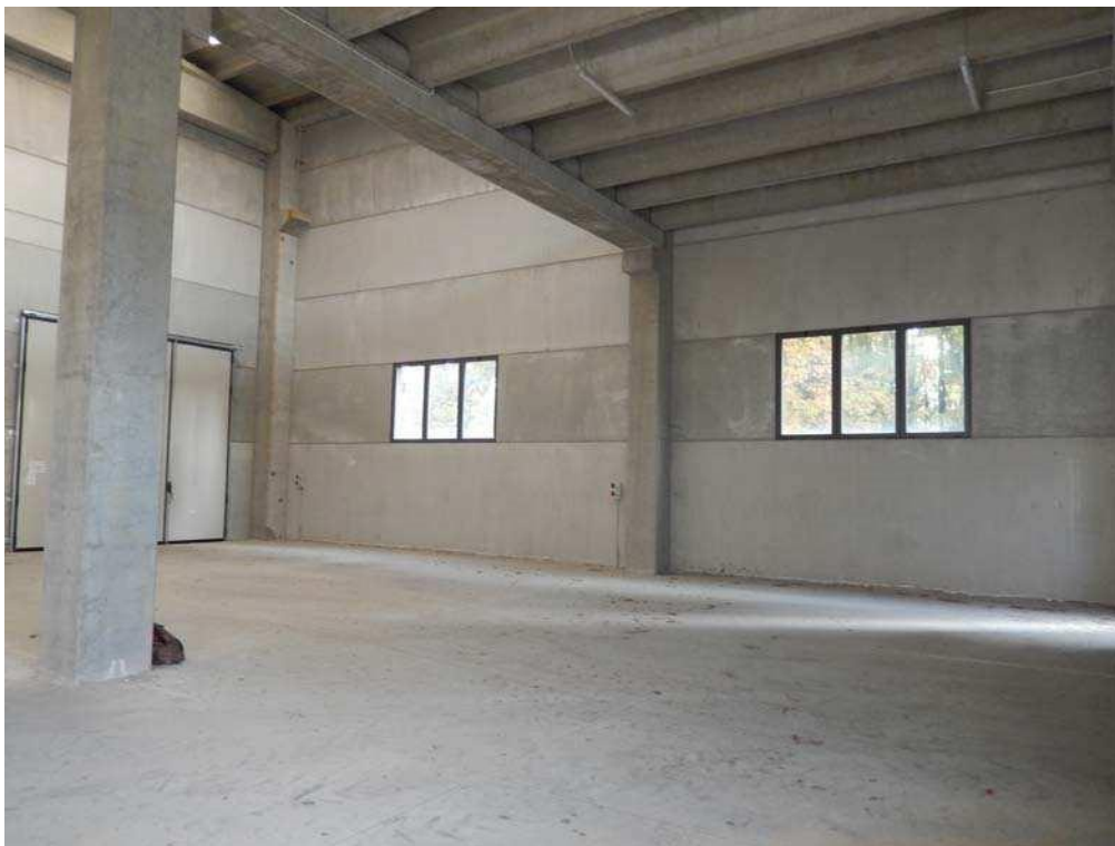
FOTO 10: Interno dell'unità pignorata – Ulteriore vista d'insieme (verso la parete Sud-Est).
