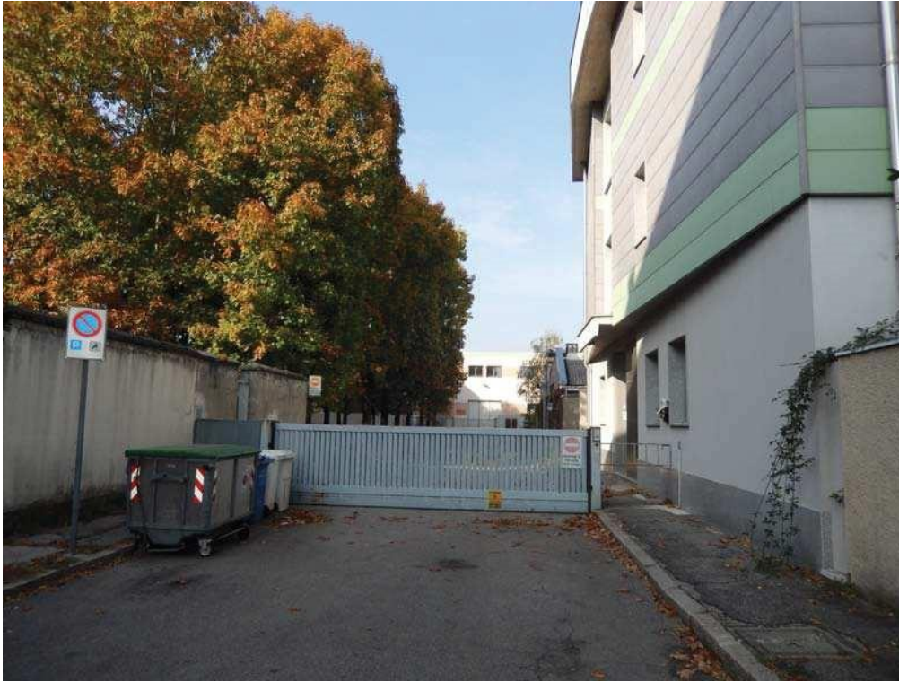
FOTO 1: Vista dalla strada dell'ingresso comune (carraio e pedonale) al compendio immobiliare in cui è sita l'unità pignorata.
