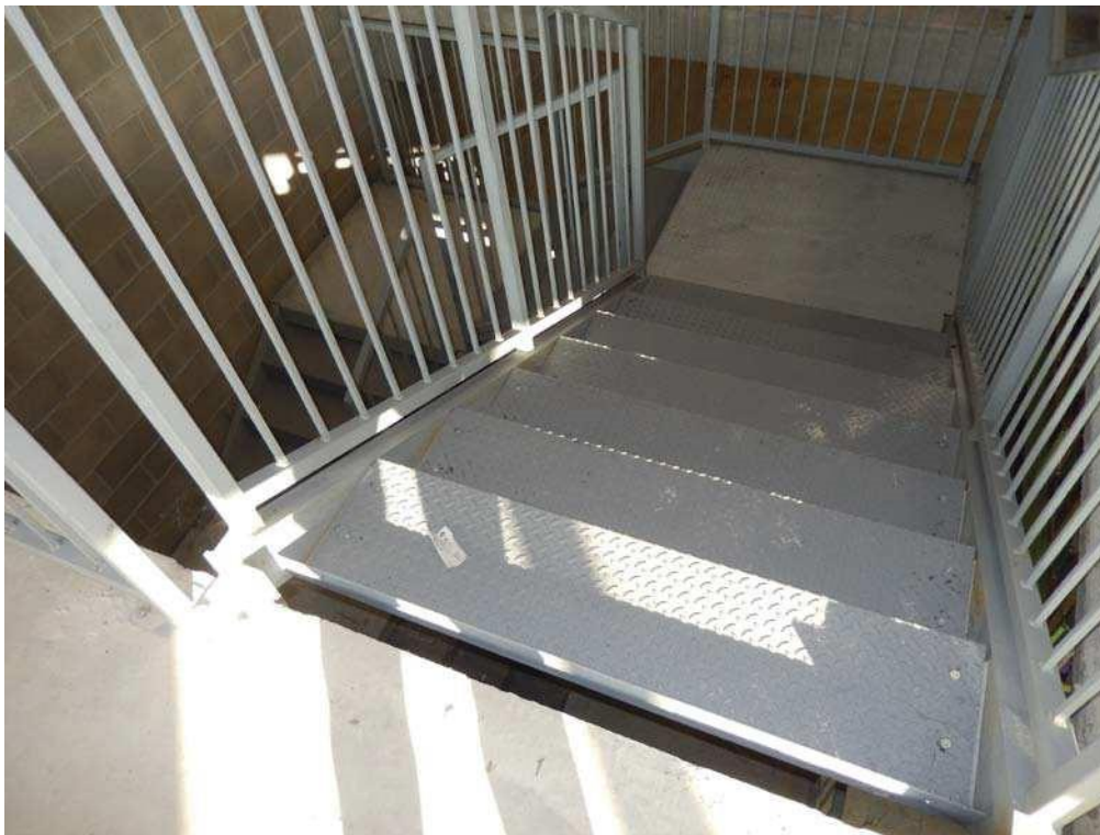
FOTO 16: Interno dell'unità pignorata – Dettaglio della scala metallica di collegamento con la soprastante area soppalcata.
