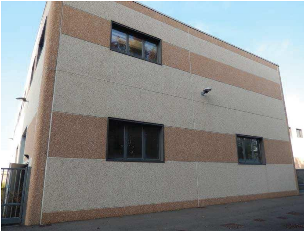
FOTO 5: Vista esterna del fronte Nord-Est dell'unità pignorata, che affaccia sull'area scoperta pertinenziale di cui al mappale 205 (la freccia indica il cancello d'ingresso a quest'ultima).
