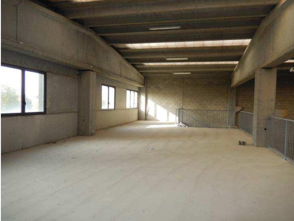
FOTO 19: Interno dell'unità pignorata – Ulteriore scorcio dell'area soppalcata, con vista verso l'arrivo della scala interna.
