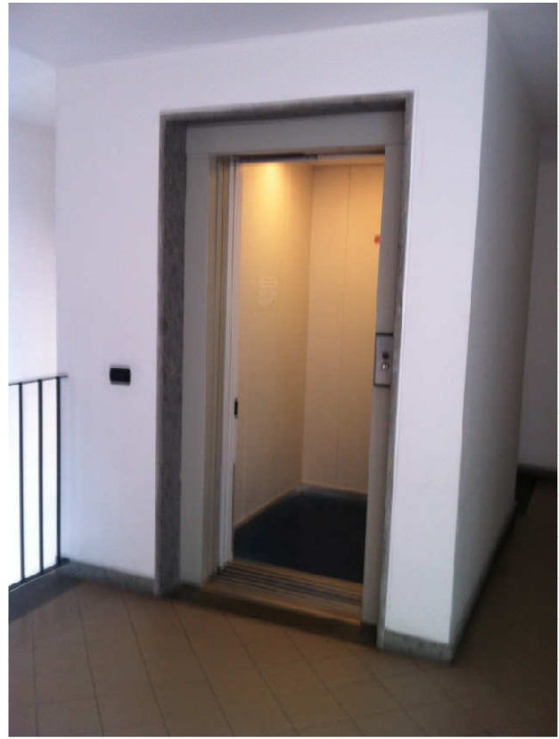
5) Ascensore al piano
