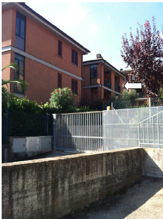
2) Vista dell'esterno dal parcheggio riservato
