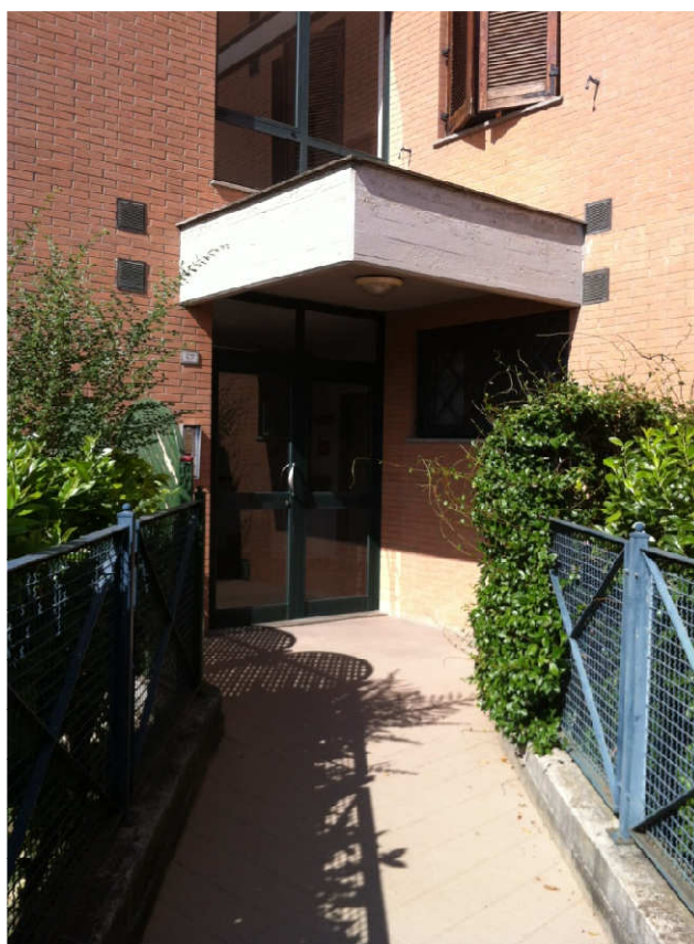
3) Vista dell'ingresso dell'edificio
