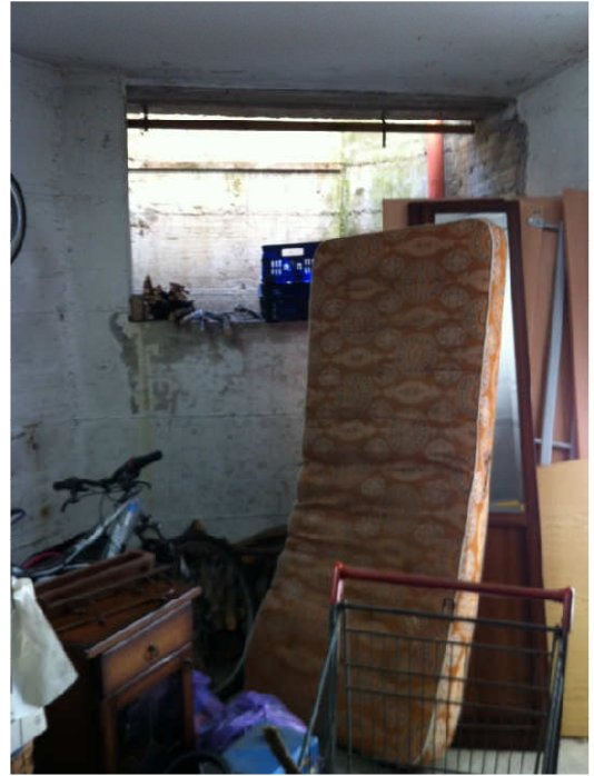
22) Locale autorimessa: interni
