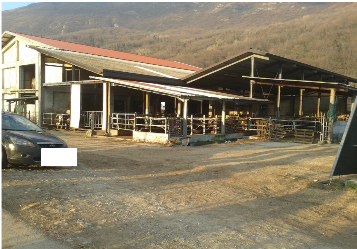
Foto n. 2 –24.01.2015 – Lotto n. 17 - Comune di Meduno fg.19 part.1757 – Foto scattata dalla lato sud est della particella. Sulla destra visibile porzione dell'edificio di cui non risulta completa la procedura di autorizzazione Comunale. Sulla sinistra parte dell'edificio iniziale costruito nel 1974 ed in seguito ampliato.
