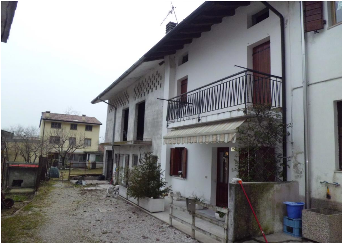
Foto n. 1 – 09.01.2015 – Lotto n. 16 - Comune di Meduno fg.19 part.853 – Vista esterna dei due fabbricati eseguiti ricadenti sulla particella 853. Sulla destra l'edificio adibito ad abitazione e collegato ad esso il fabbricato ex stalla, ora deposito e magazzino.
