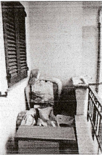
Foto 15. Balcone lato cortile piano primo
