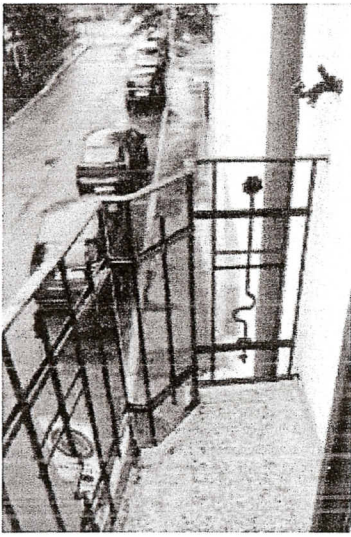
Foto 13. Balconè lato strada al piano primo
