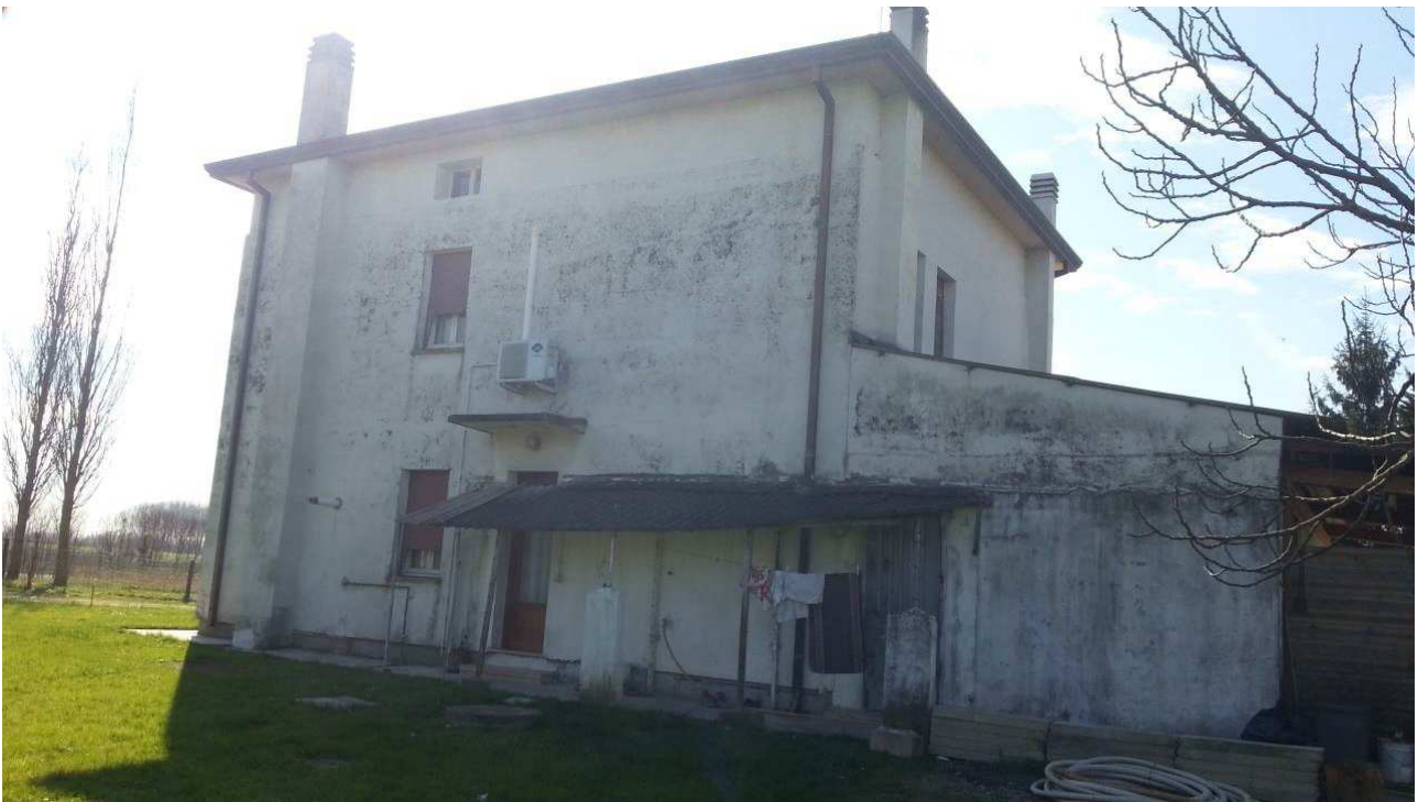
Foto n.5: Prospetto Nord dell'abitazione (Sub.3) oggetto di E.I.
