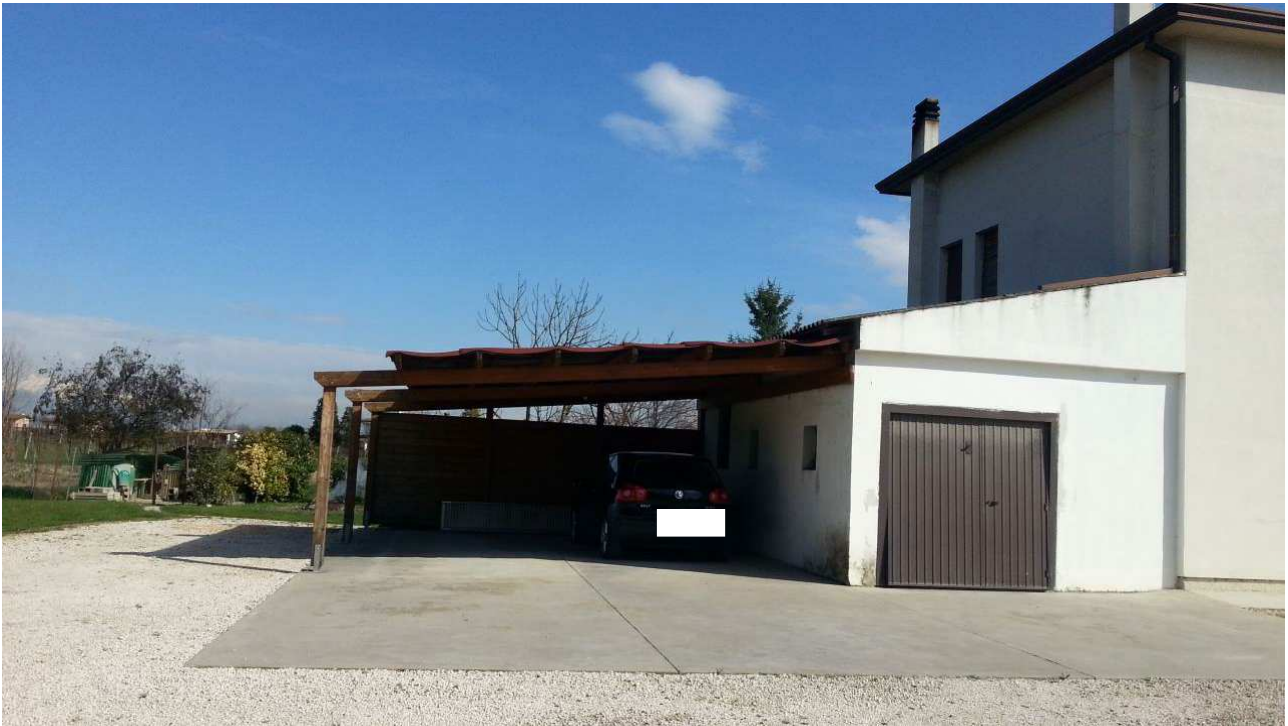
Foto n.19: Tettoia al P.T. oggetto di E.I. (Sub.3).
