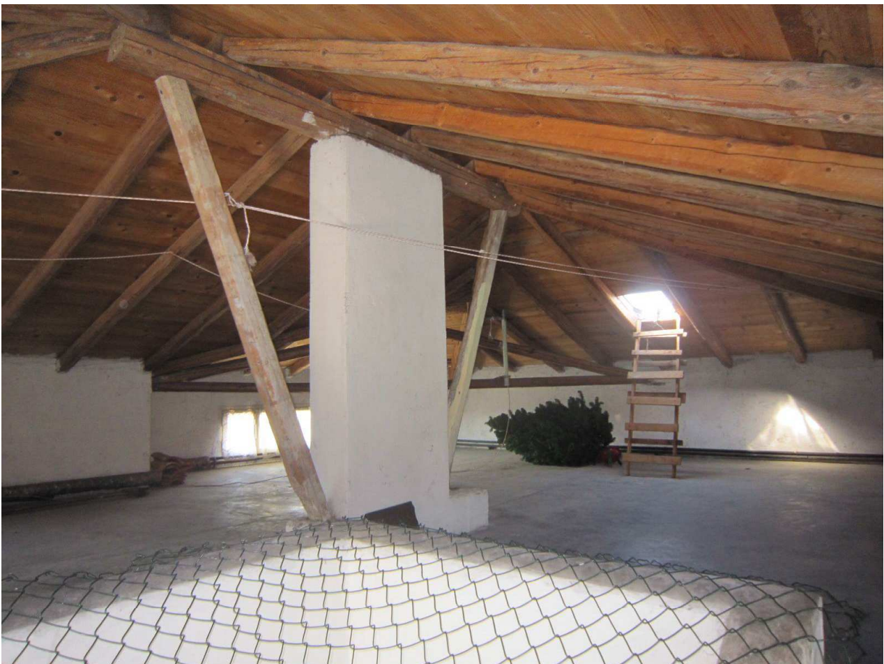
Foto n.16: Soffitta al 2°P. oggetto di E.I. (Sub.3).
