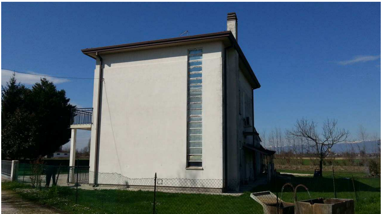
Foto n.4: Prospetto Est dell'abitazione (Sub.3) oggetto di E.I.
