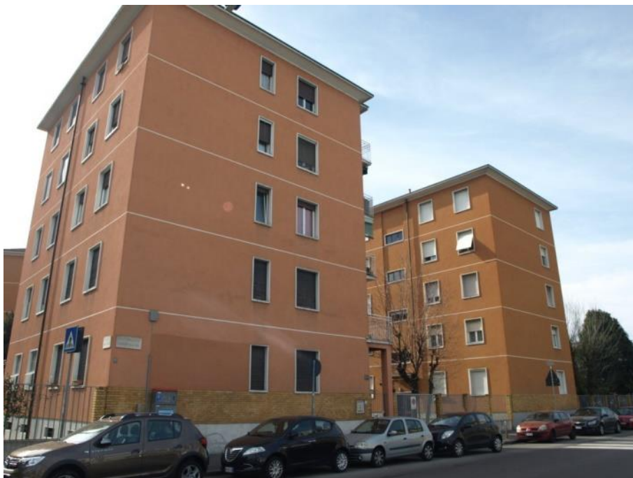
COMPLESSO EDILIZIO VIA LORENTEGGIO 209
