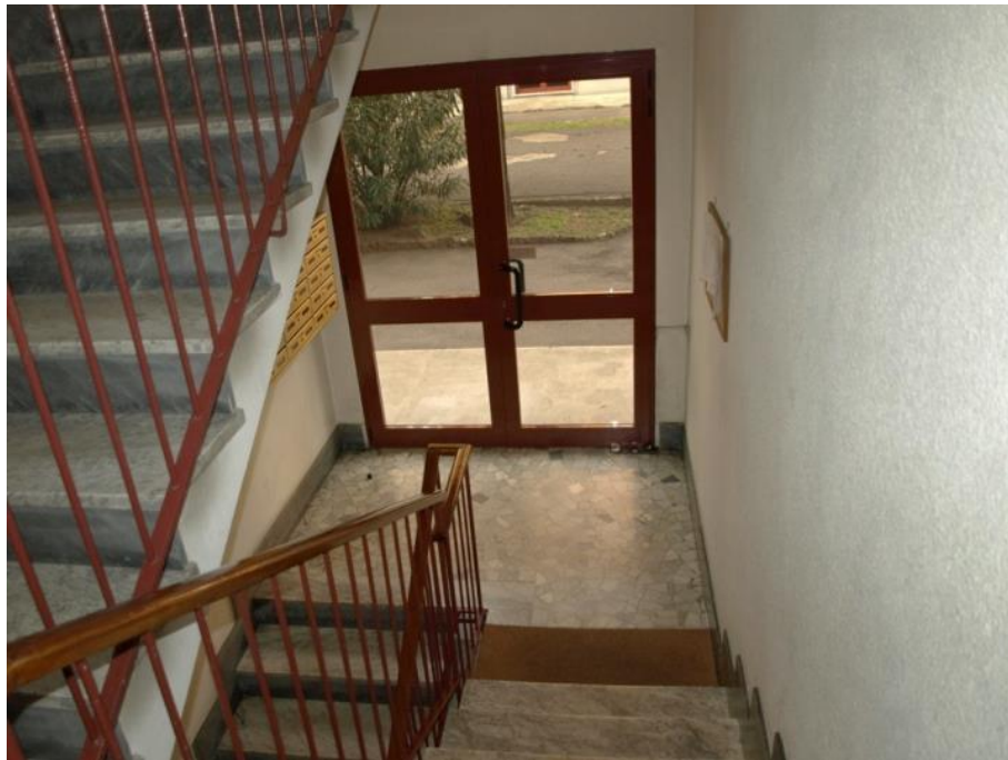
ZONA INGRESSO PIANO TERRA
