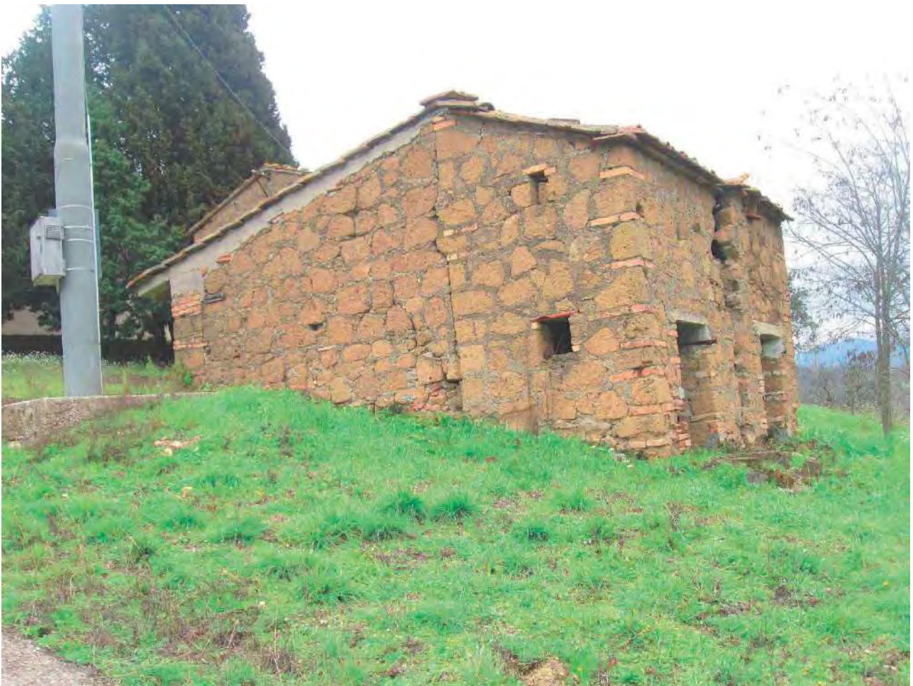
Foto 72 – Corpo 3 prospetto forno e cantine
