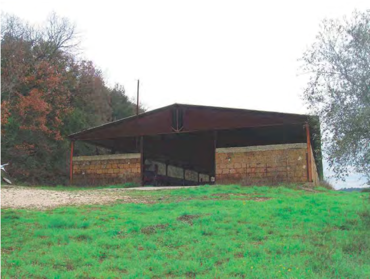
Foto 92 – Corpo 6 stalla – rimessa attrezzi – prospetto frontale
