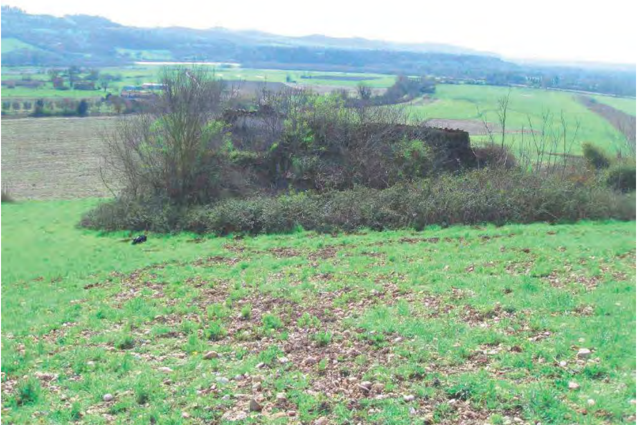
Foto 113 – Corpo 12 Fabbricato diruto – elementi visibili attraverso gli arbusti
