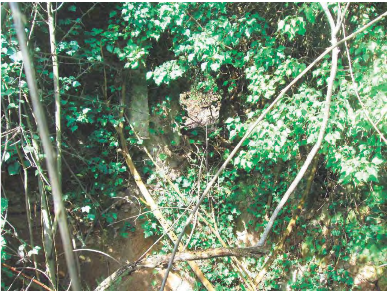
Foto 108 – Corpo 10 Fabbricato diruto – particolare muri rimanenti nella macchia
