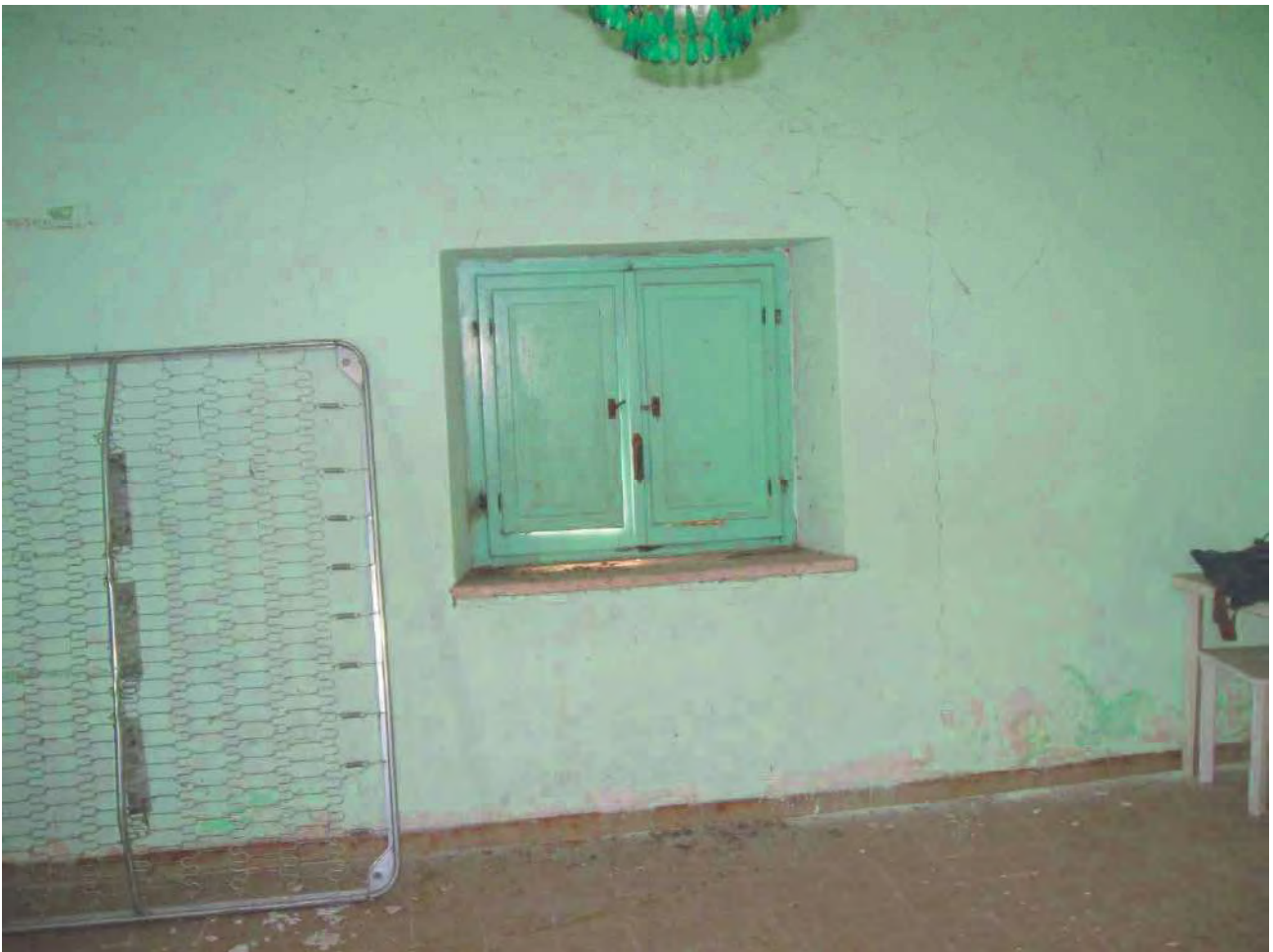
Foto 83 – Corpo 3 particolare interno
