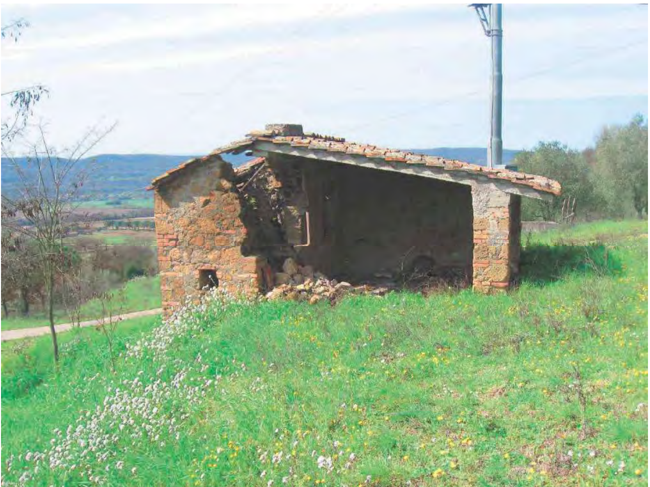
Foto 73 – Corpo 2C particolare prospetto forno
