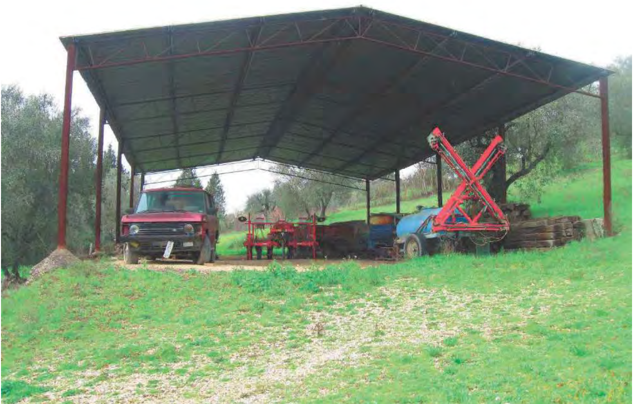
Foto 99 – Corpo 7 rimessa mezzi agricoli – prospetto frontale
