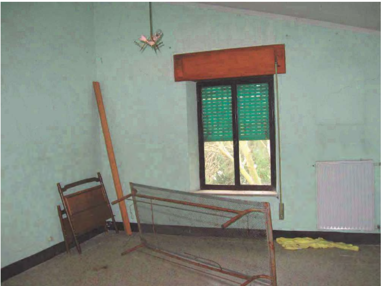
Foto 28 – Corpo 1B – particolare camera
