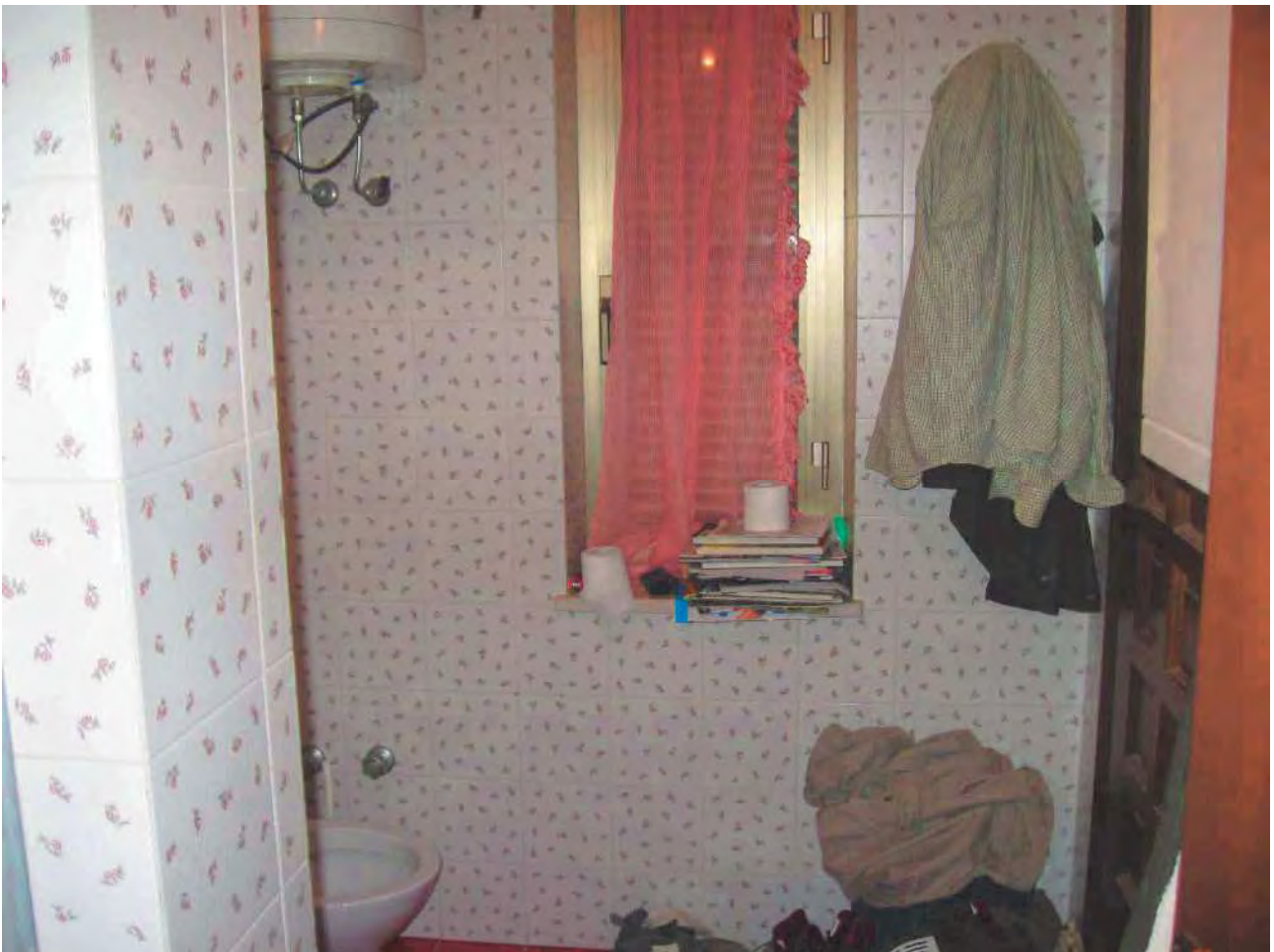
Foto 52 – Corpo 2A particolare bagno
