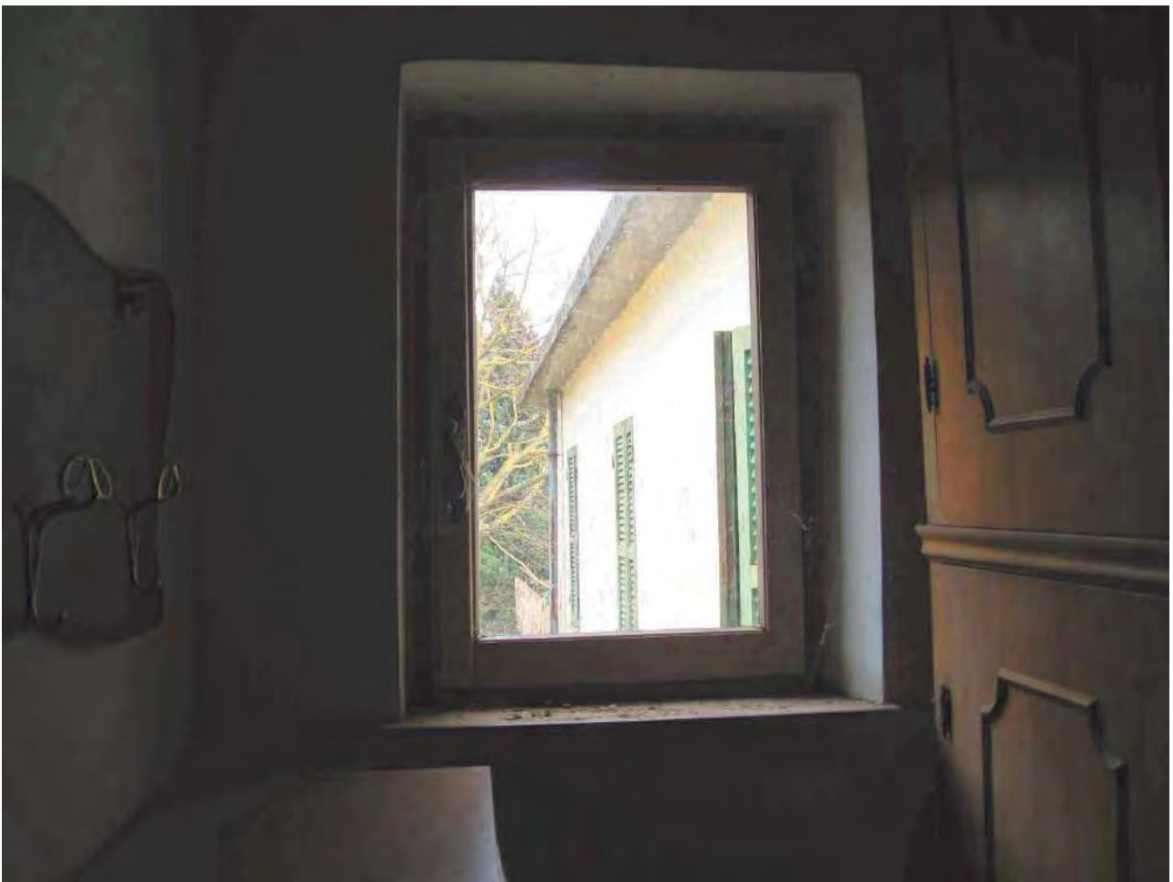
Foto35 – Corpo 1B particolare antibagno
