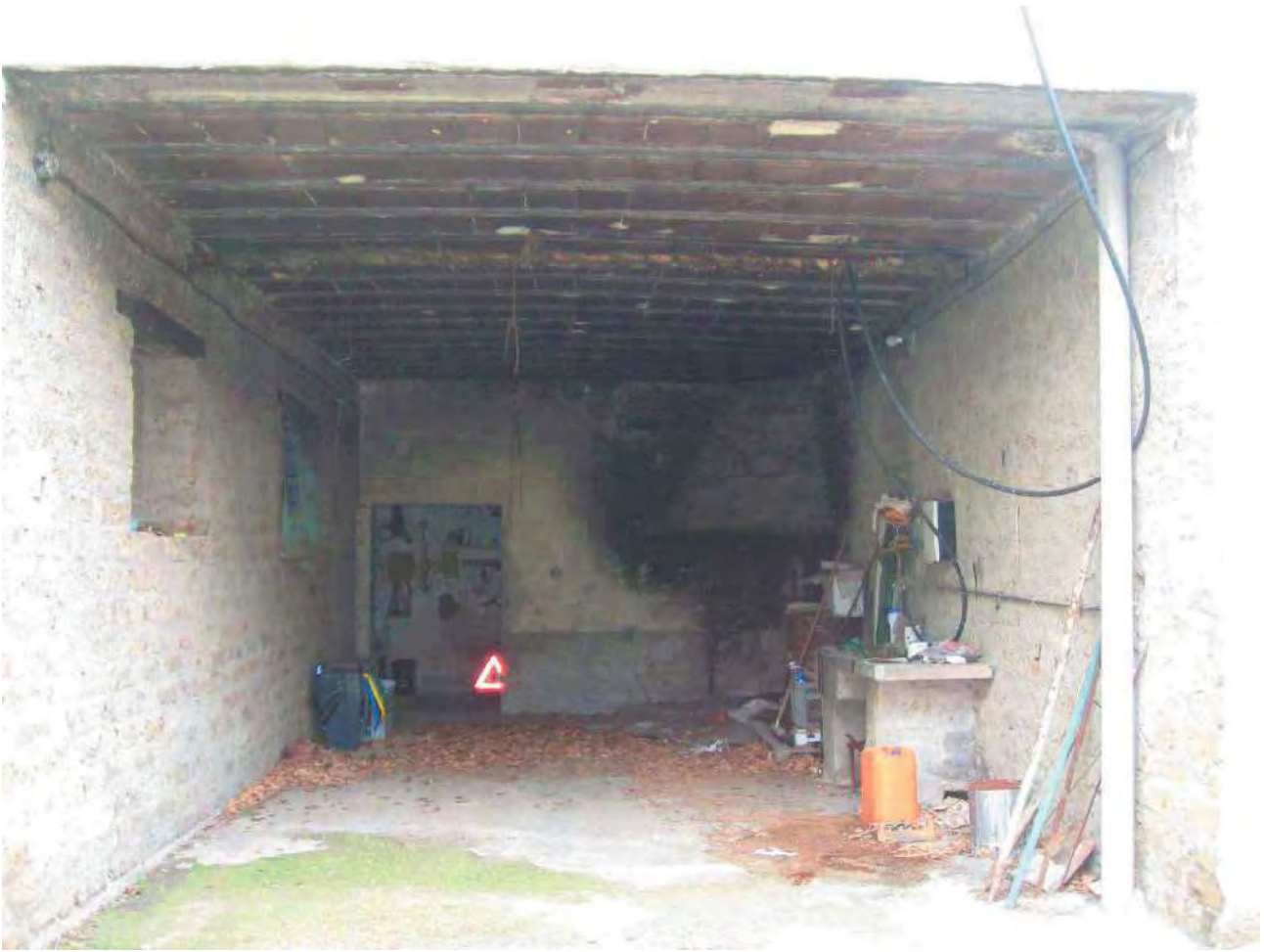
Foto 15 – Corpo 1A particolare ingresso magazzini piano terra
