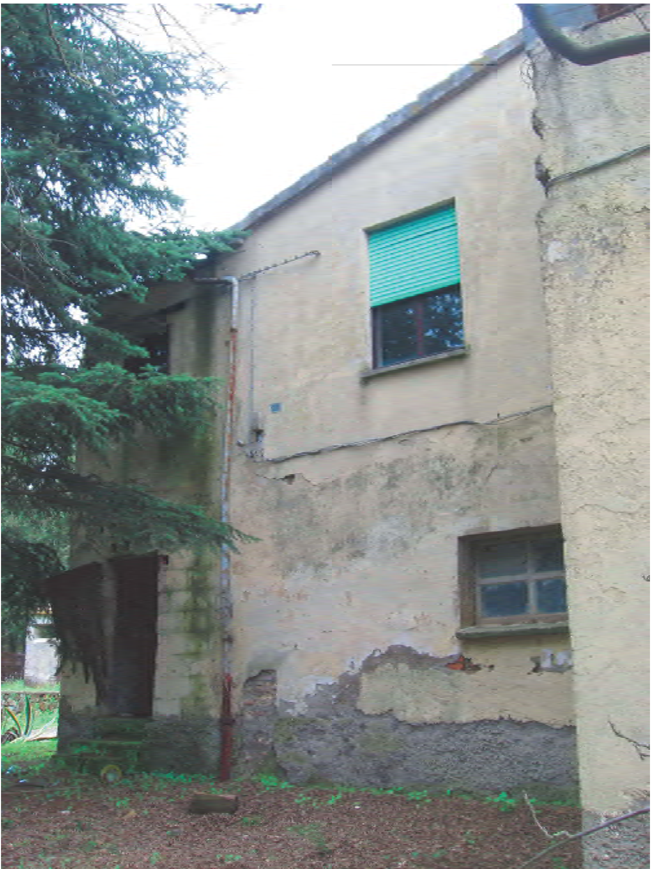
Foto 7 – Corpo 1 Prospetto posteriore
