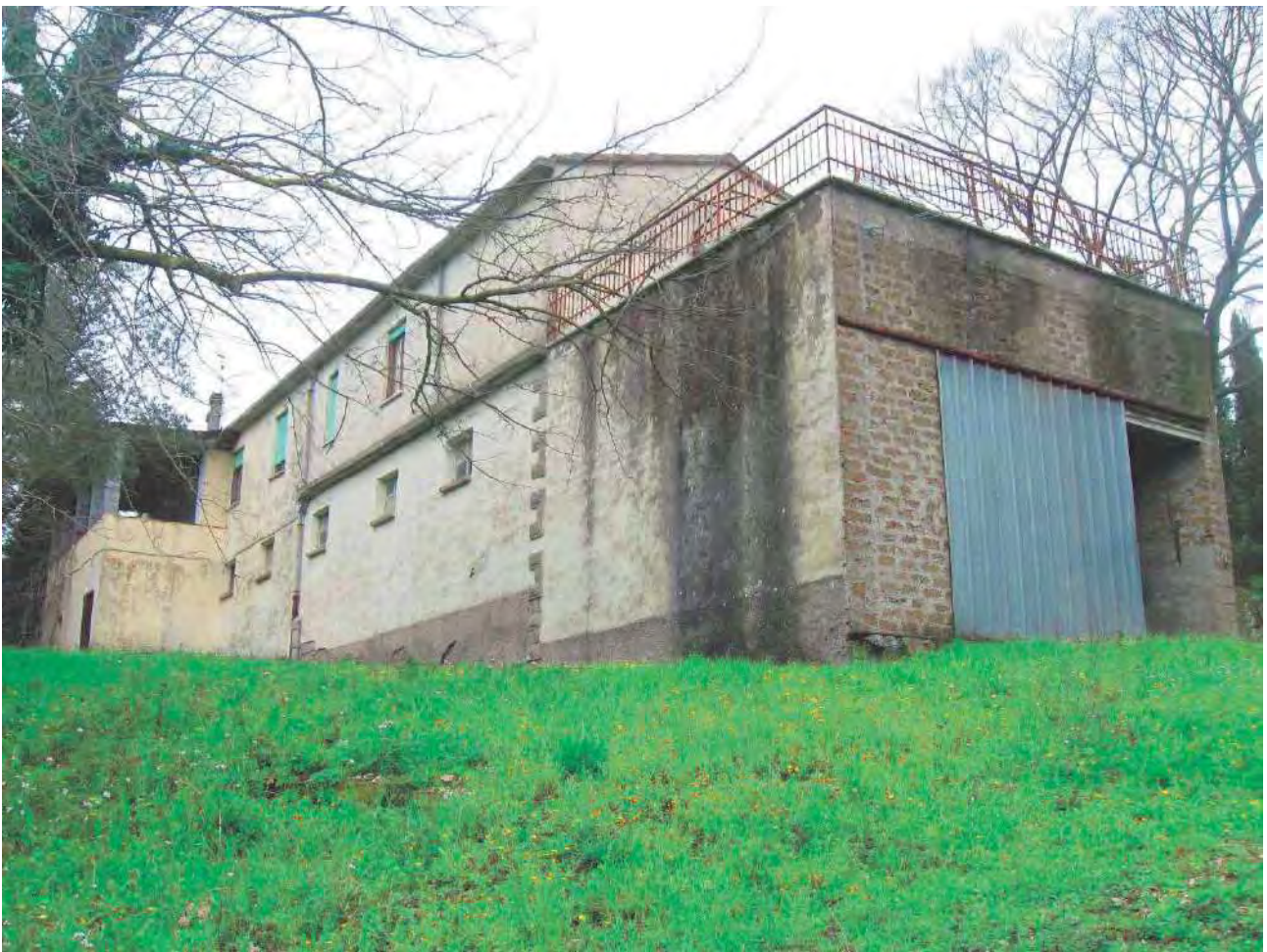
Foto 1 – Corpo 1 Prospetto posteriore
