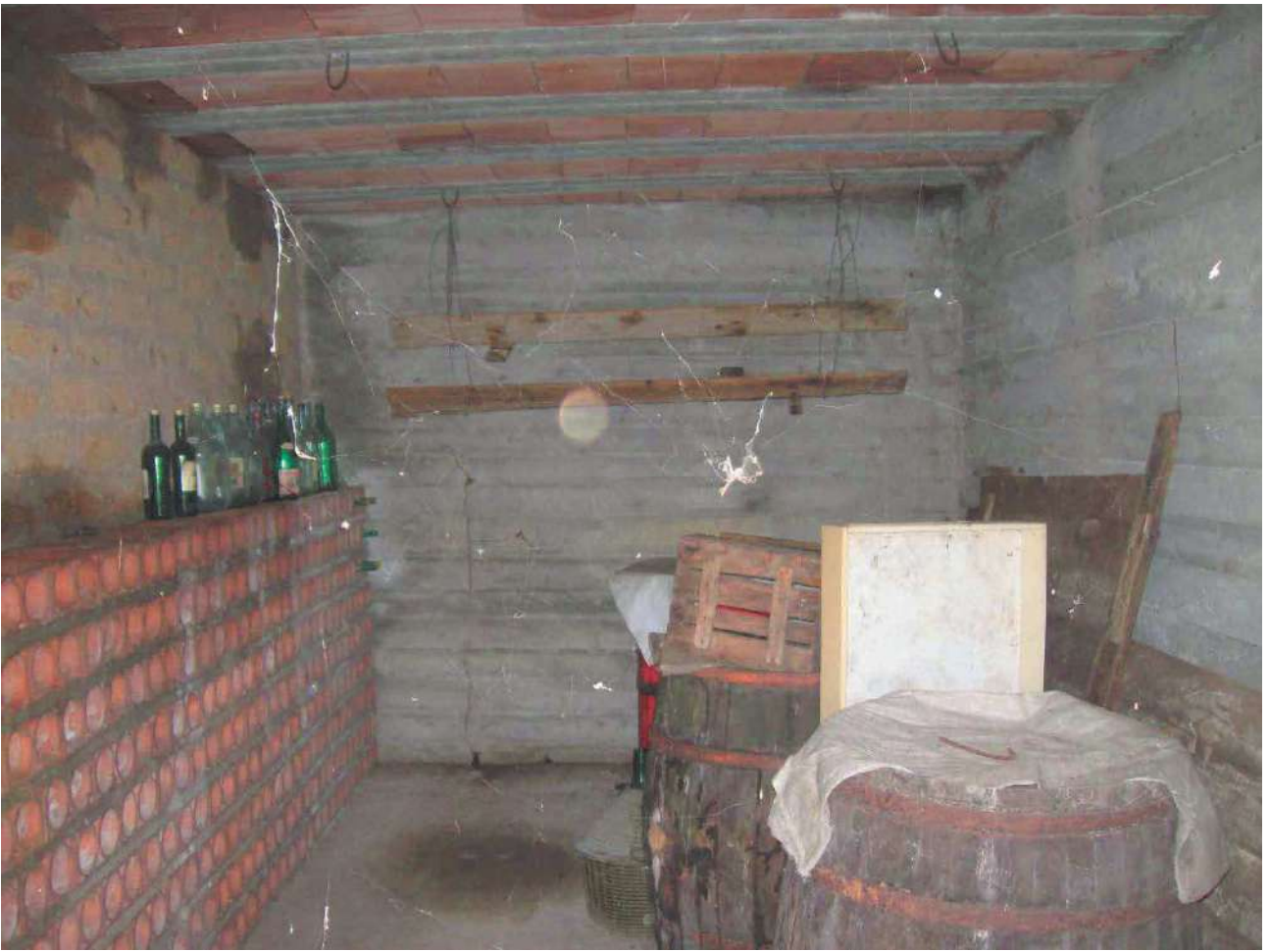
Foto 17 – Corpo 1A particolare cantina 1
