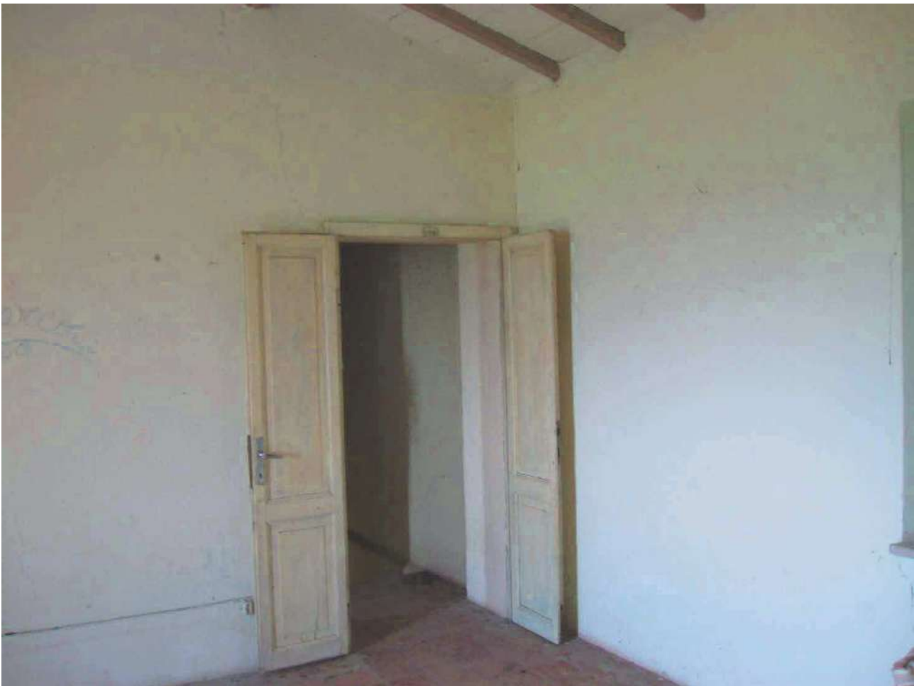
Foto 75 – Corpo 3 particolare interno
