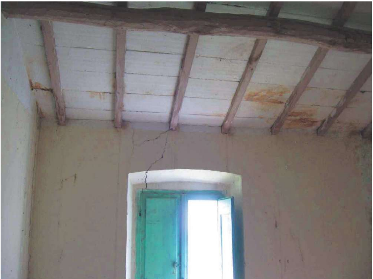
Foto 79 – Corpo 3 particolare interno
