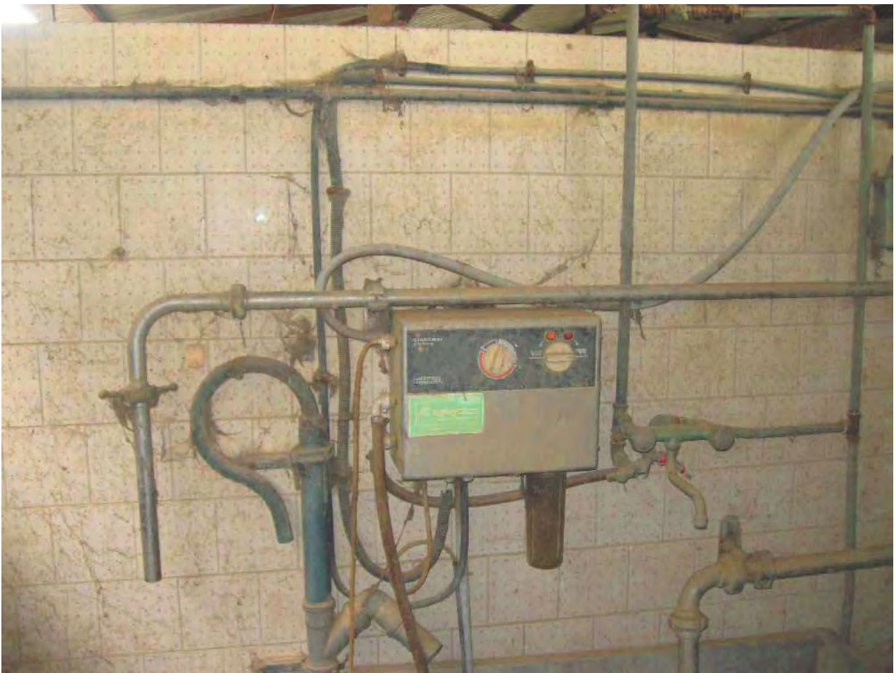
Foto 96 – Corpo 6 stalla – rimessa attrezzi – particolare interno
