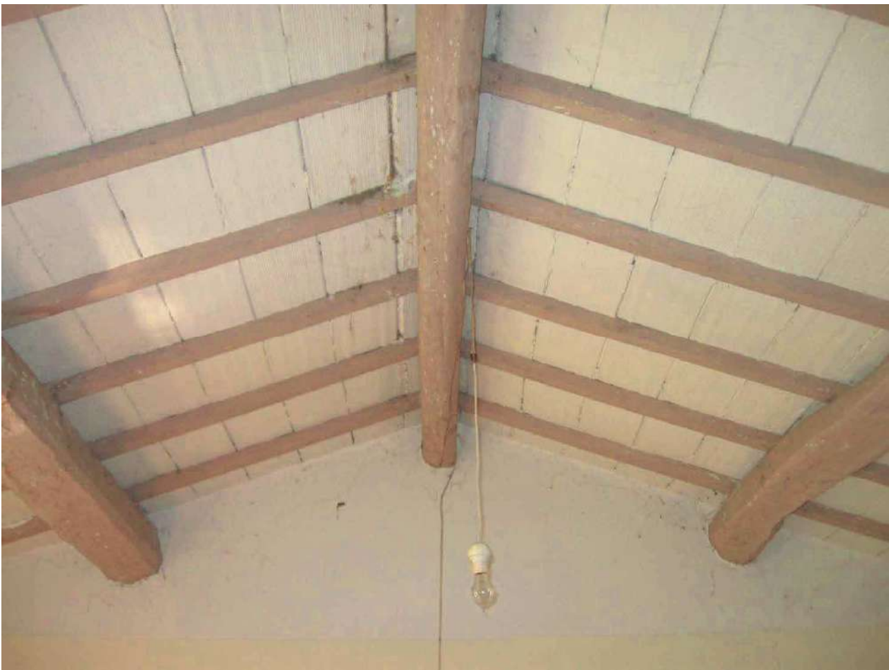
Foto 74 – Corpo 3 particolare copertura
