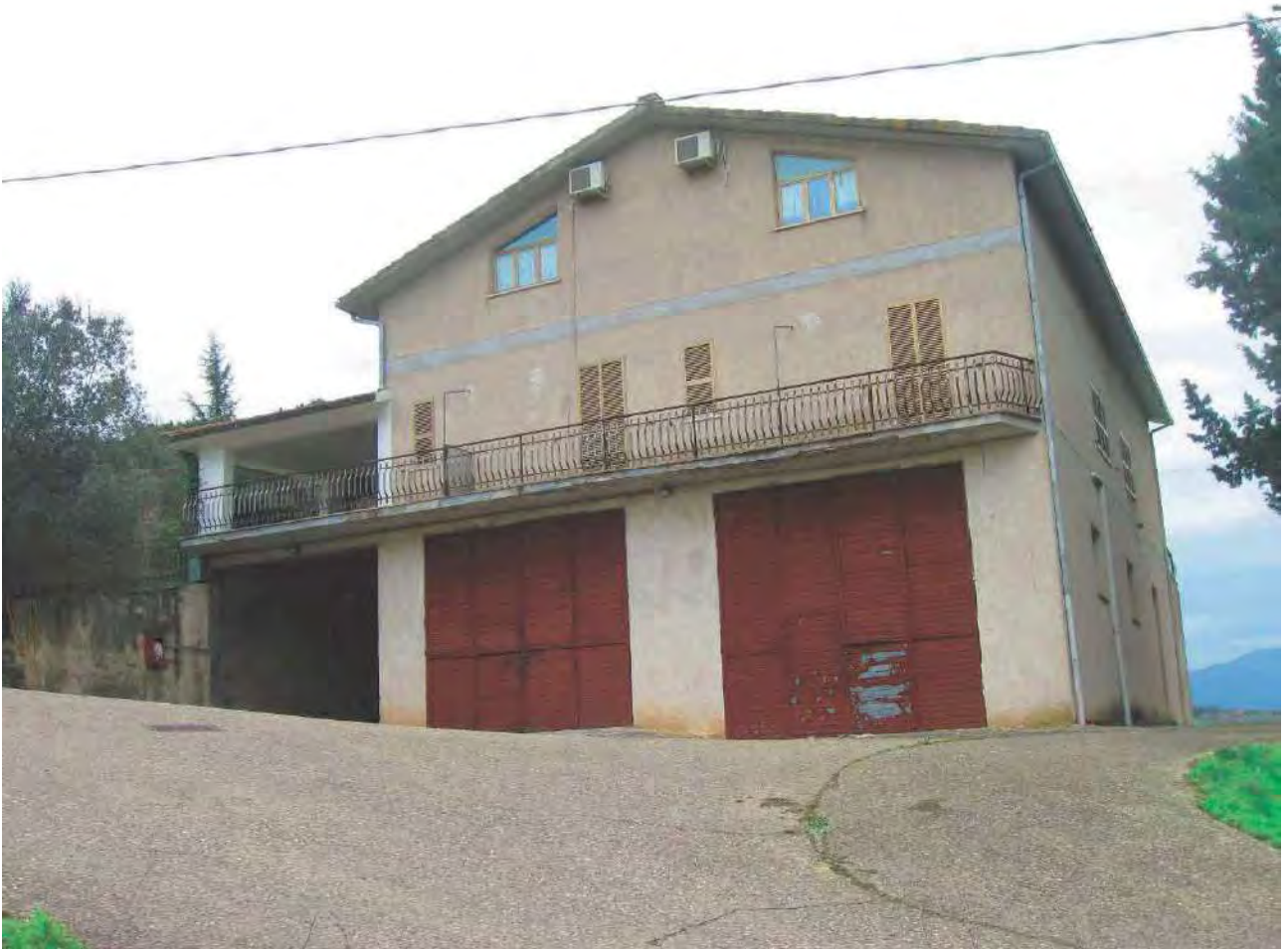
Foto 41 – Corpo 2A prospetto laterale
