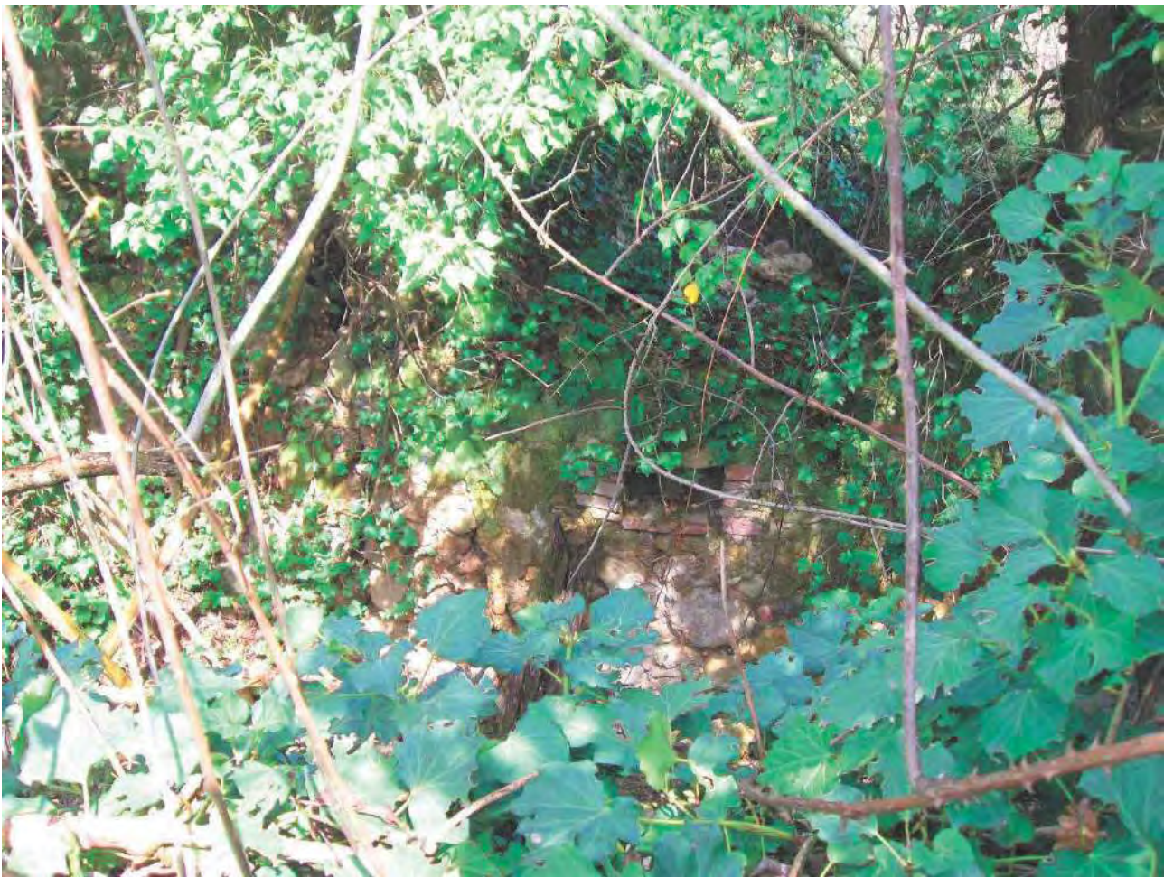
Foto 106 – Corpo 10 Fabbricato diruto – particolare muri rimanenti nella macchia
