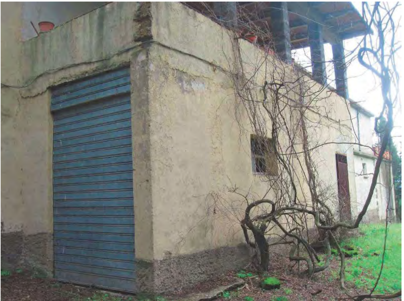
Foto 4 – Corpo 1 Prospetto posteriore
