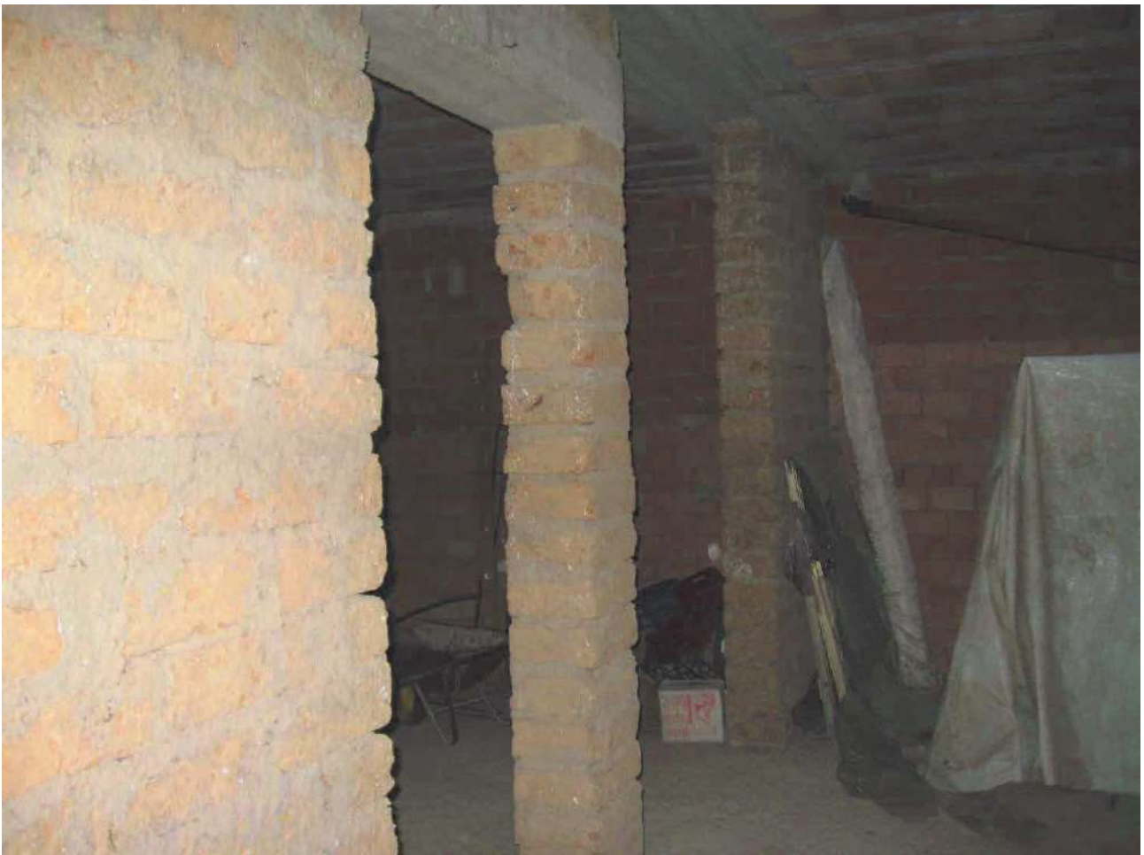
Foto 60 – Corpo 2B abitazione in corso di costruzione
