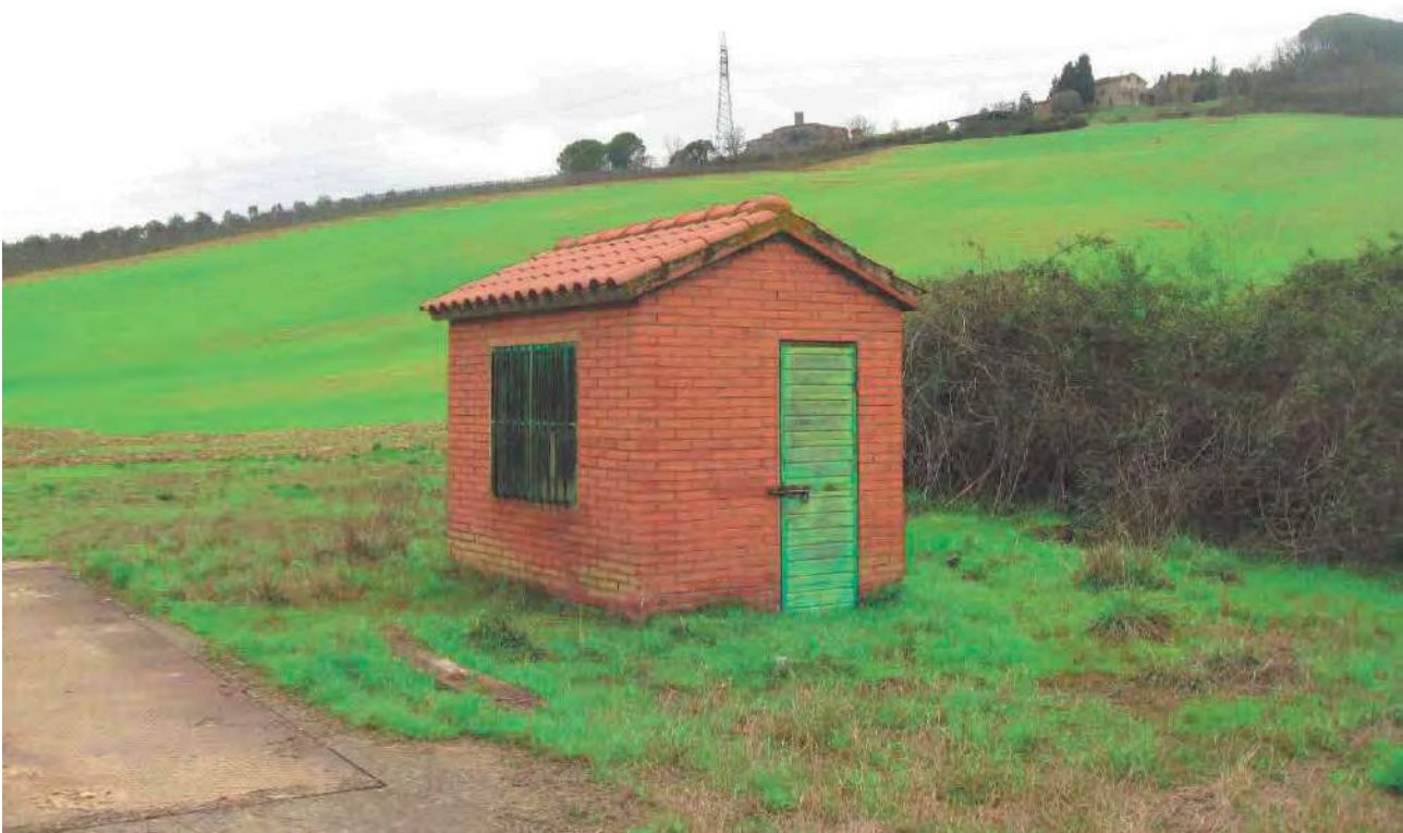
Foto 117 – Corpo 13 Bascula – locale di pesa prospetto frontale
