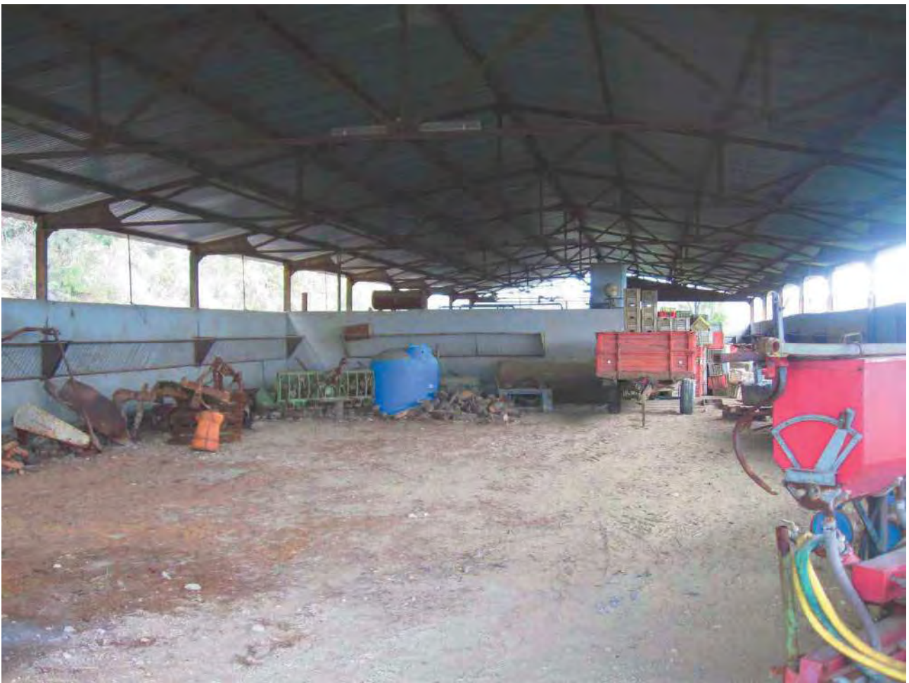
Foto 98 – Corpo 6 stalla – rimessa attrezzi – particolare interno
