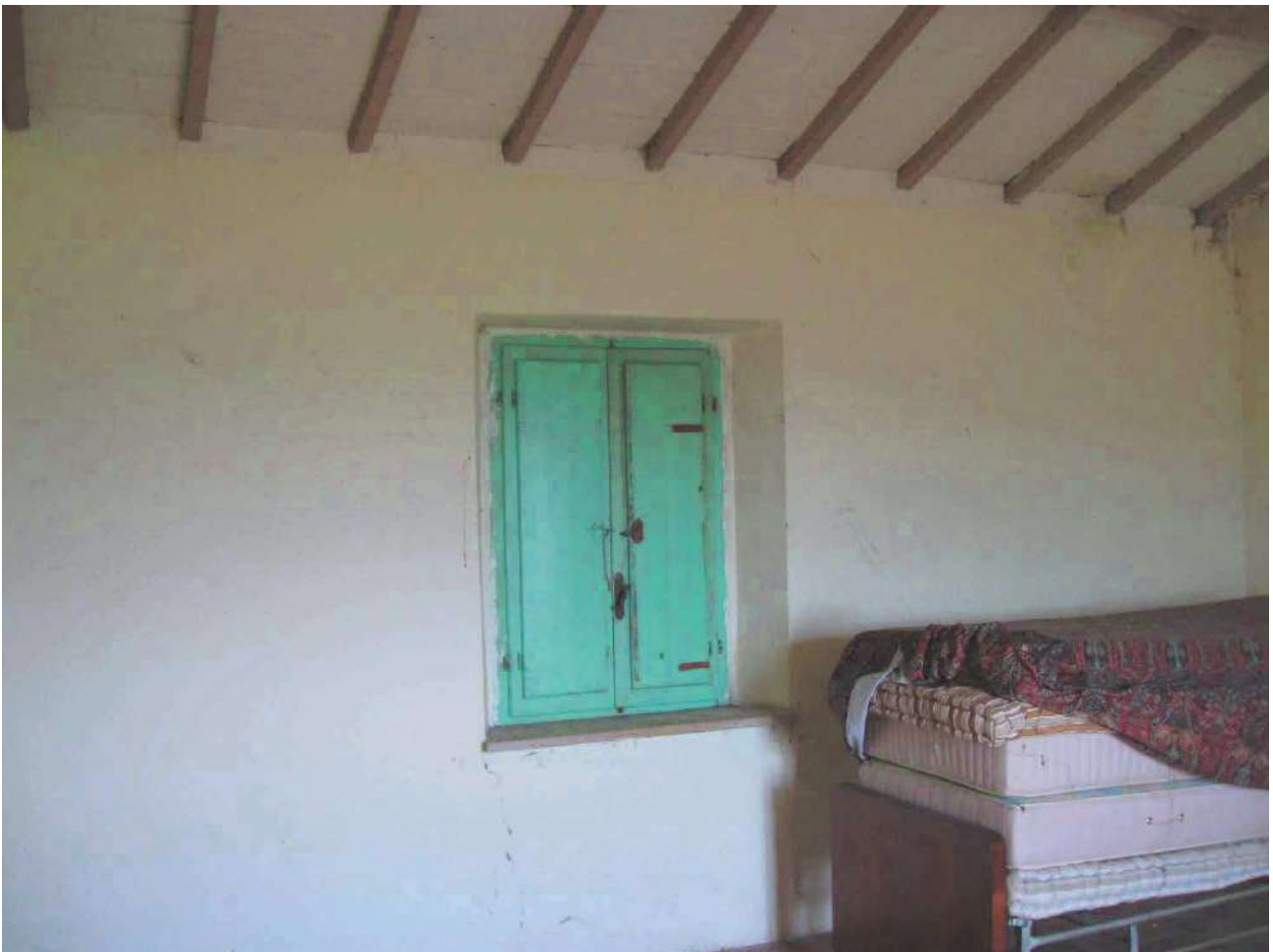
Foto 77 – Corpo 3 particolare interno
