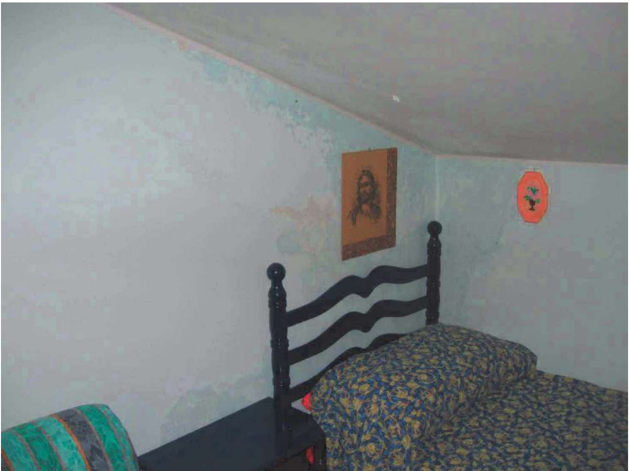
Foto 46 – Corpo 2A particolare camera
