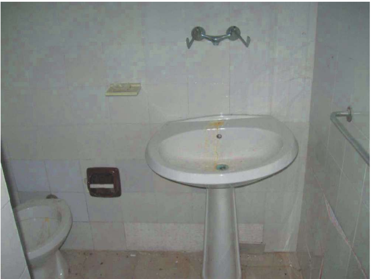
Foto 61 – Corpo 2C laboratorio piano terra particolare bagno
