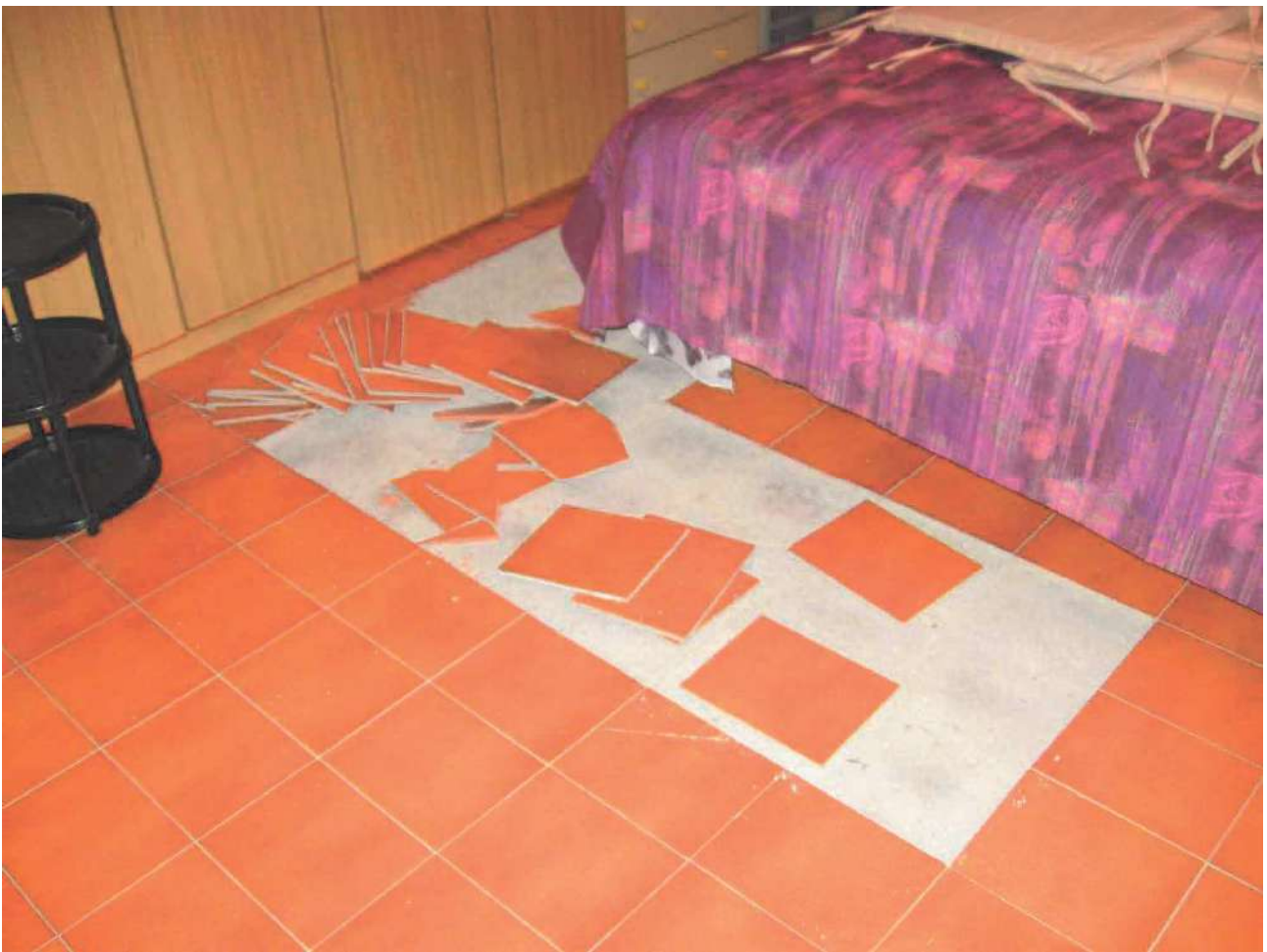
Foto 43 – Corpo 2A particolare camera
