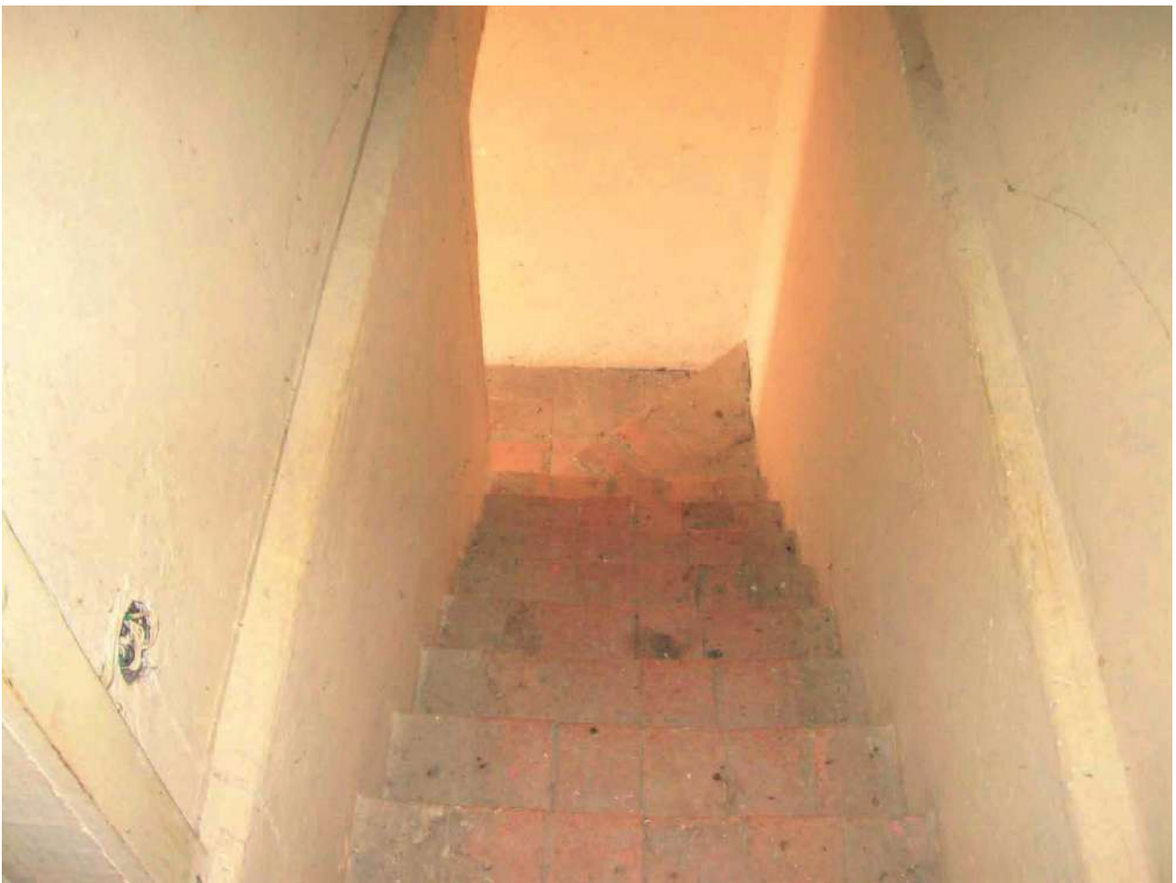
Foto 78 – Corpo 3 particolare scala interna
