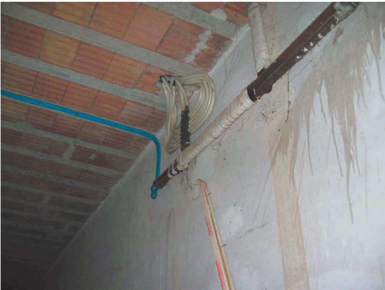
Foto 68 – Corpo 2C particolare interno magazzino
