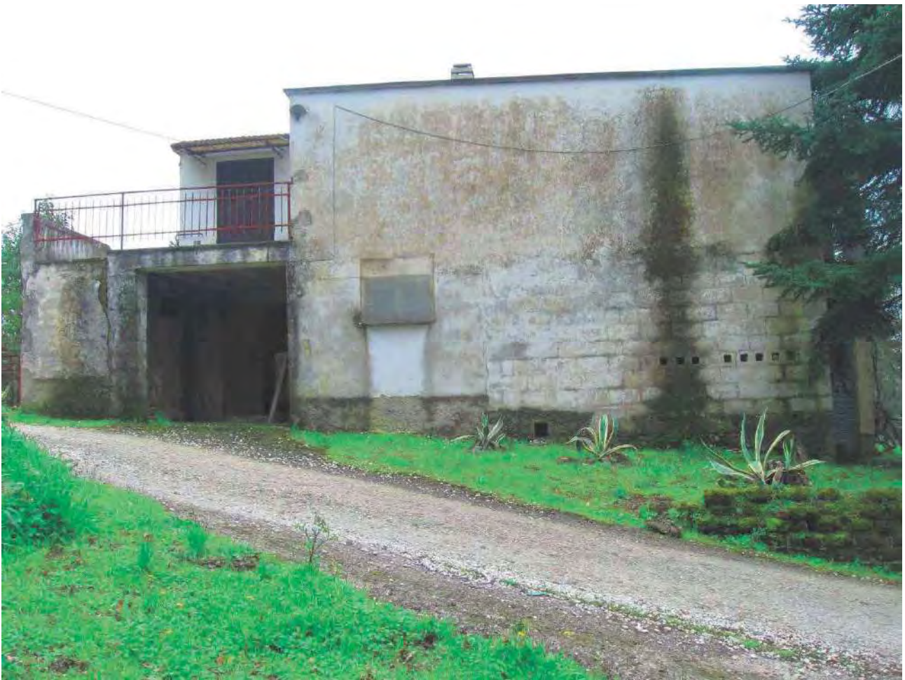
Foto 5 – Corpo 1 Prospetto laterale
