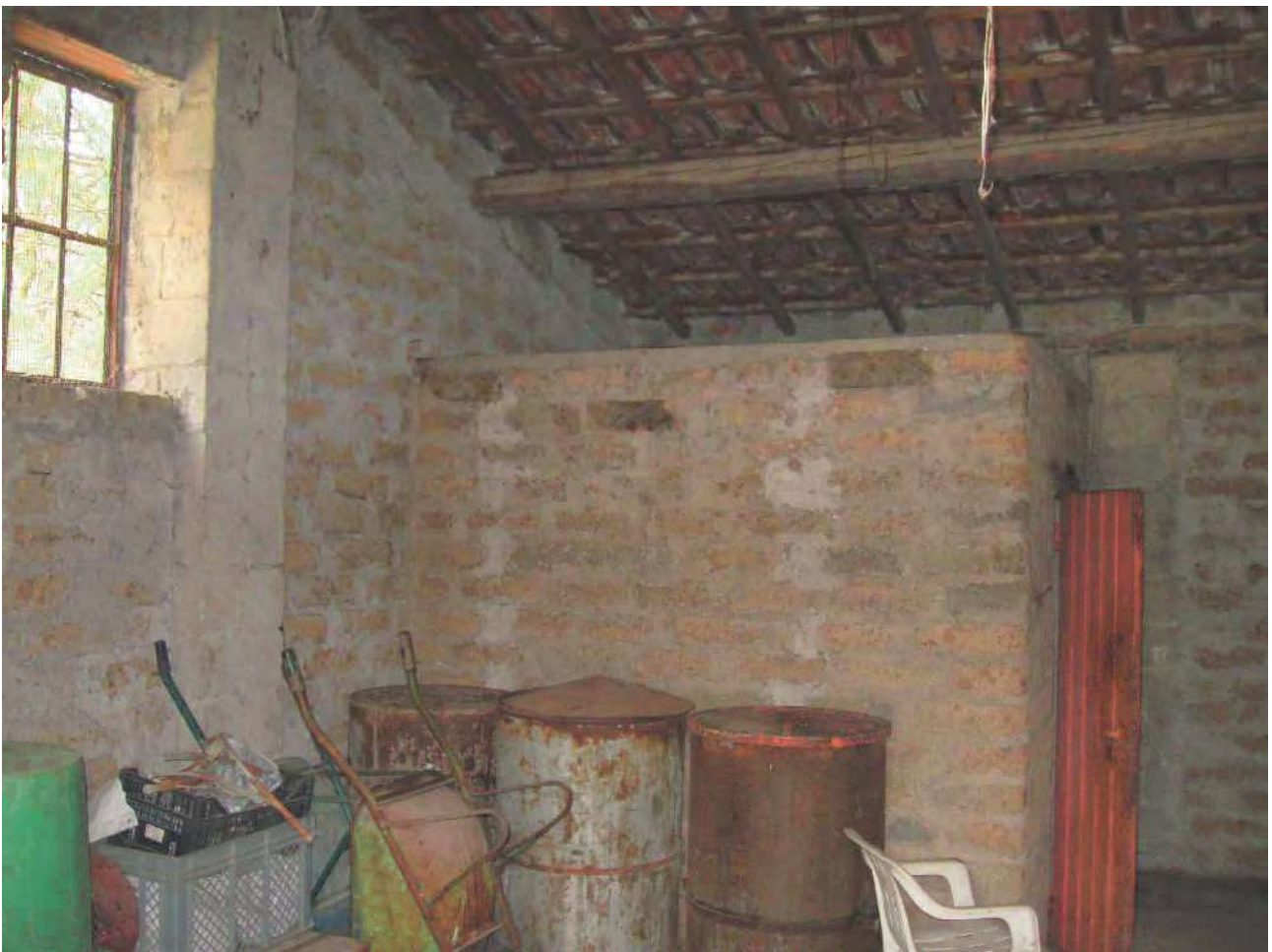
Foto 24 – Corpo 1A – particolare interno rimessa attrezzi
