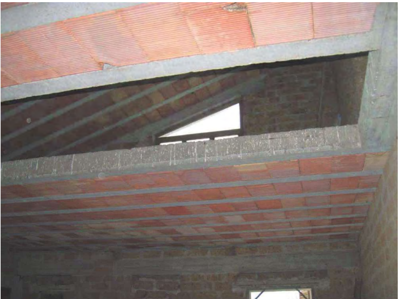
Foto 58 – Corpo 2B abitazione in corso di costruzione
