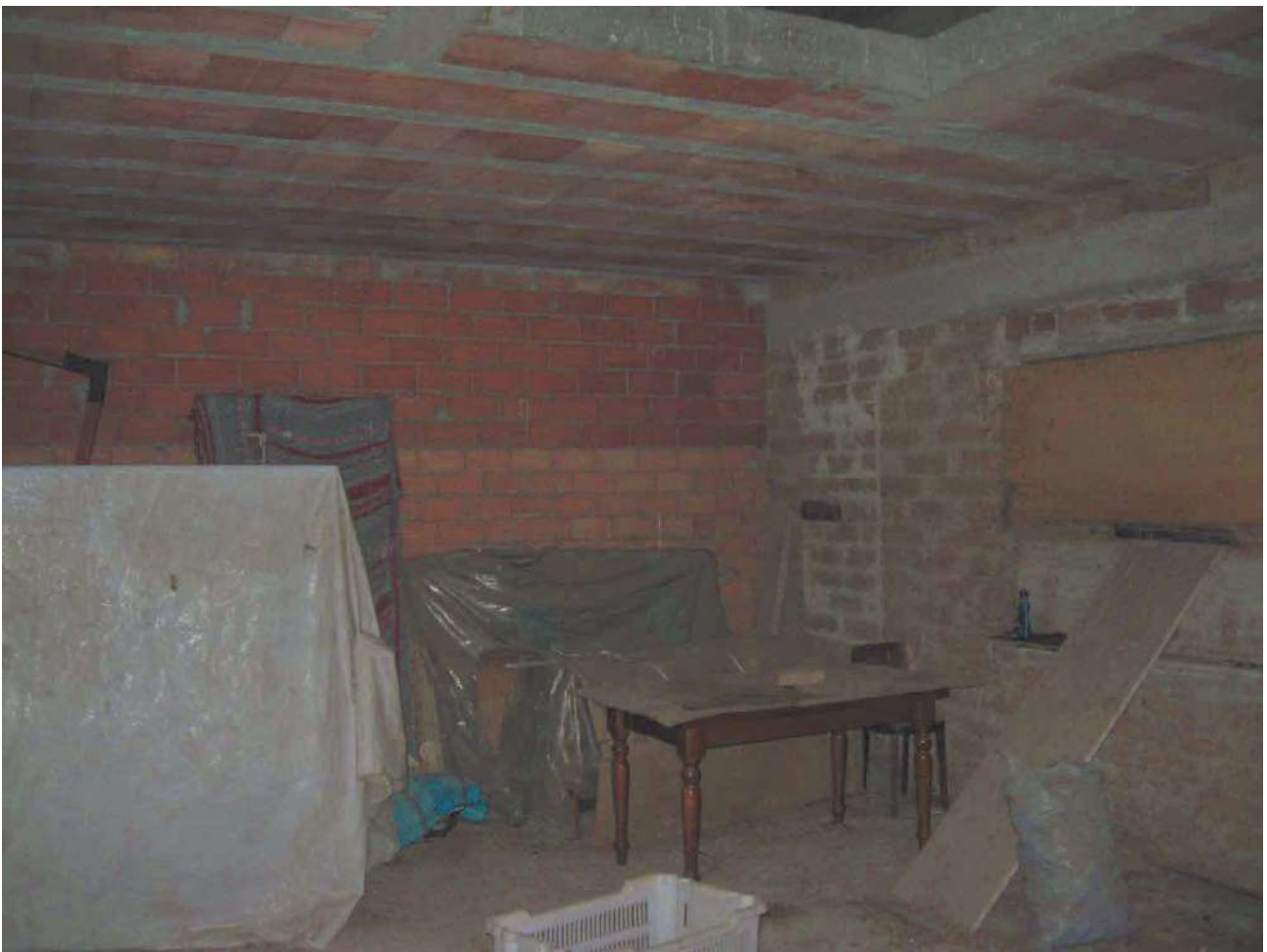
Foto 59 – Corpo 2B abitazione in corso di costruzione
