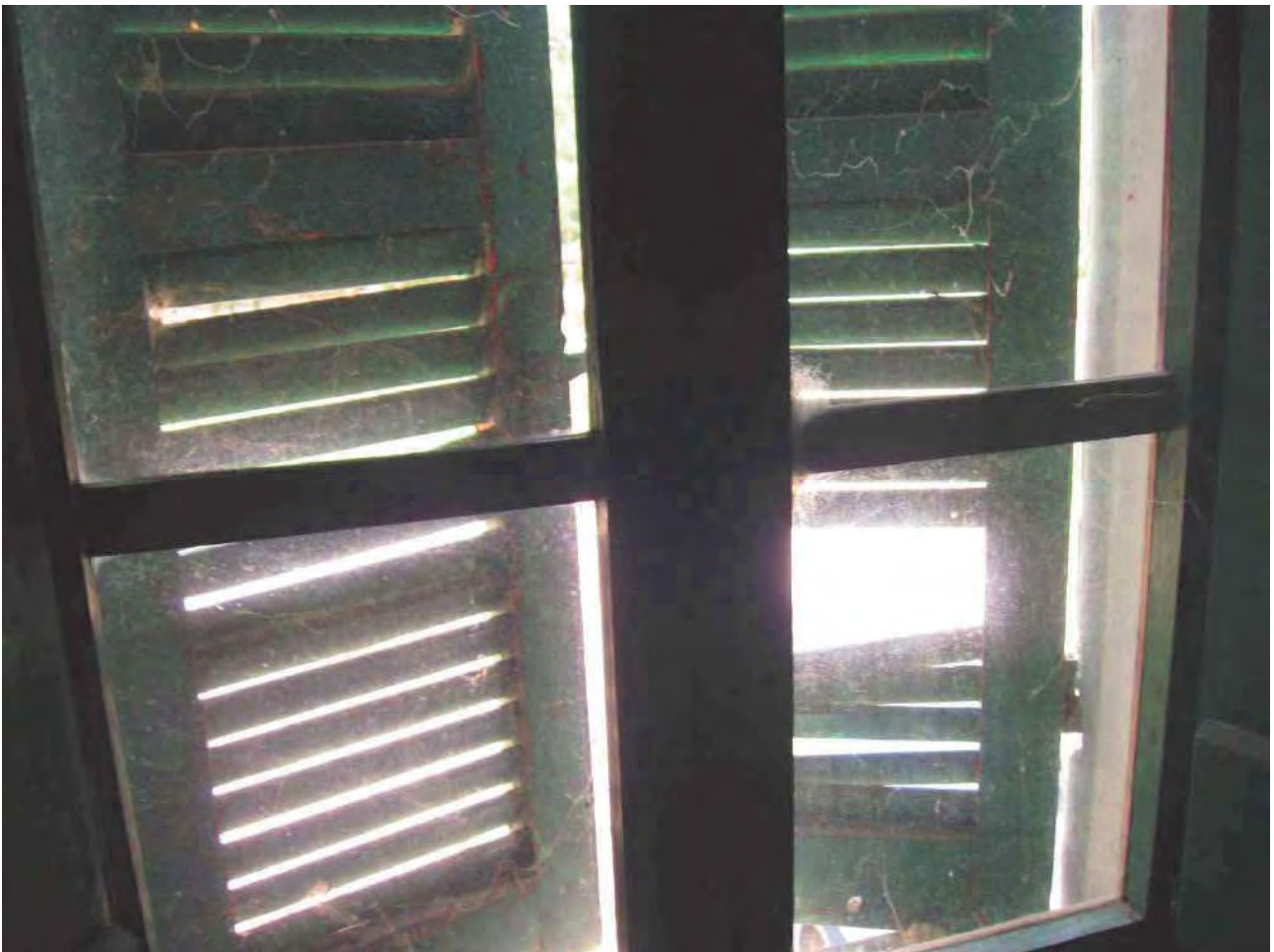
Foto 36 – Corpo 1B particolare infisso
