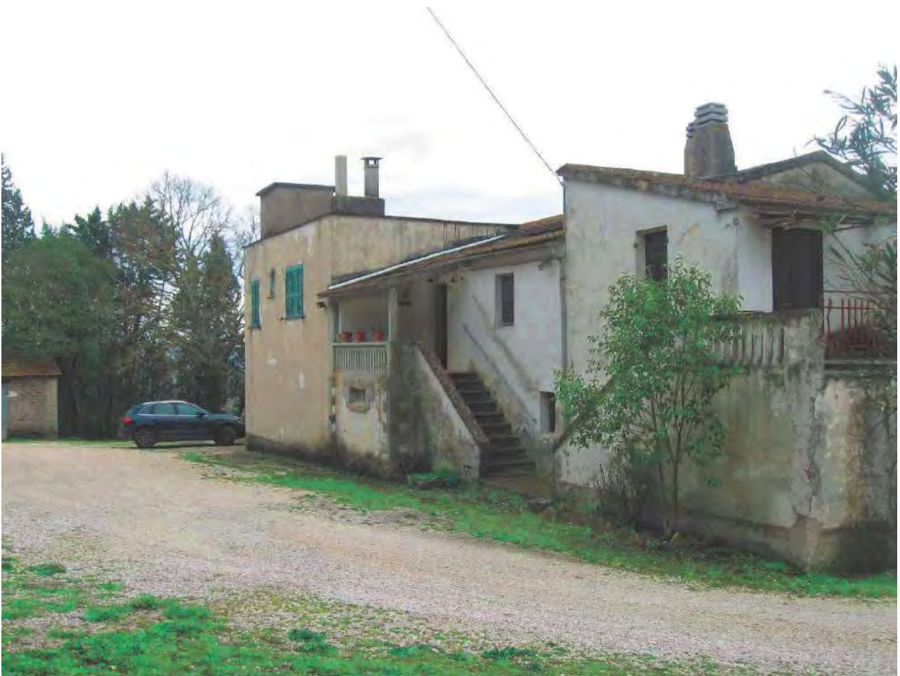
Foto 6 – Corpo 1 Prospetto frontale
