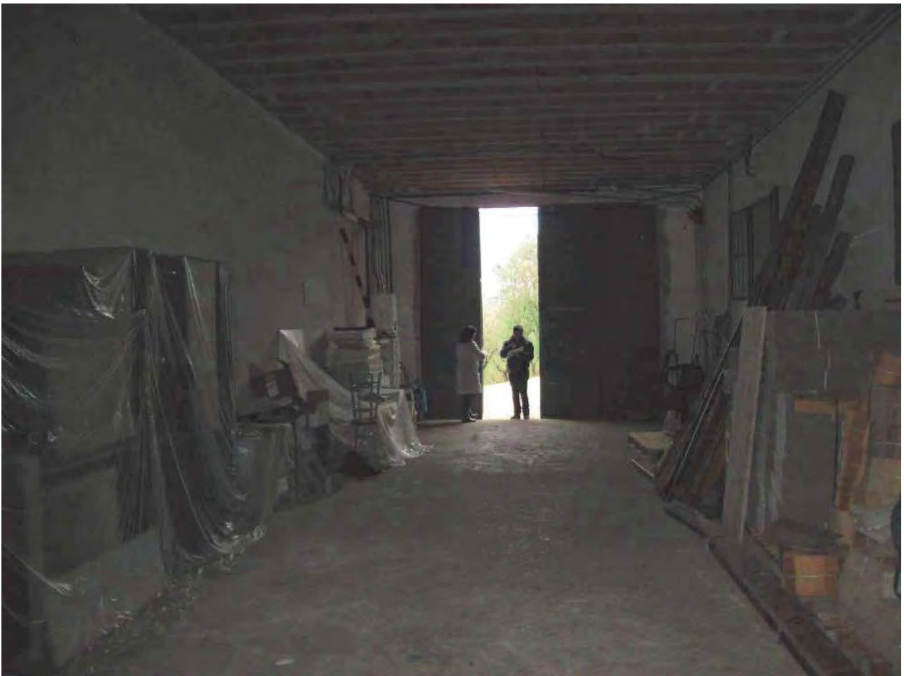
Foto 67 – Corpo 2C particolare interno magazzino
