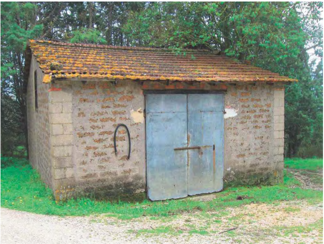
Foto 23 – Corpo 1A Rimessa attrezzi
