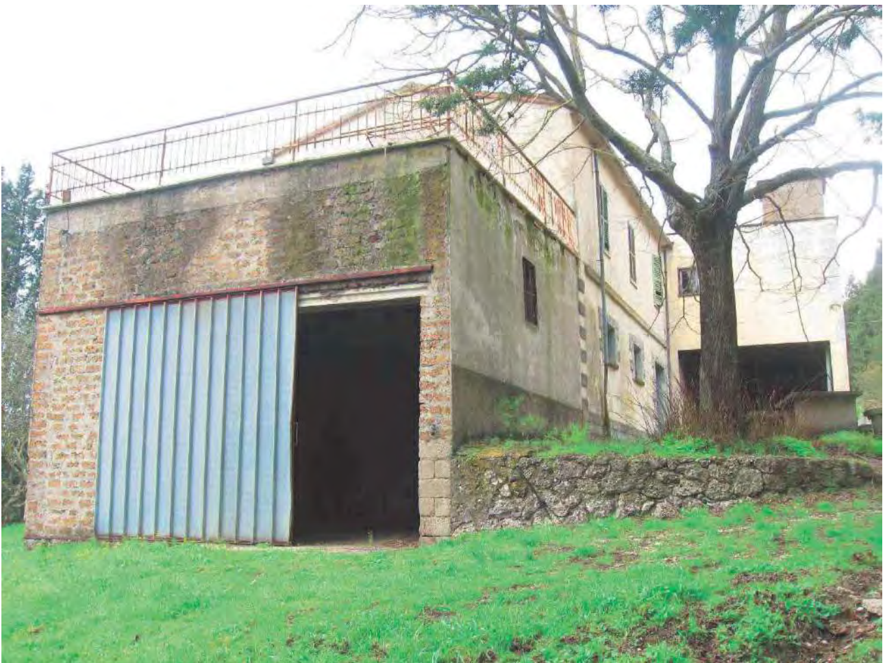
Foto 2 – Corpo 1 Prospetto frontale
