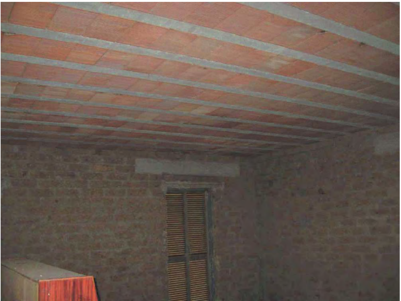
Foto 57 – Corpo 2B abitazione in corso di costruzione
