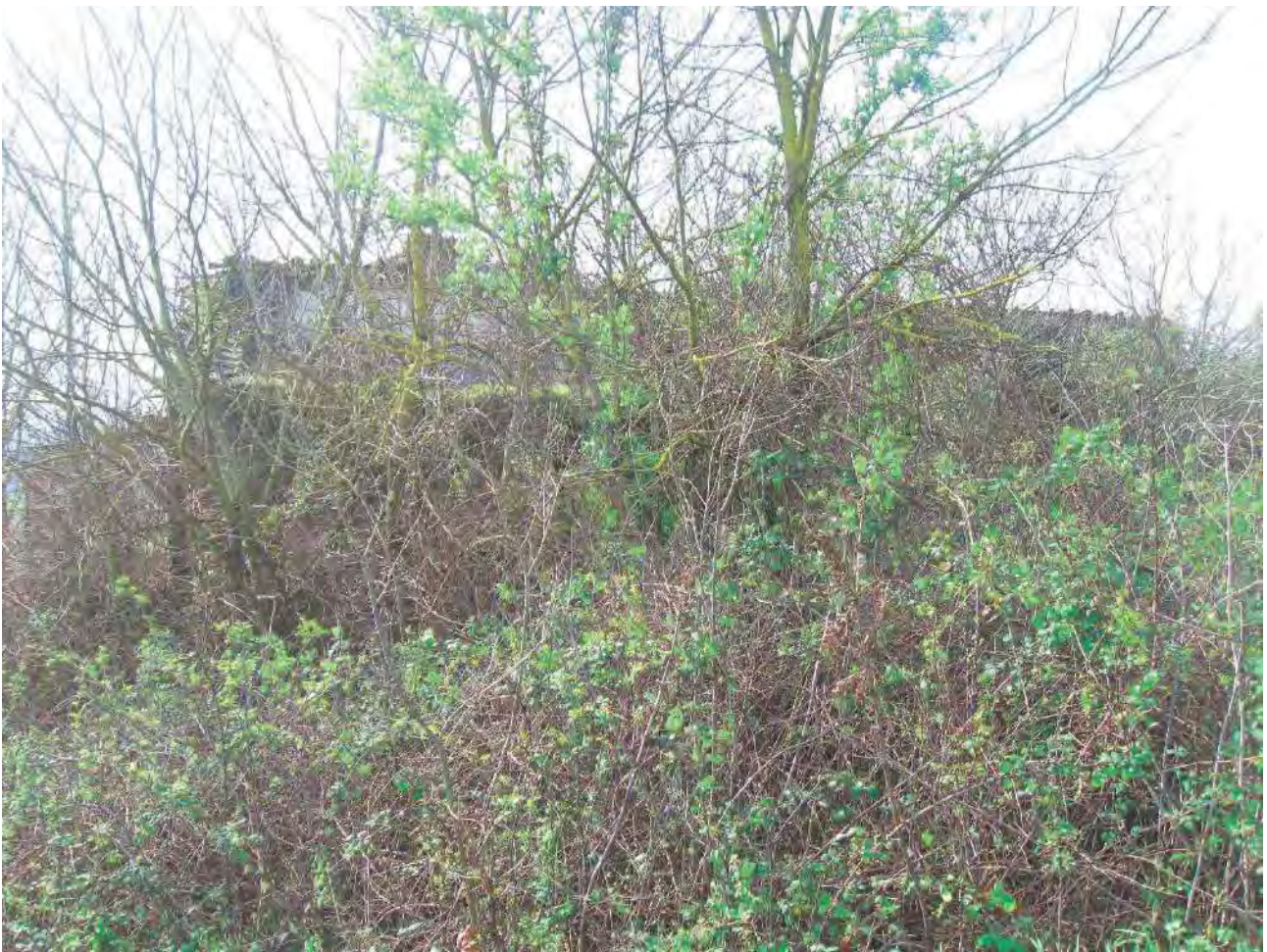
Foto 112 – Corpo 12 Fabbricato diruto – elementi visibili attraverso gli arbusti
