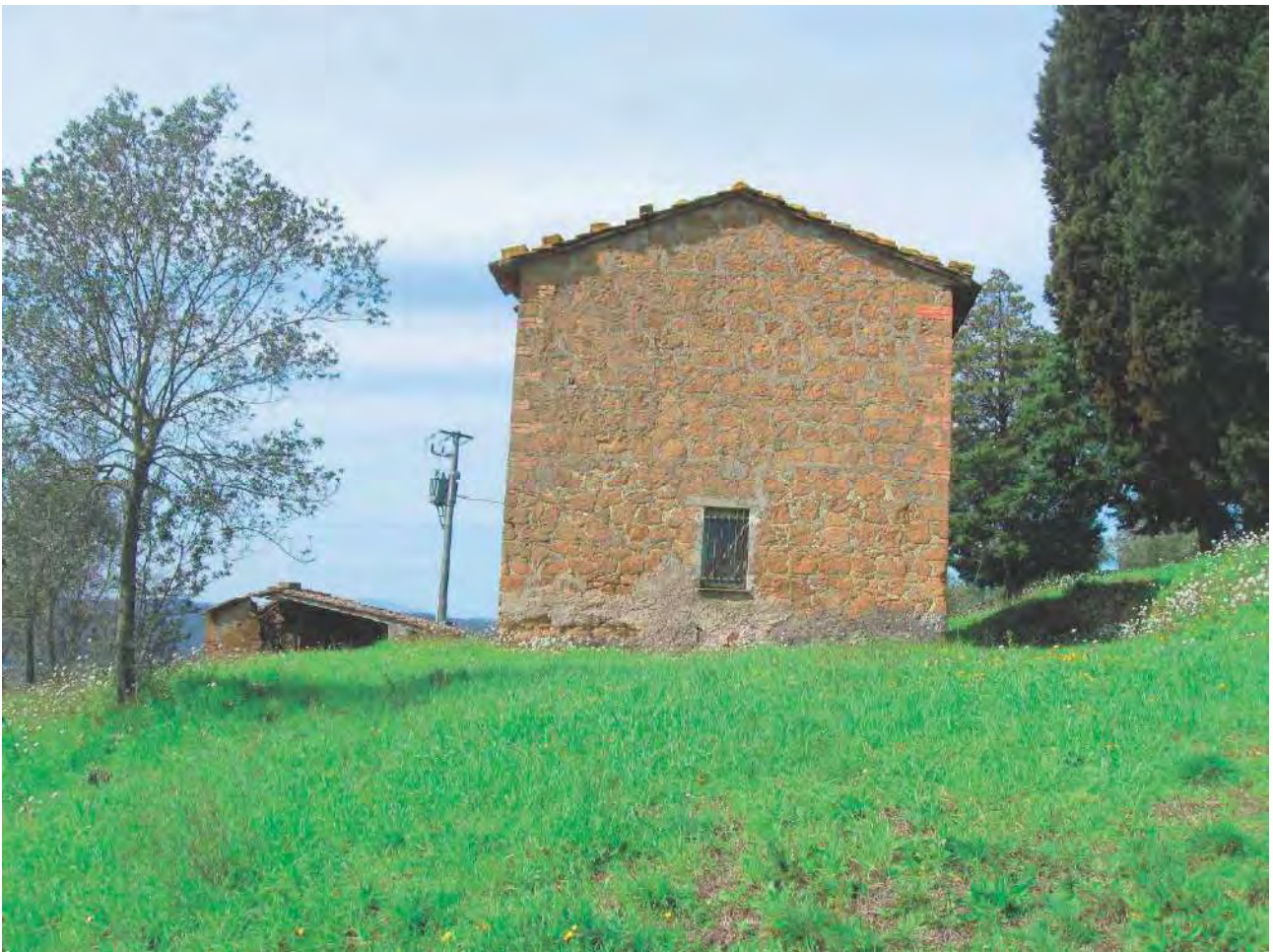
Foto 71 – Corpo 3 prospetto laterale
