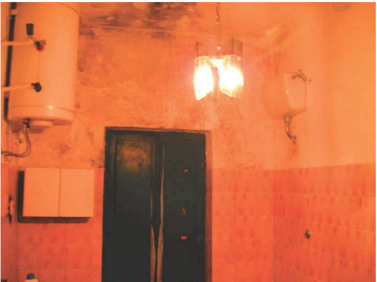
Foto 34 – Corpo 1B particolare bagno
