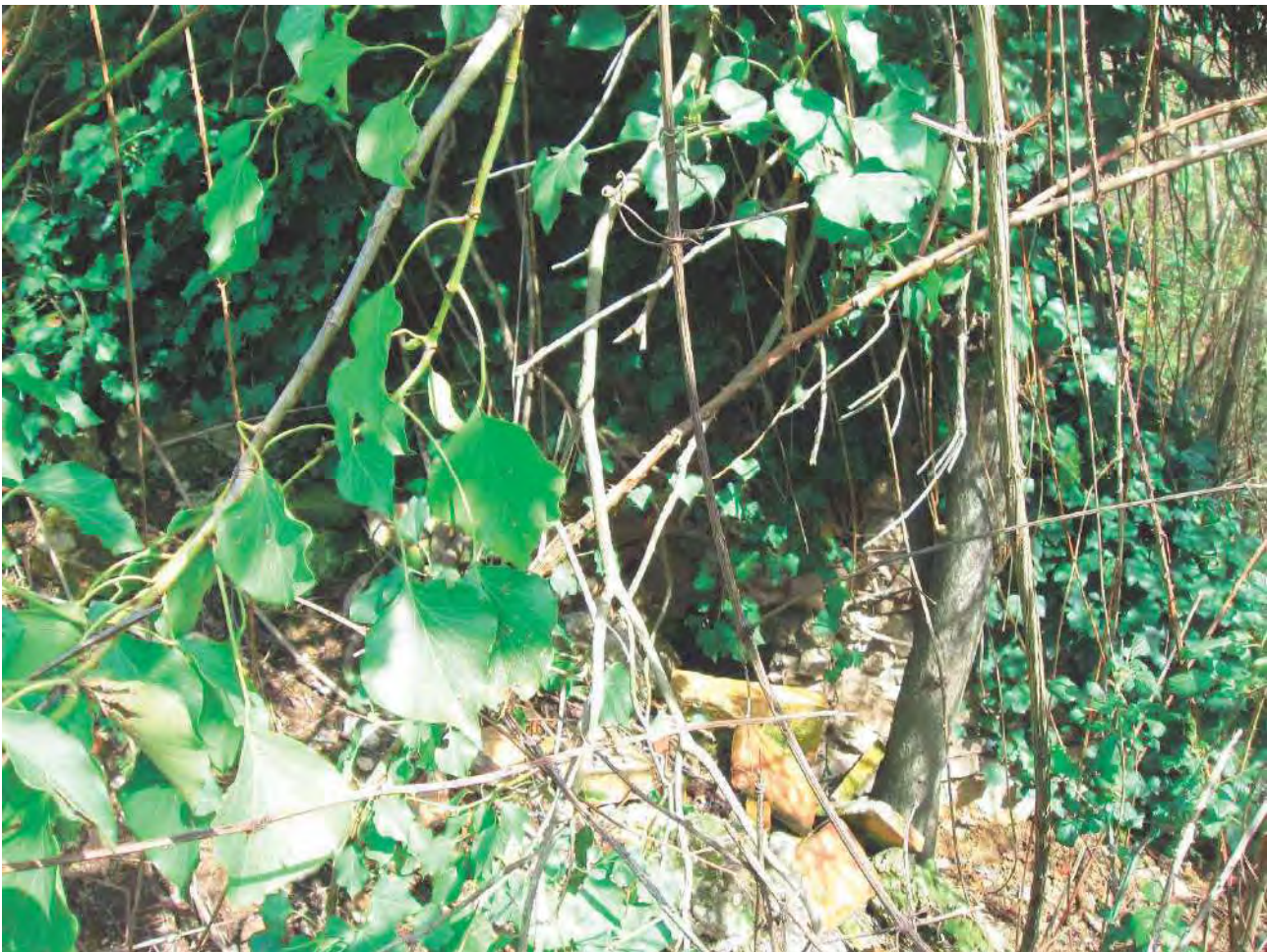
Foto 107 – Corpo 10 Fabbricato diruto – particolare muri rimanenti nella macchia
