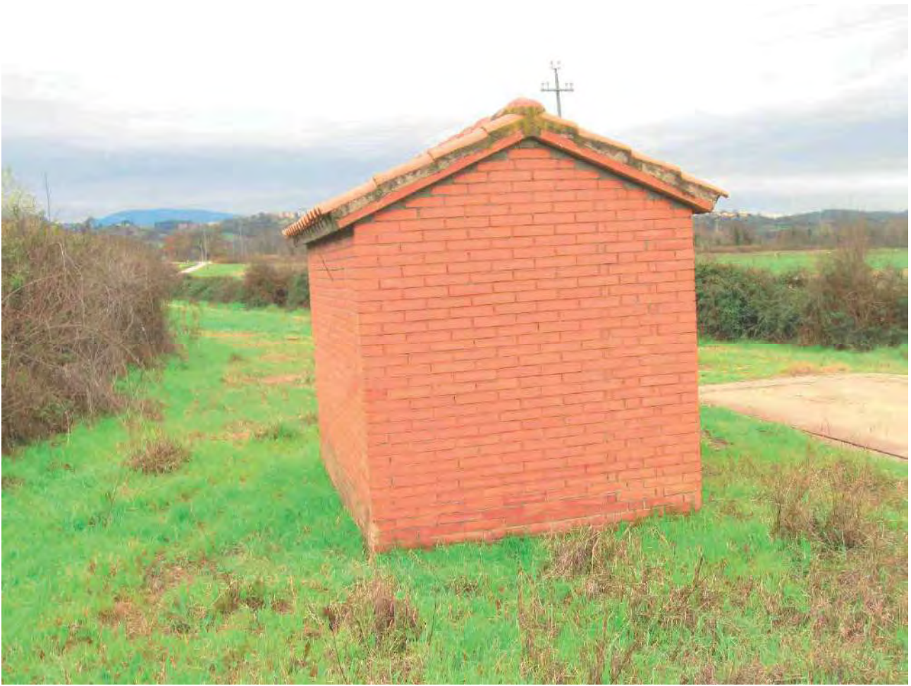
Foto 118 – Corpo 13 Bascula – locale di pesa prospetto posteriore
