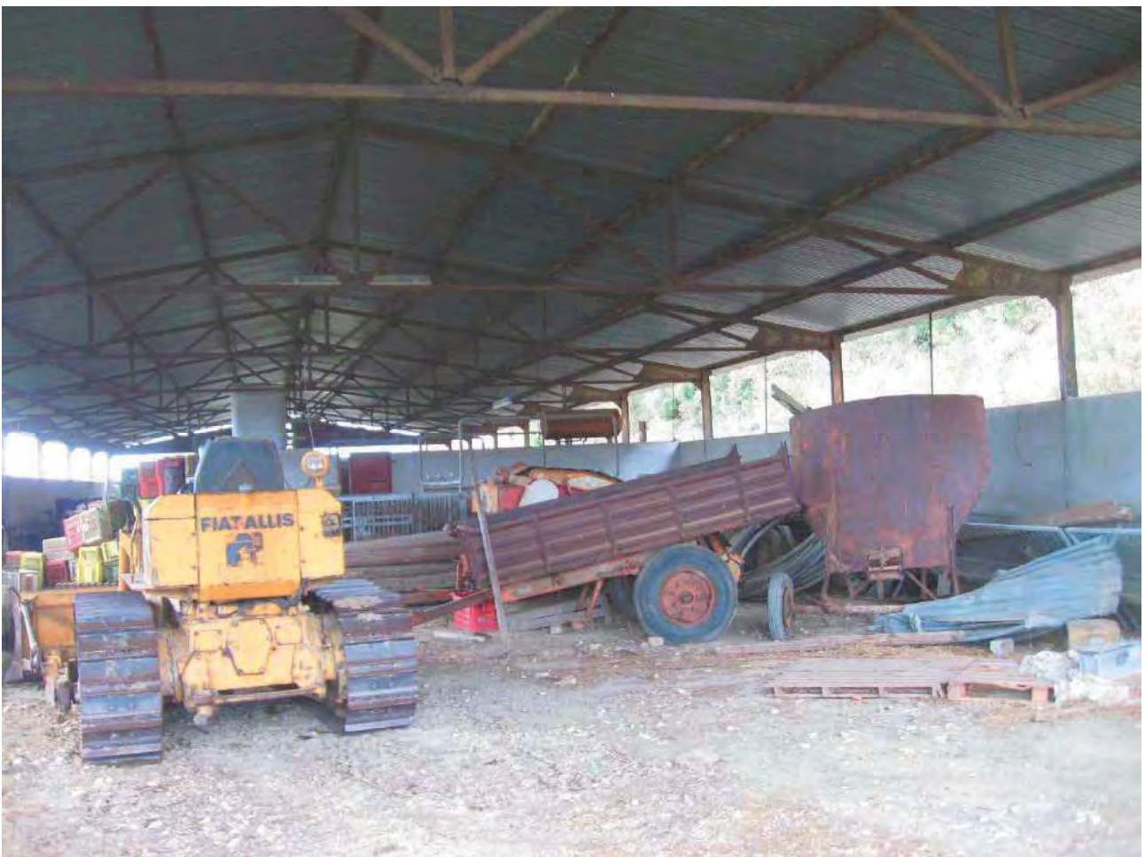
Foto 97 – Corpo 6 stalla – rimessa attrezzi – particolare interno
