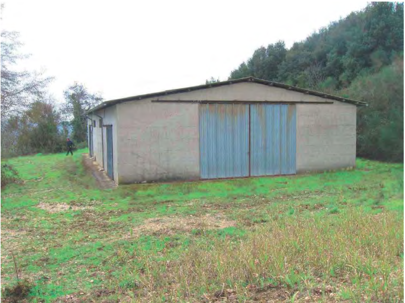
Foto 89 – Corpo 5 rimessa attrezzi prospetto posteriore
