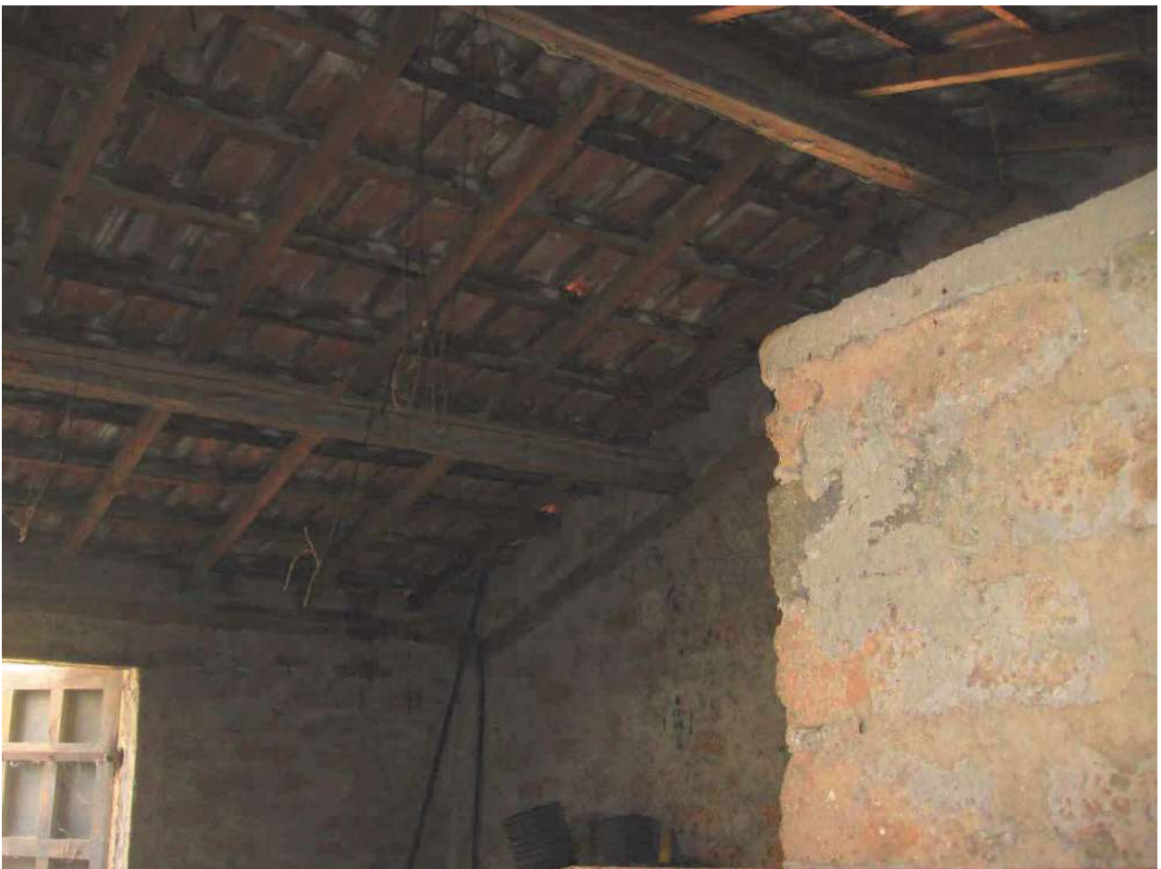
Foto 26 – Corpo 1A – particolare interno rimessa attrezzi
