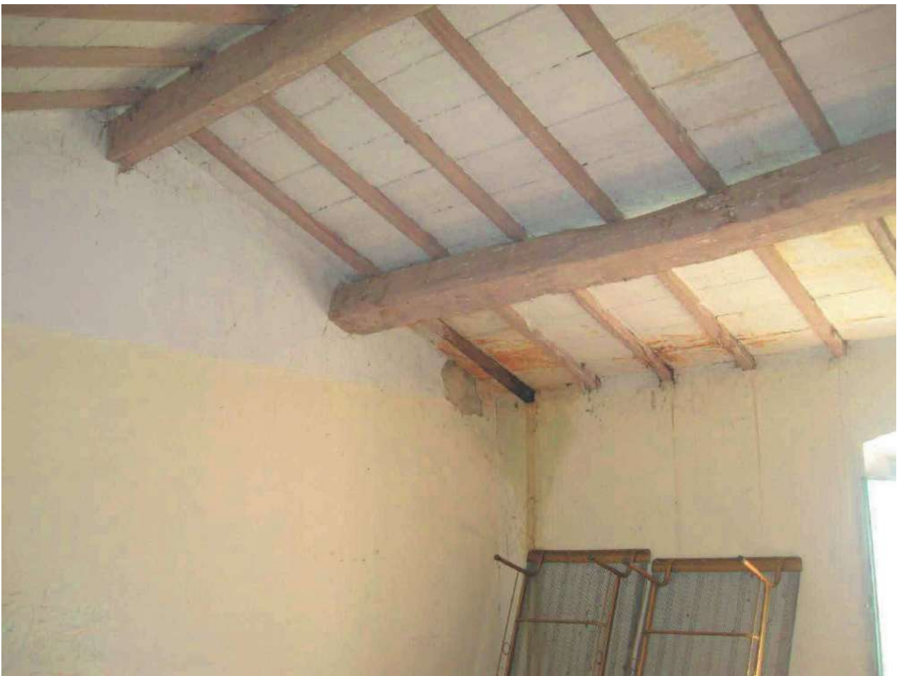
Foto 76 – Corpo 3 particolare copertura
