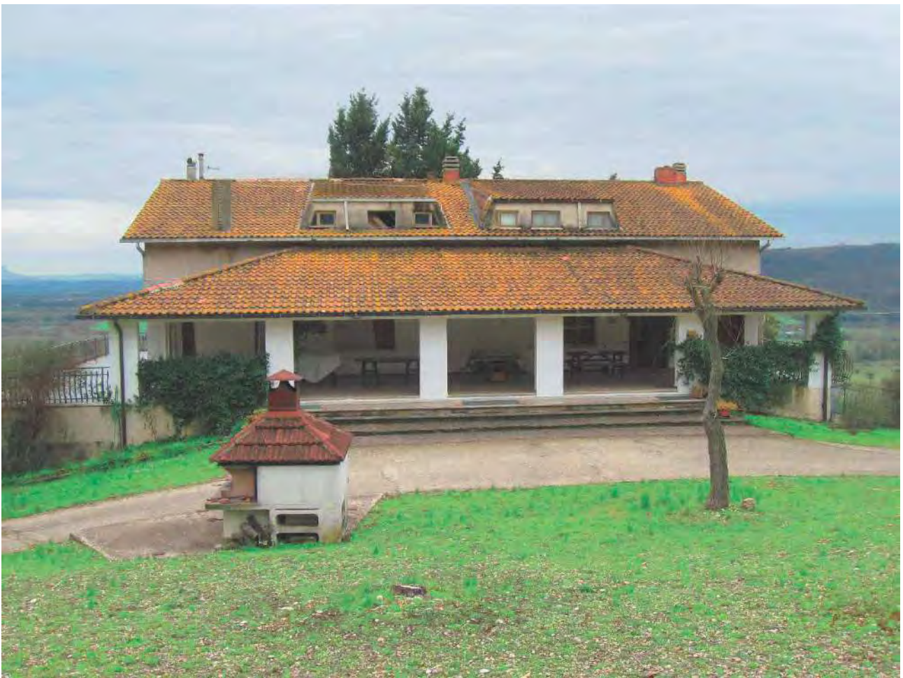
Foto 39 – Corpo 2A prospetto frontale
