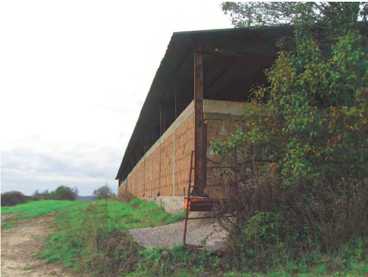
Foto 94 – Corpo 6 stalla – rimessa attrezzi – prospetto laterale
