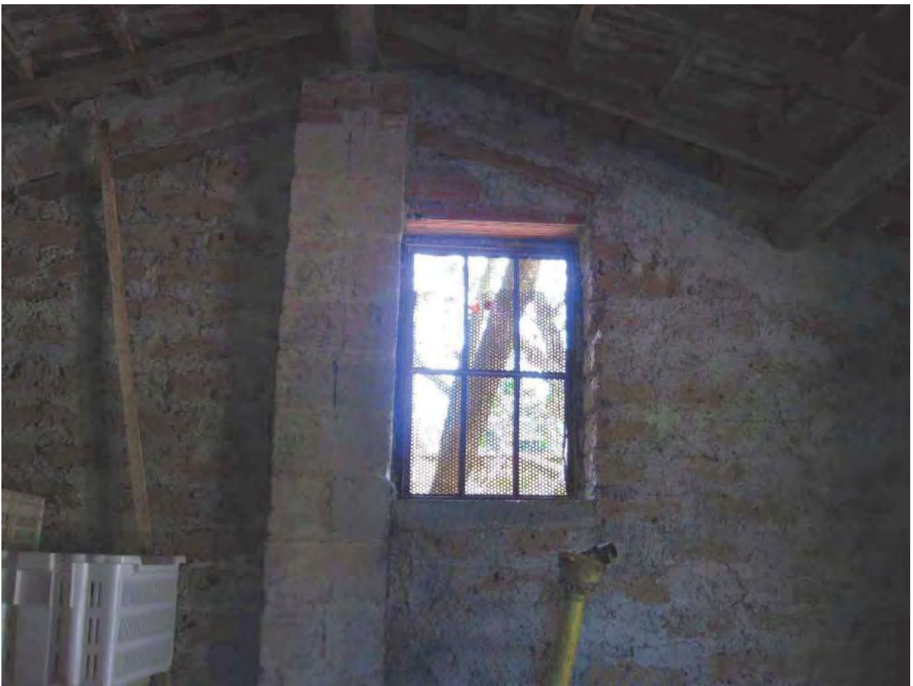
Foto 25 – Corpo 1A – particolare interno rimessa attrezzi
