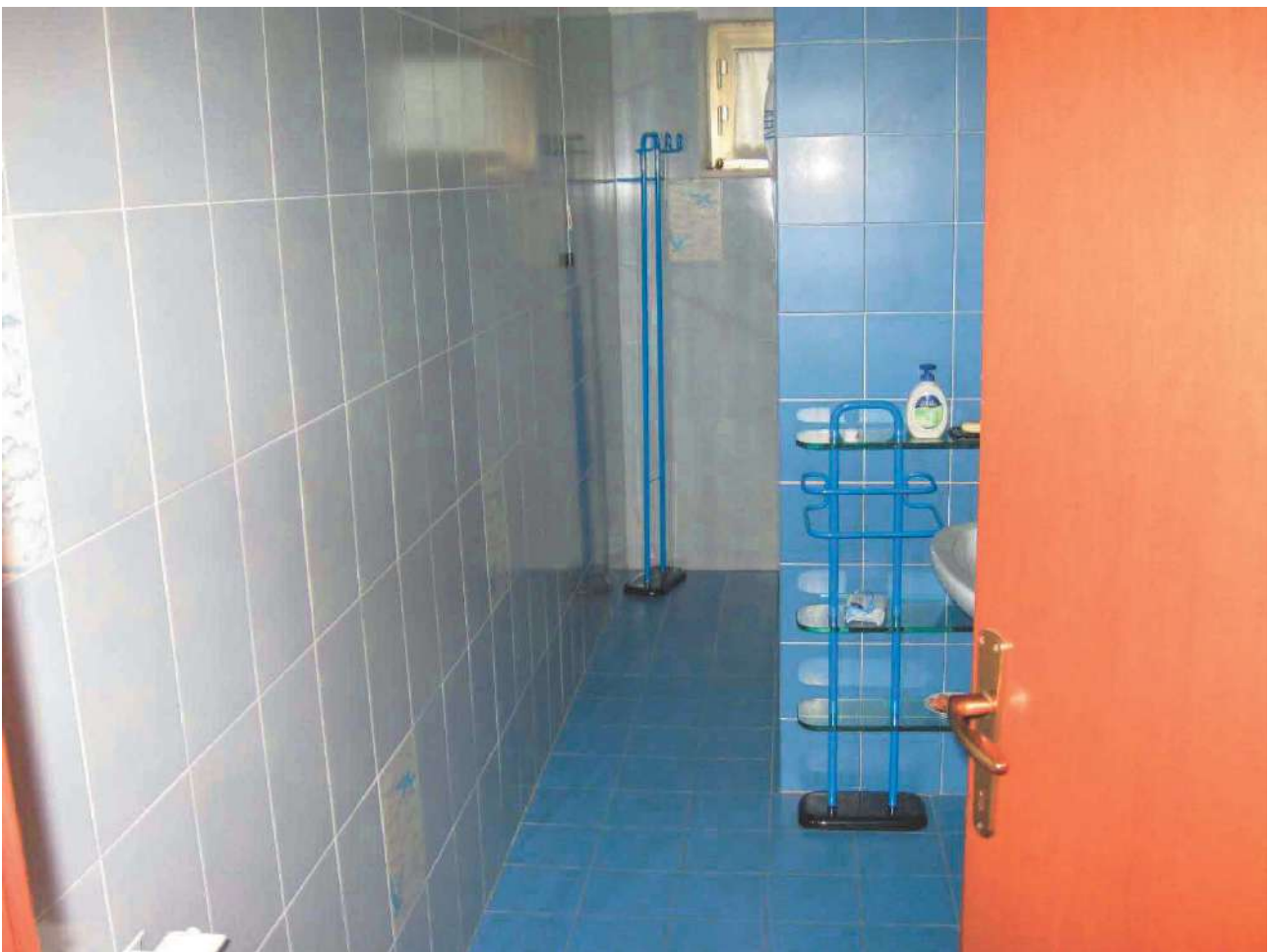
Foto 44 – Corpo 2A particolare bagno
