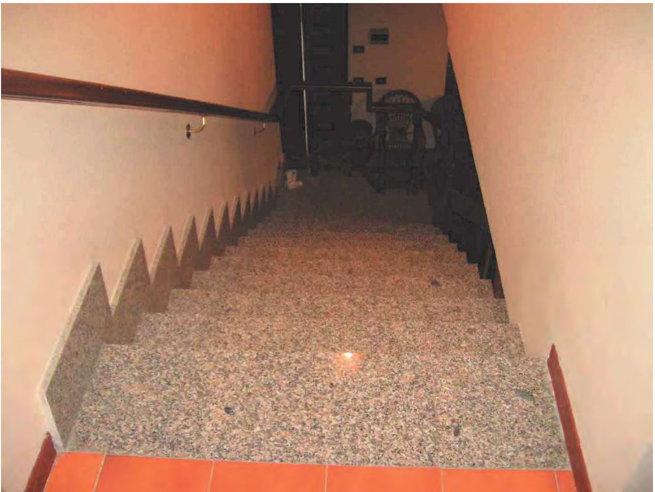
Foto 45 – Corpo 2A particolare scala interna
