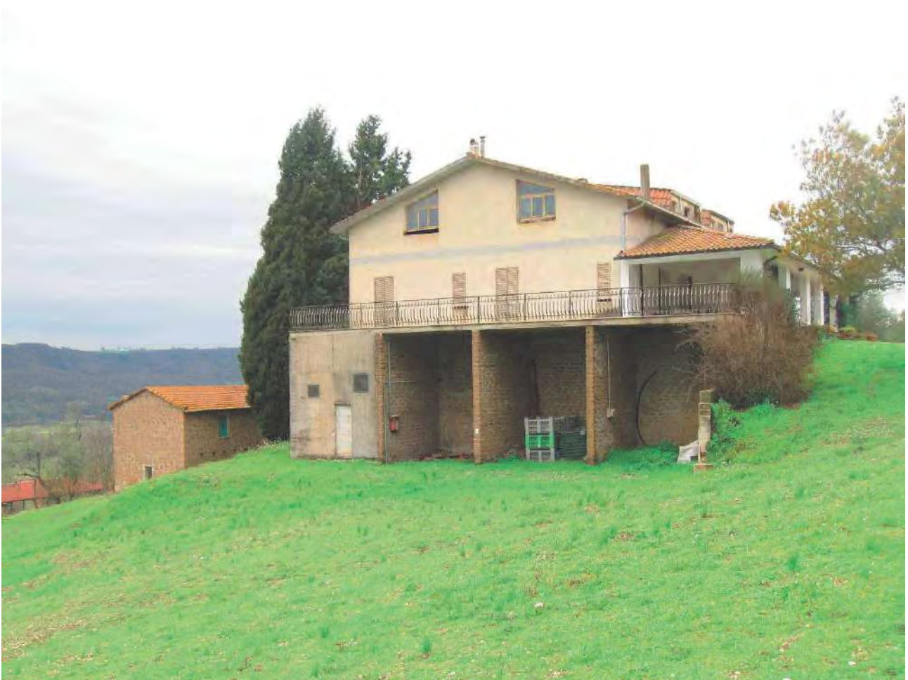
Foto 40 – Corpo 2A prospetto laterale
