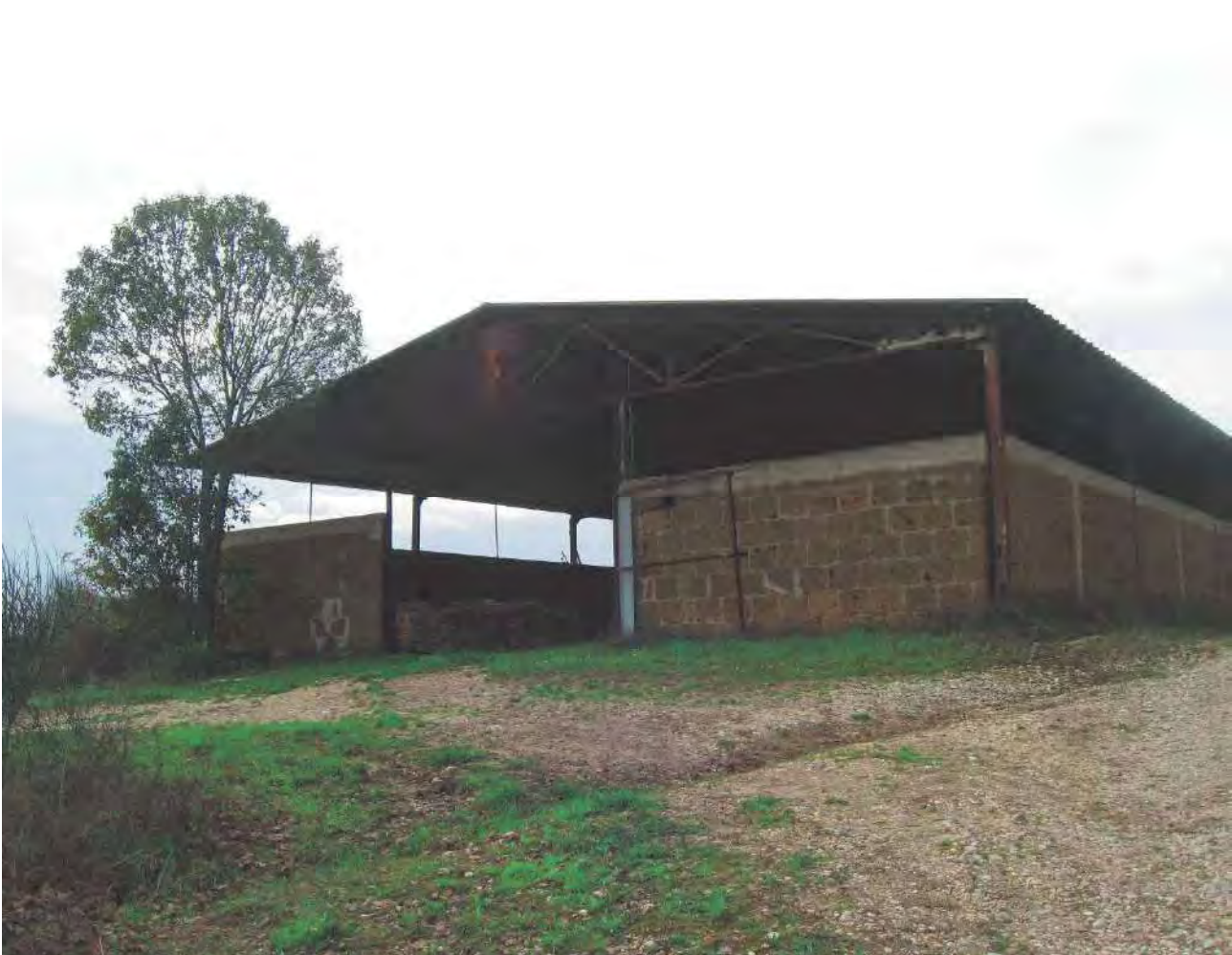
Foto 93 – Corpo 6 6 stalla – rimessa attrezzi – prospetto posteriore
