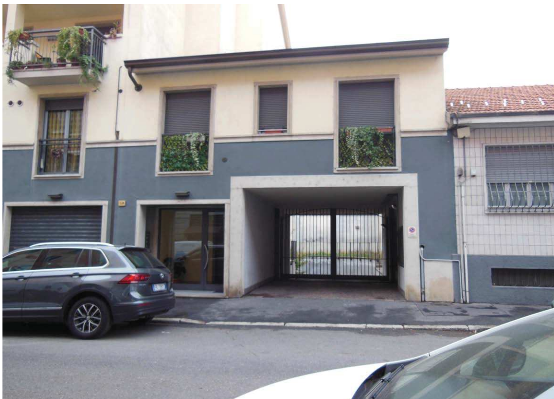
Foto 2: Accessi pedonale e carraio
