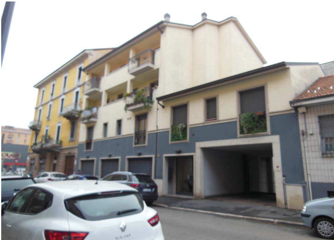
Foto 1: prospetto su Via Toselli
