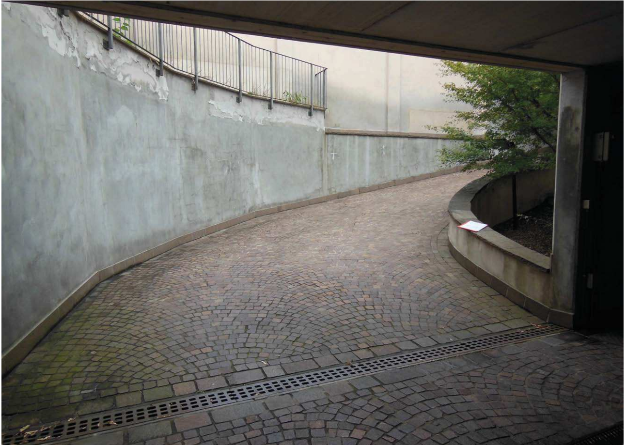
Foto 5: rampa d'accesso ai boxes
