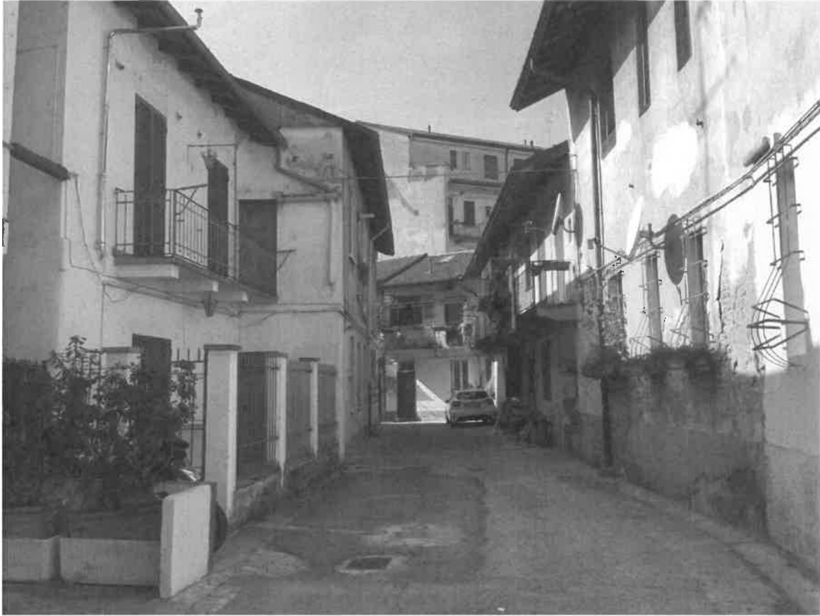
Foto 05 - Il fabbricato dalla corte interna comune
