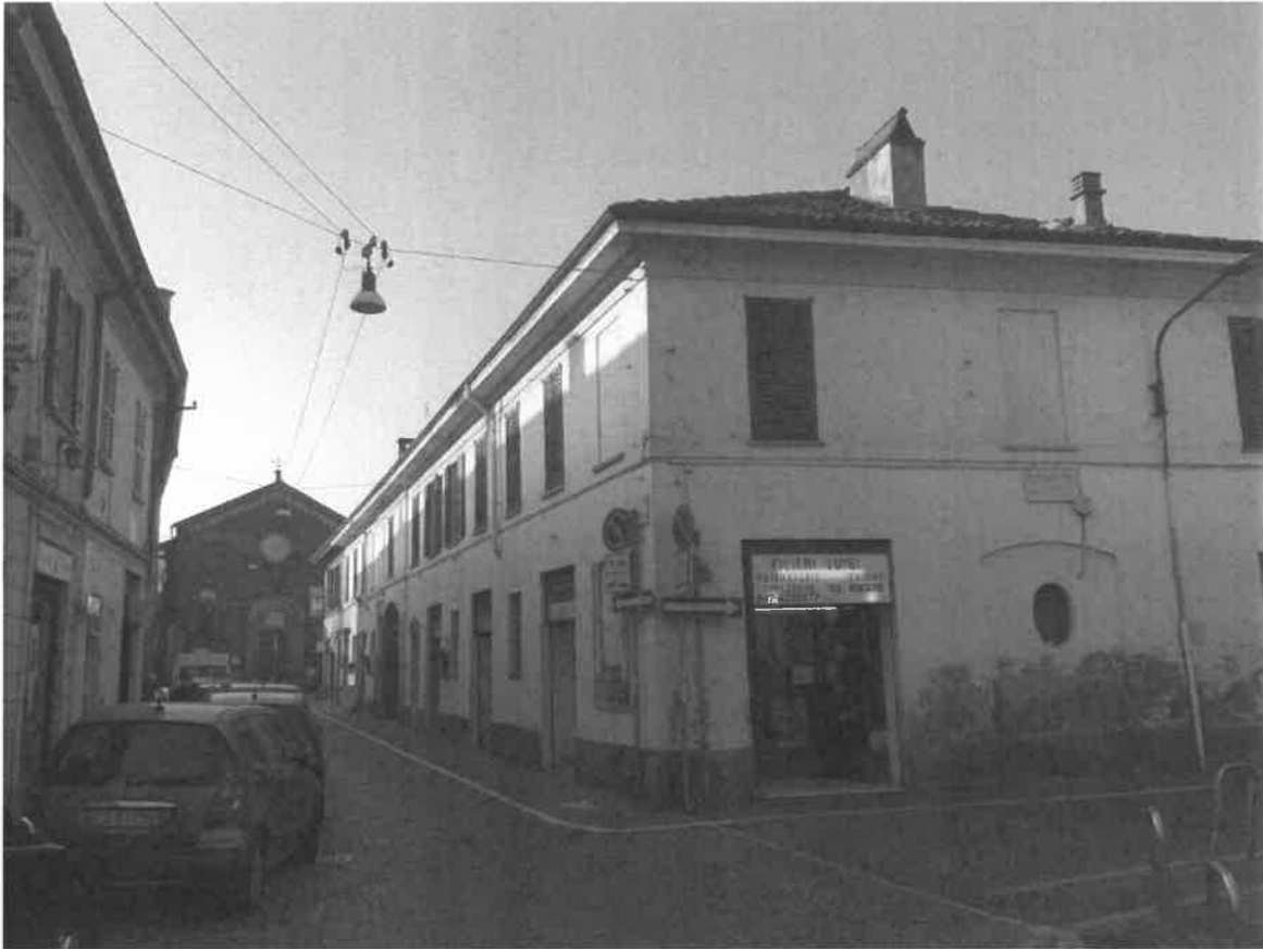
Foto 01 - L'edificio su via delle Forze Armate
