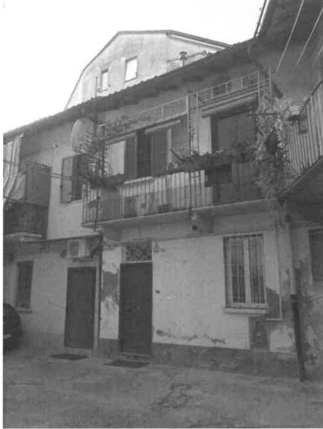
Foto 07 - Facciata del fabbricato
