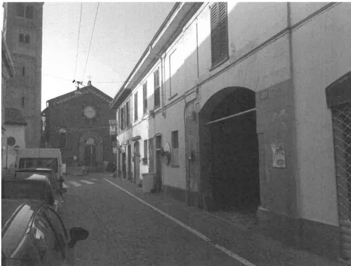
Foto 03 - L'edificio su via delle Forze Armate
