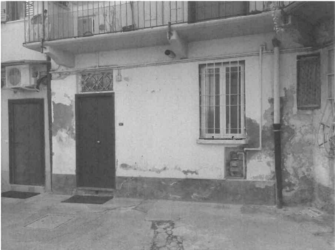
Foto 06 - Facciata del fabbricato con l'ingresso dell'unità
