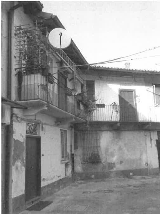
Foto 08 - Facciata del fabbricato
