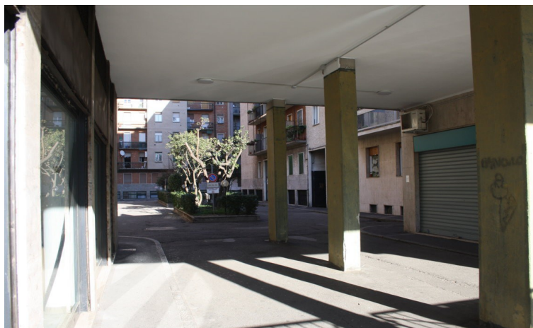
edifici interni al cortile
