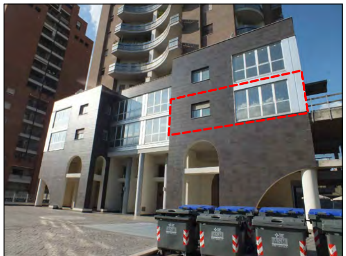
Foto n.ro 4 Prospetto Sud
