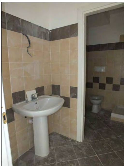
Foto n.ro 15 Anti Bagno
