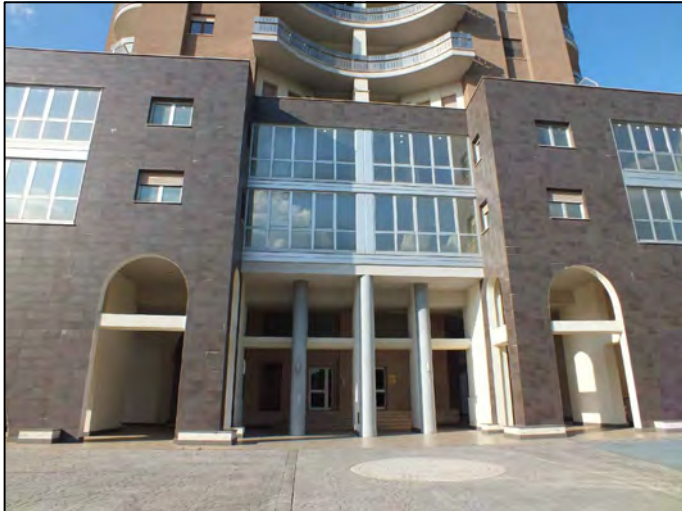
Foto n.ro 1 Ingresso lato Via Giandimartalo di Vitalone
