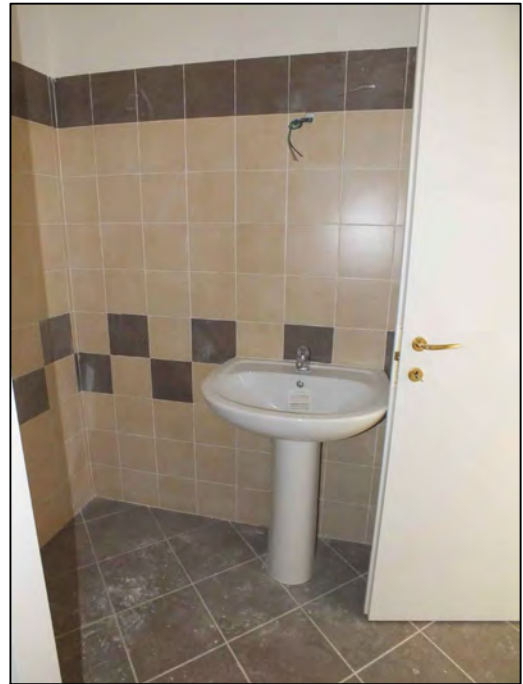
Foto n.ro 10 Anti Bagno
