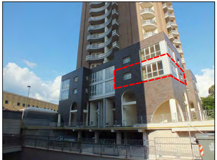
Foto n.ro 4 Prospetto Ovest
