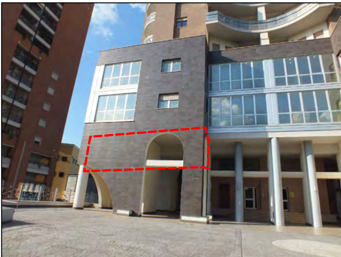
Foto n.ro 3 Prospetto Ovest
