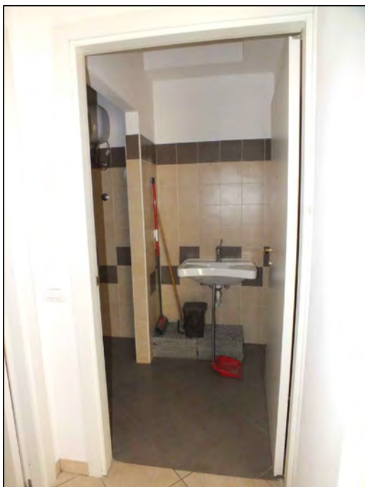
Foto n.ro 19 Anti Bagno
