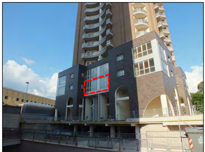
Foto n.ro 4 Prospetto Ovest
