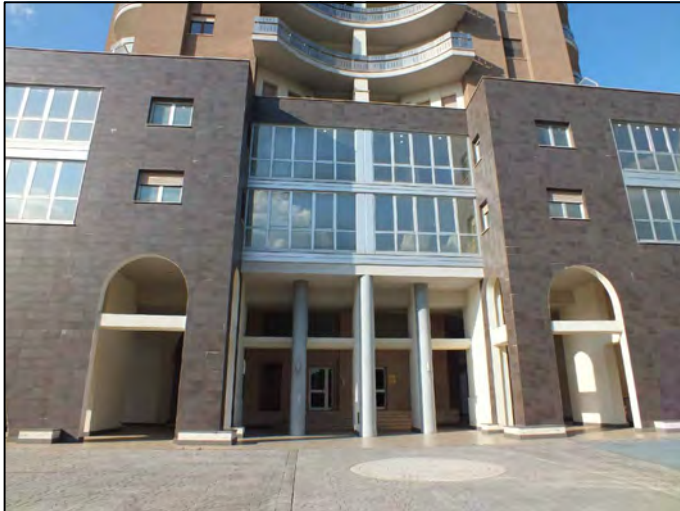
Foto n.ro 1 Portone condominiale d'ingresso
