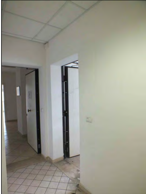
Foto n.ro 5 Ingresso dal disimpegno condominiale
