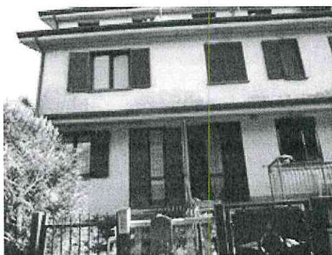
Facciata su strada
