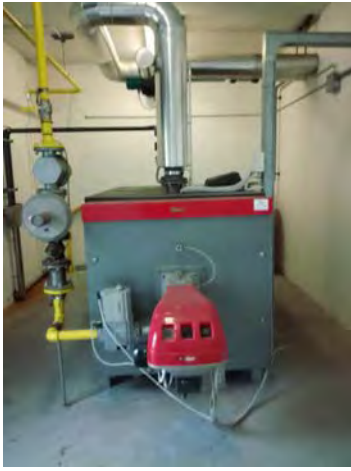
[89] RIELLO Caldaia in acciaio RTQ 896 3SLD.JPG
