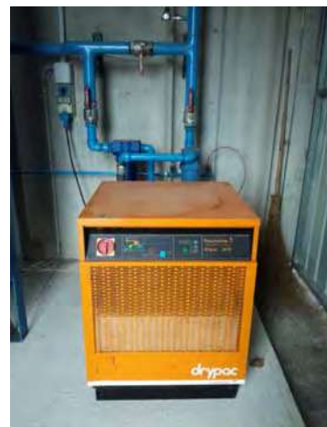
[40] Compressore PNEMOFORE DRYPAC GRUPPO ESSICATORE MOD. D...
