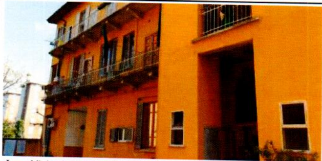
Immobile in via F.lli Albertino e Martino Piazza 5 Milano: prospetto lato cortile interno
