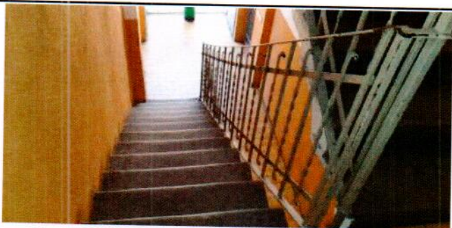
Immobile in via F.lli Albertino e Martino Piazza 5 Milano: vano scala
