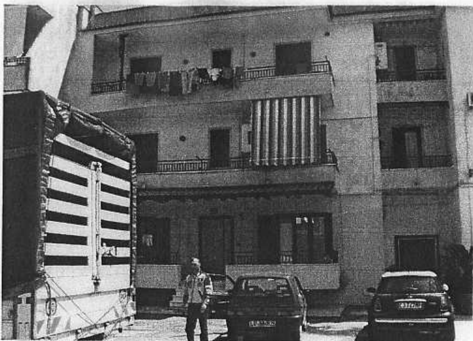
FOTO N. 02 Vista dell'appartamento dalla via Via Antonio Pacinotti
