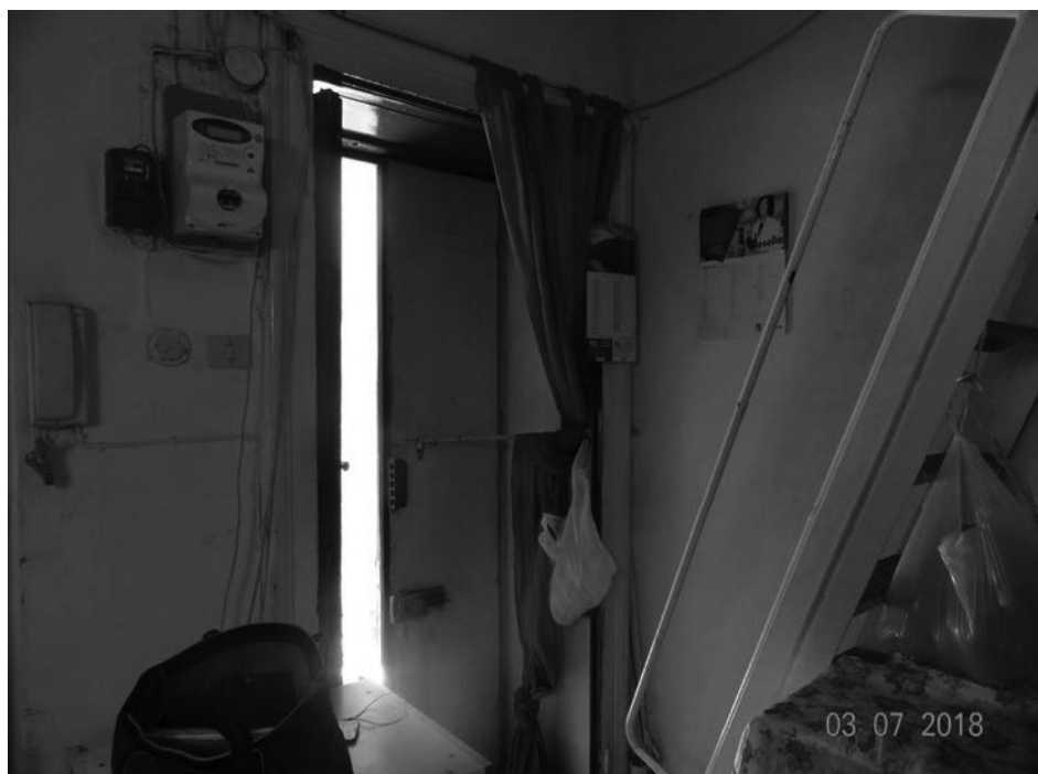
Vista interna - soggiorno/pranzo
