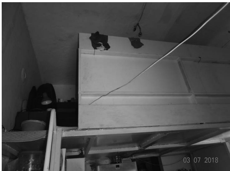
Vista interna - soppalco ricavato in una porzione del locale soggiorno/pranzo
