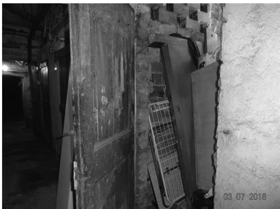
Vista esterna - cantina
