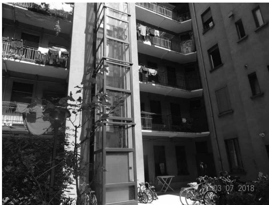
Vista esterna - ingresso unità abitativa
