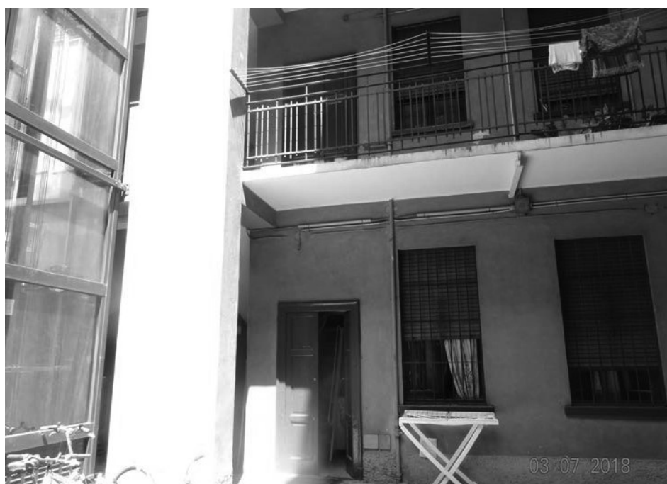
Vista esterna - ingresso unità abitativa
