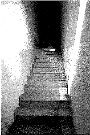
Foto 7. Rampa d'accesso al piano primo
