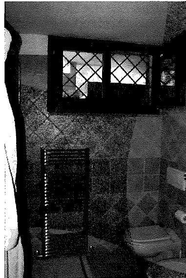
Foto 16. Bagno al piano interrato
