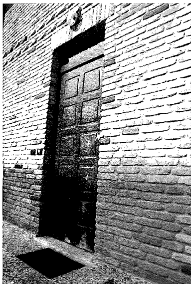
Foto 1. Porta d'accesso all'immobile
