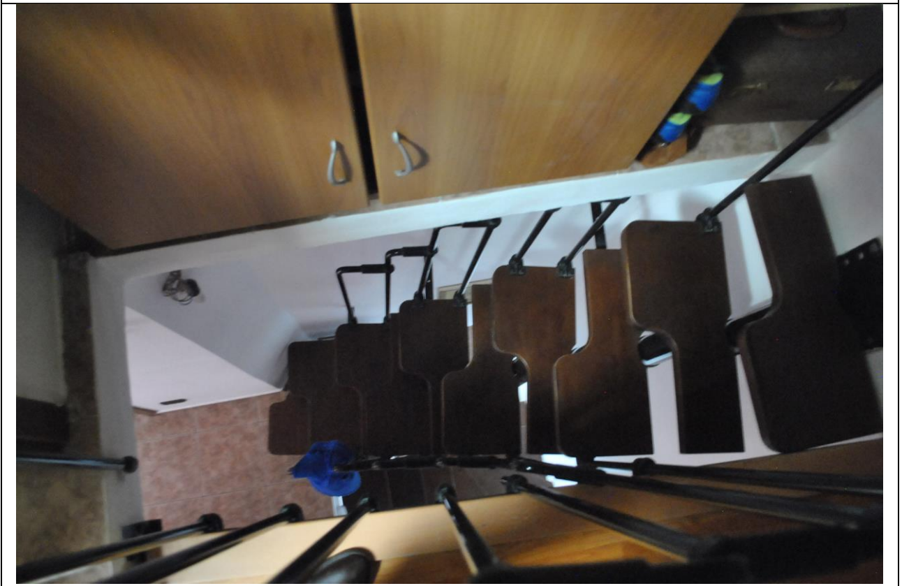
Scala di collegamento piano primo - sottotetto
