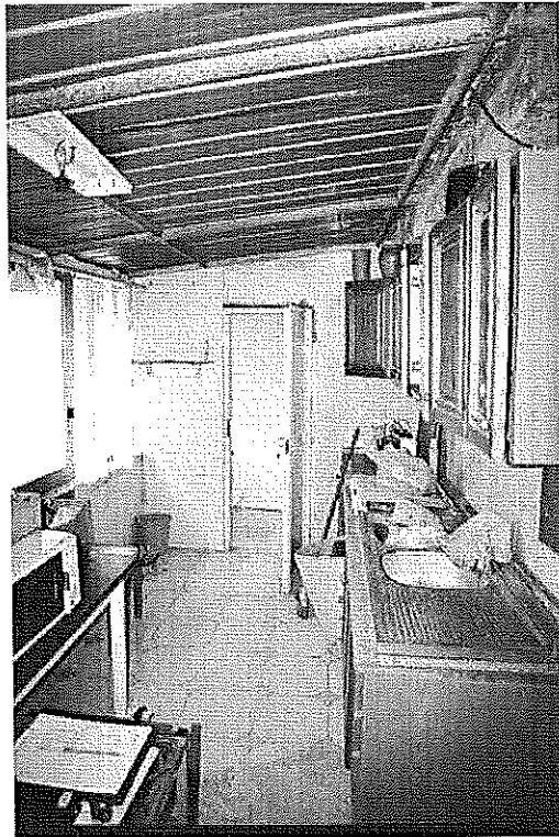
Fotografia 13 – La copertura del locale Cucina è costituita da pannelli in lamiera disposti a falda verso la strada.
