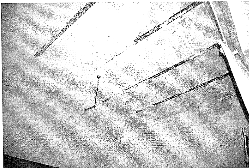
Fotografia 11 – Il solaio di copertura presenta ampi tratti privi di intonaco al soffitto.
