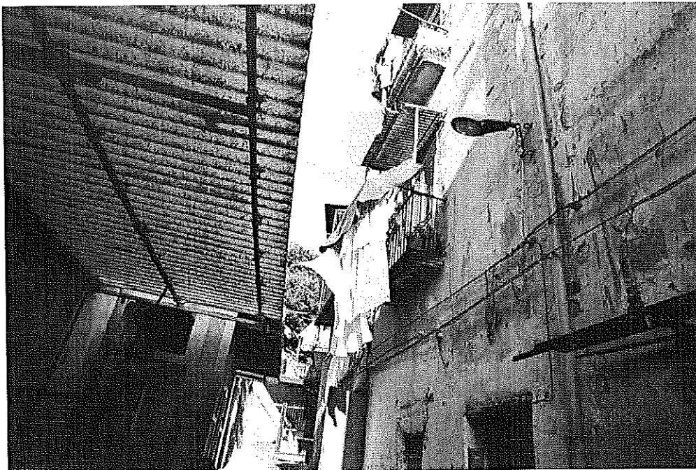
Fotografia 21 – L'immobile è dotato di balcone con accesso dal vano 1
