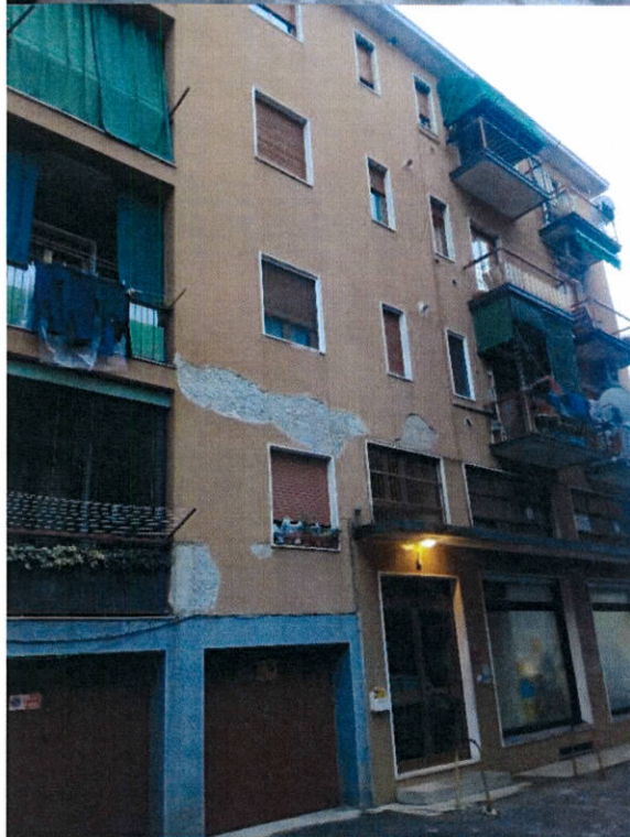
Strada accesso all'immobile
