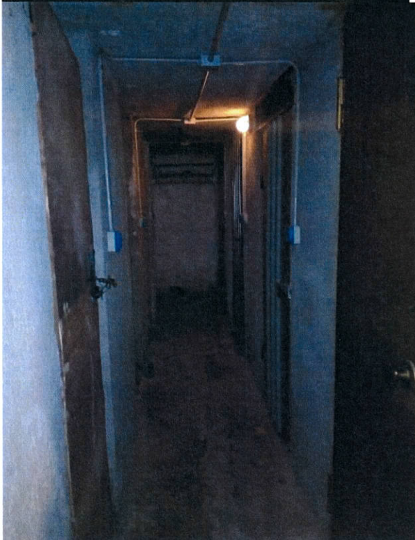
Scala accesso cantina
